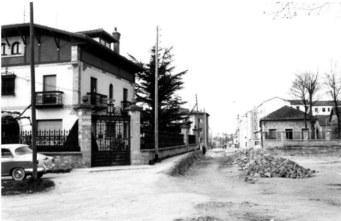
Calle Avenida Judizmendi con calle Olaguíbel. Preventorio año 1959.
