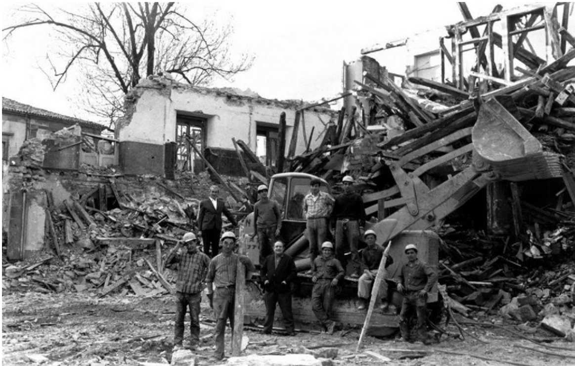
Calle Becerro Bengoa.-Demolición del Casino-Abril - Diciembre de 1968
