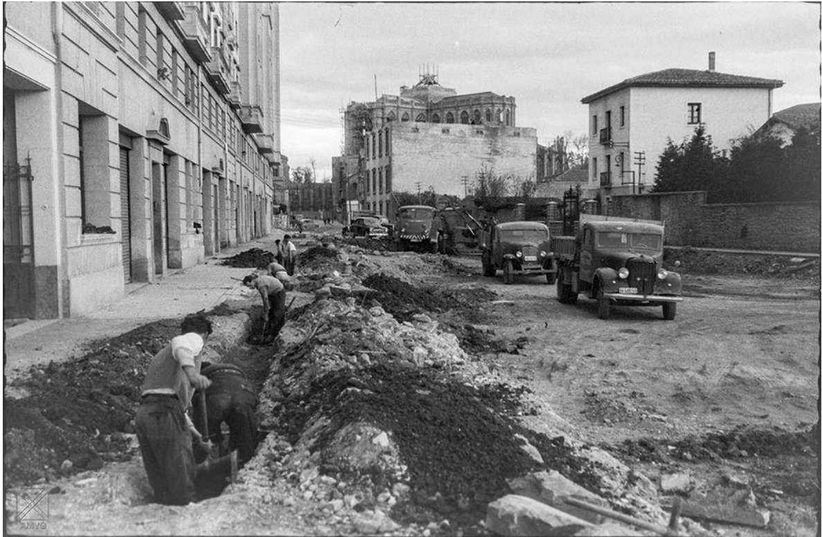
Calle Adriano VI.-1960-obra
