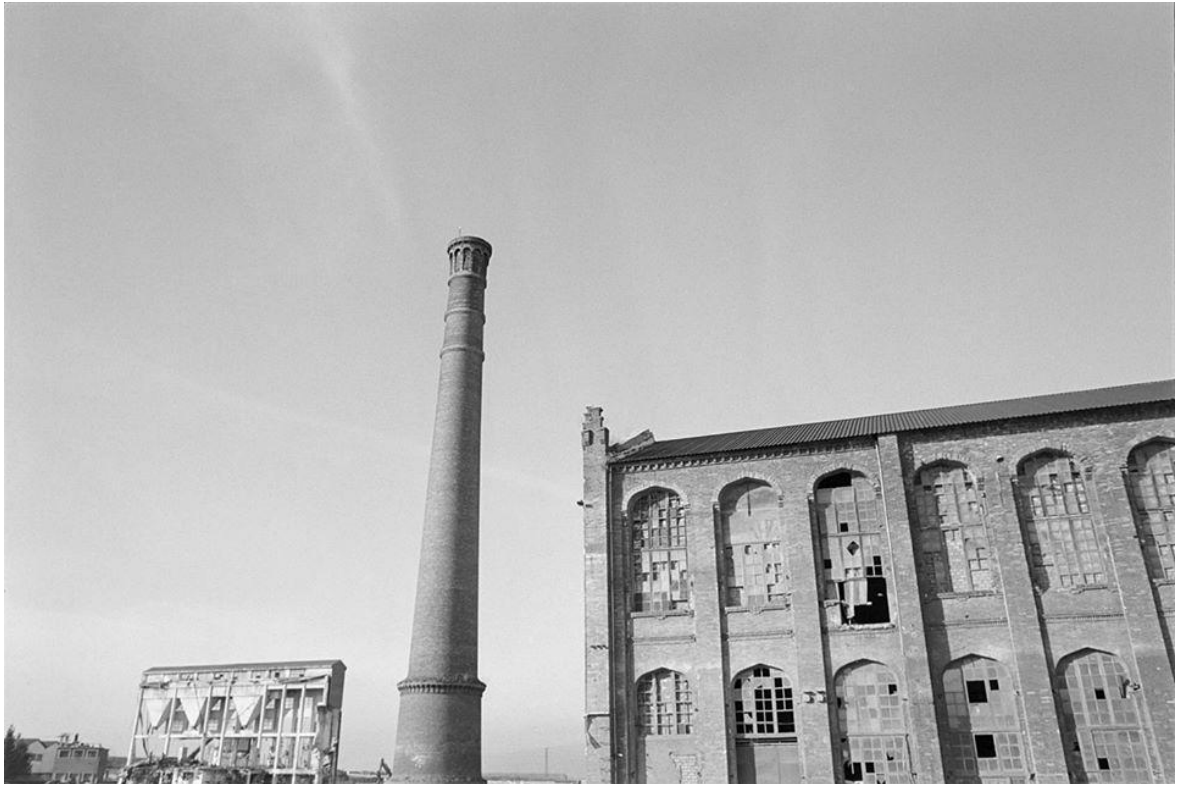
Edificios de la Azucarera Alavesa en ruinas.-29-11-1994
