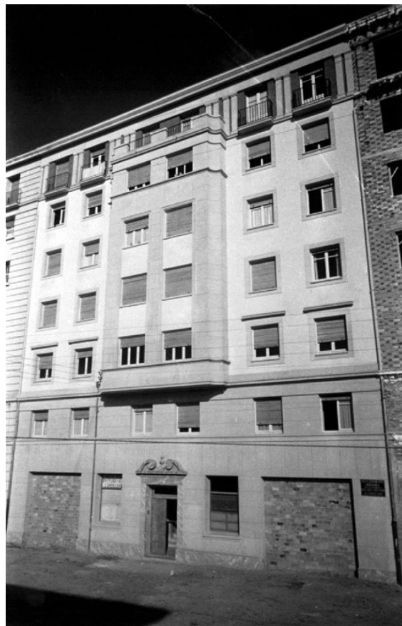
Calle Adriano VI-Edificio de viviendas- 4-1955
