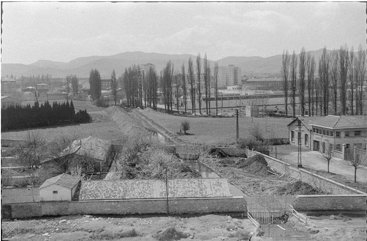
Calle Abendaño-canal del río Abendaño.-24-3-1961
