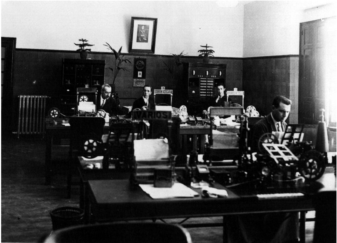
Oficina de Correos y Telégrafos
