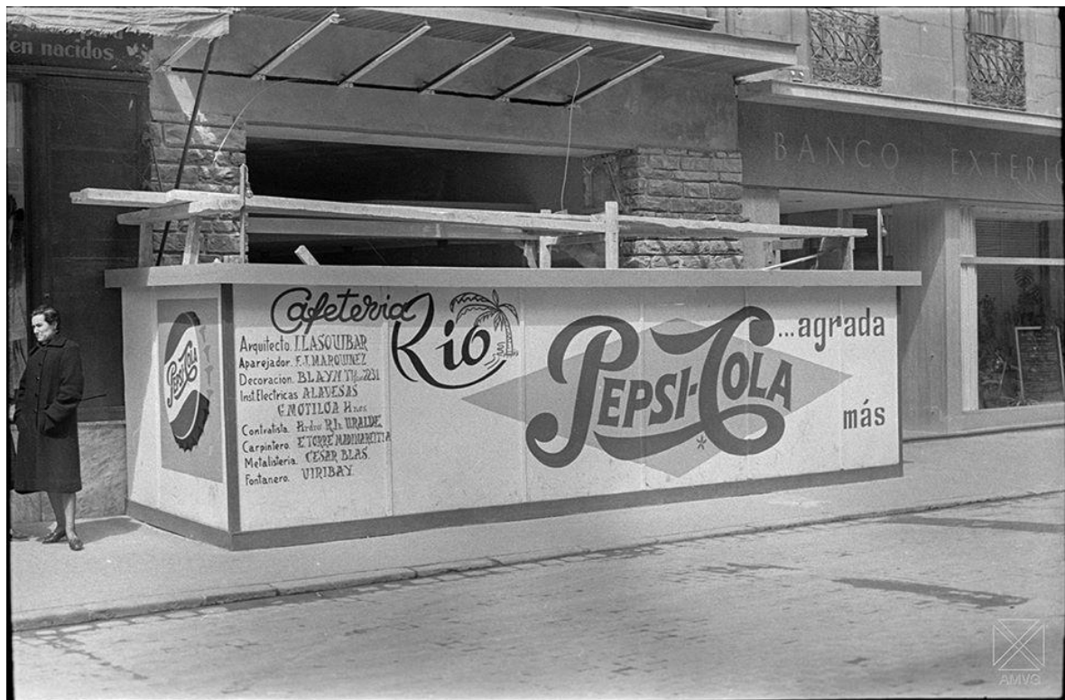
Cafetería Río en construcción. 1960
