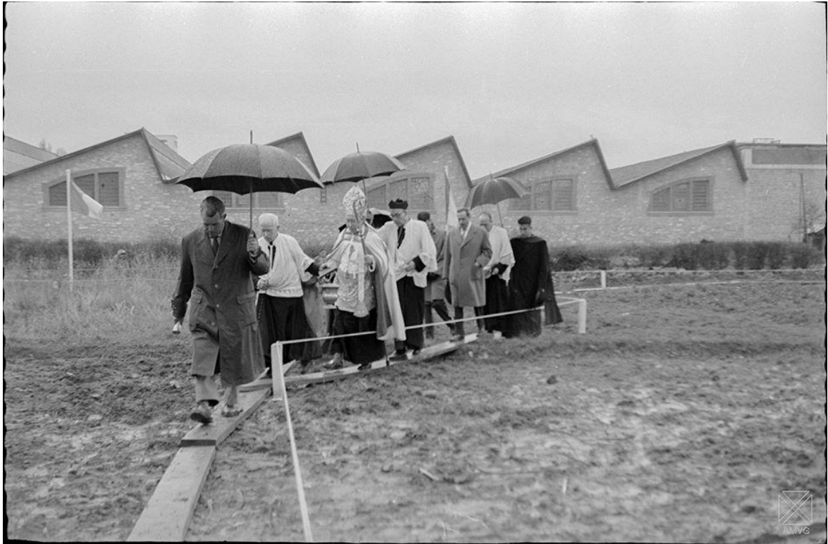
Colocación de la primera piedra de la iglesia de Los Ángeles.19-3-1957
