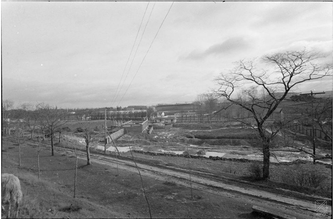
La Sociedad Deportiva Estadio en construcción.-1958
