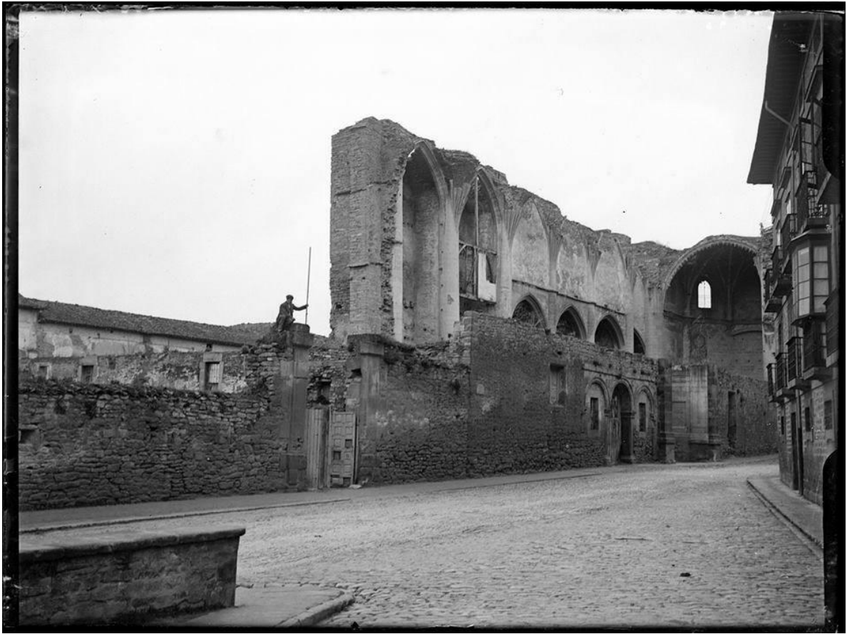
Convento de santo domingo- derribo
