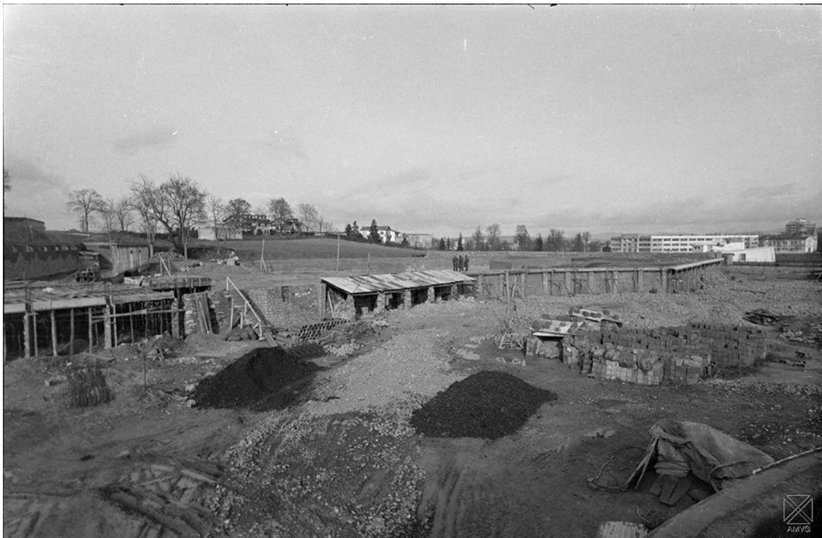
La Sociedad Deportiva Estadio en construcción.-1958
