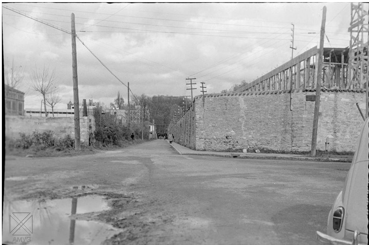
Construcción de los nuevos institutos.-21-11-1965
