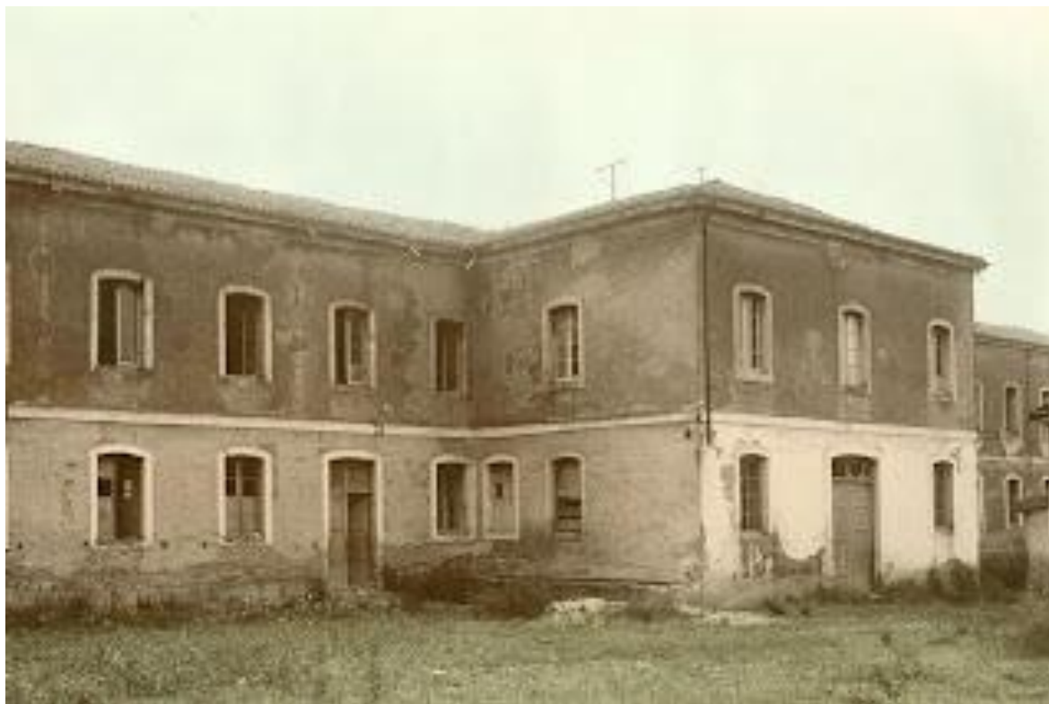
Sancho 131 cuartel caballería 1920. Terrenos del Corte Ingles Ahora.
