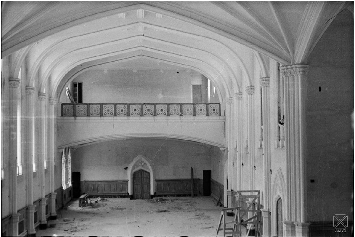
Ampliación del colegio de Santa María.06-1949
