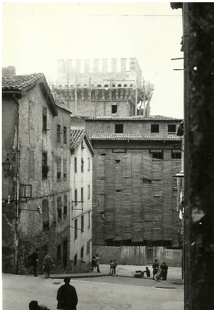
Restauración de la Torre de Doña Ochanda. (1970)
