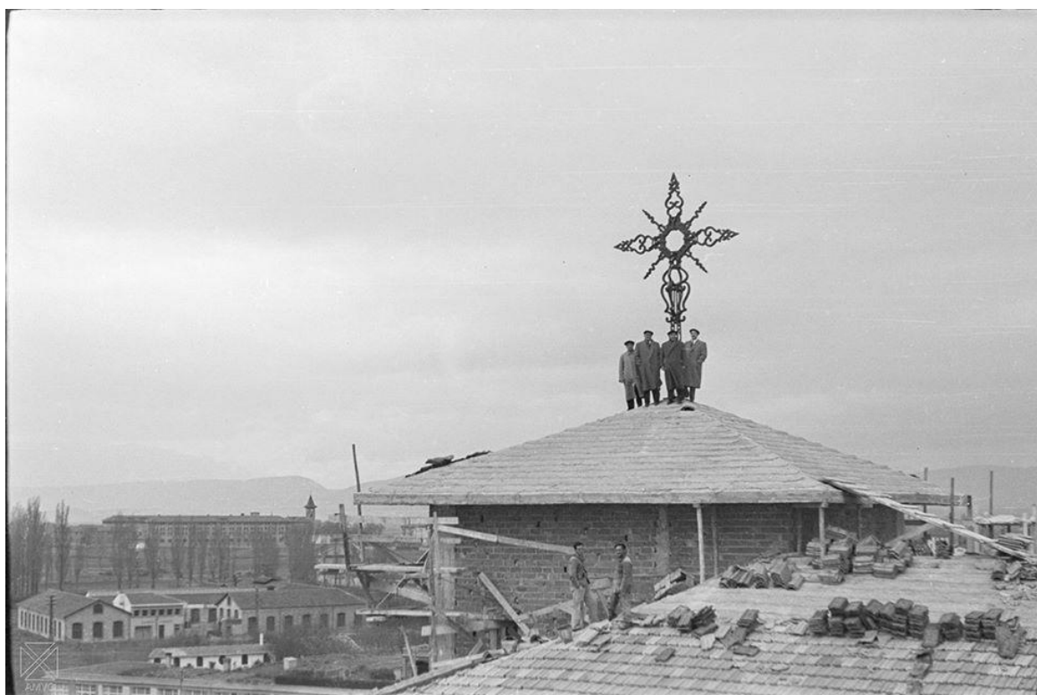
Obras de ampliación del Colegio de Santa María.-noviembre 1948
