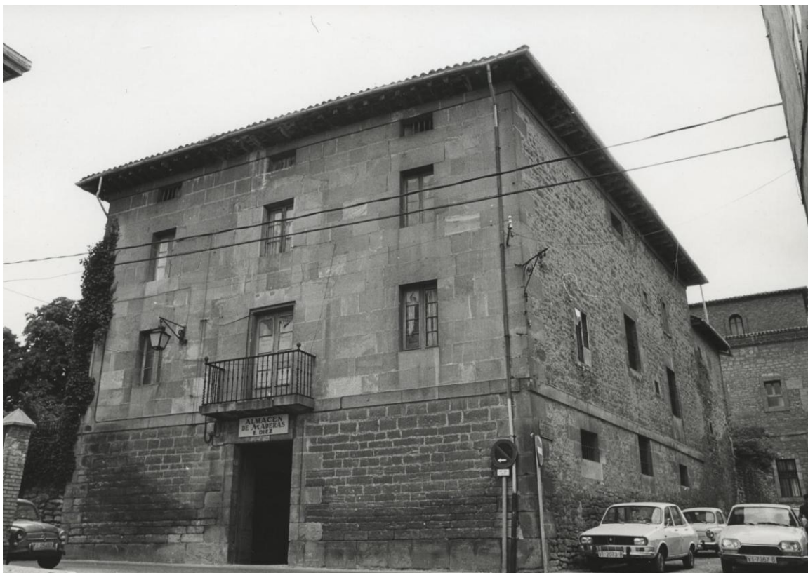
Casa de los Echanove (1980) cuando era un almacén de maderas.
