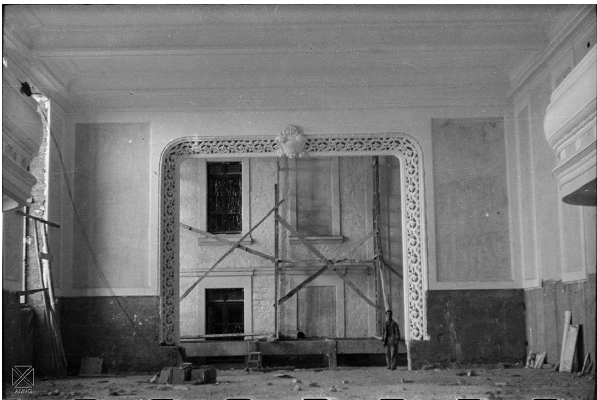
Ampliación del colegio de Santa María.12-1948
