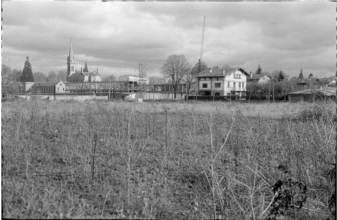
Construcción de los nuevos institutos.21-11-1965
