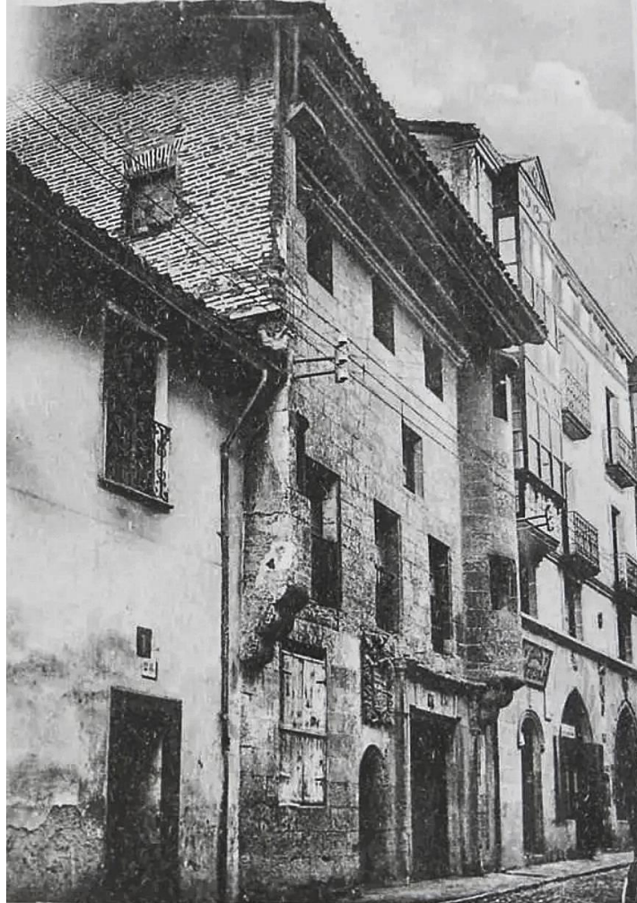
Casa de los Cubos. Librería General.( Hacia 1920)
