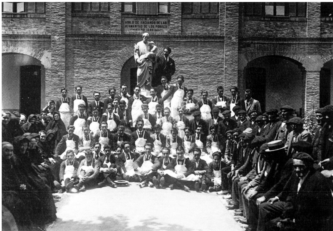
Asilo de las Hermanitas de los Pobres
