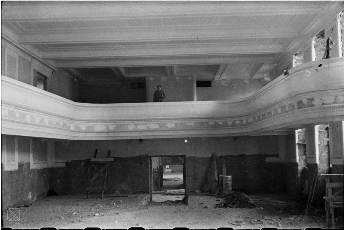
Ampliación del colegio de Santa María.12-1948
