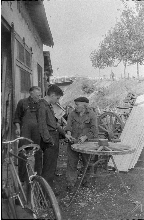
Fabricación de carros en el puente de San Cristóbal.-19-10-1962.
