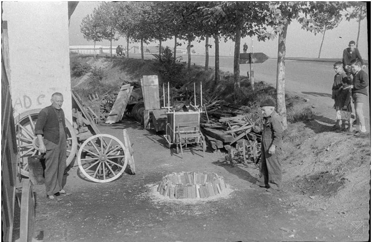
Fabricación de carros en el puente de San Cristóbal.-19-10-1962
