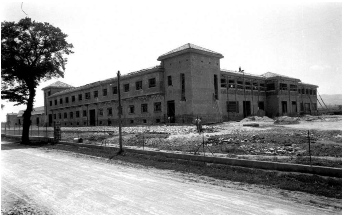
Calle Avenida de los Huetos. Imosa en construcción.
