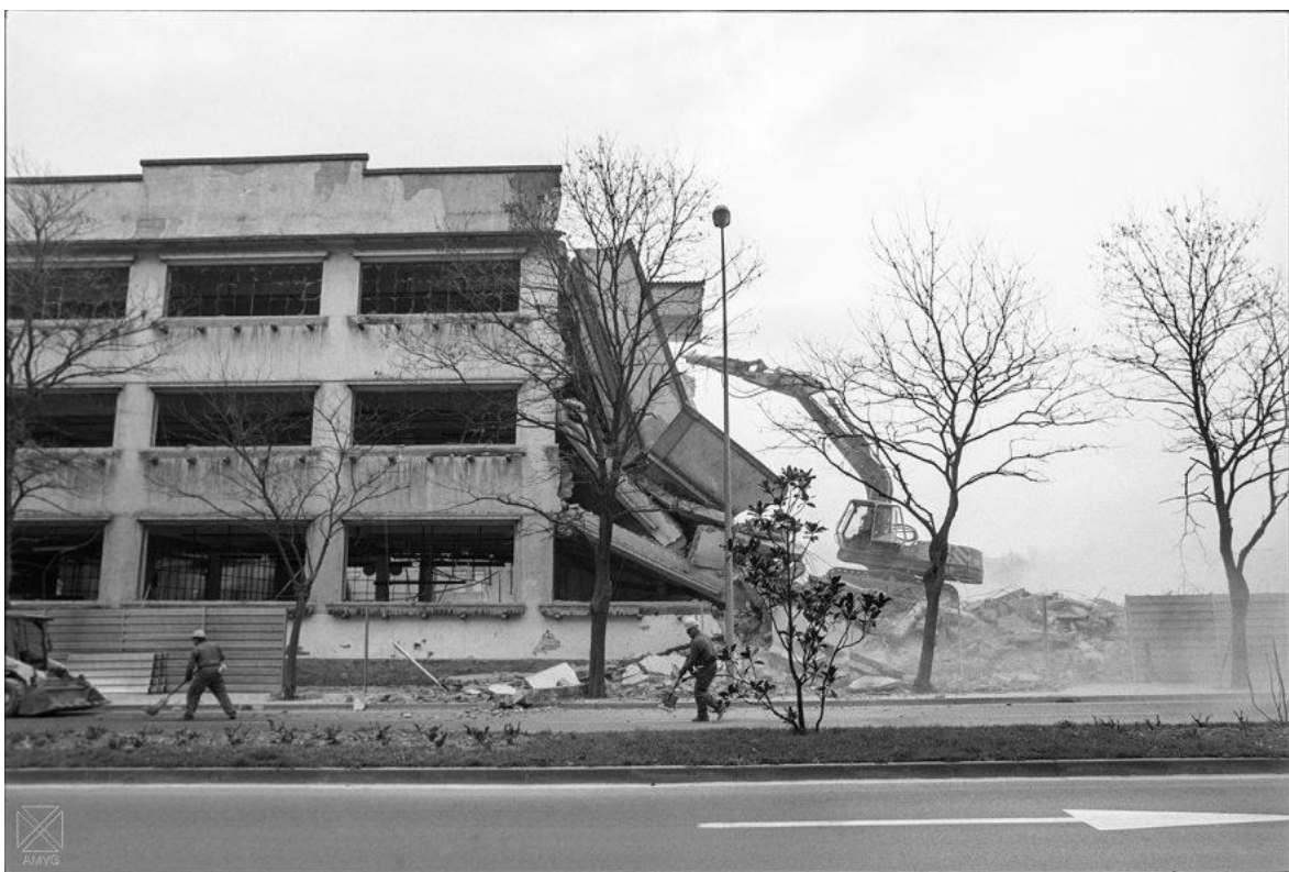
Derribo de la fábrica de Areitio en 1993. Javier Berasaluce. AMVG.
