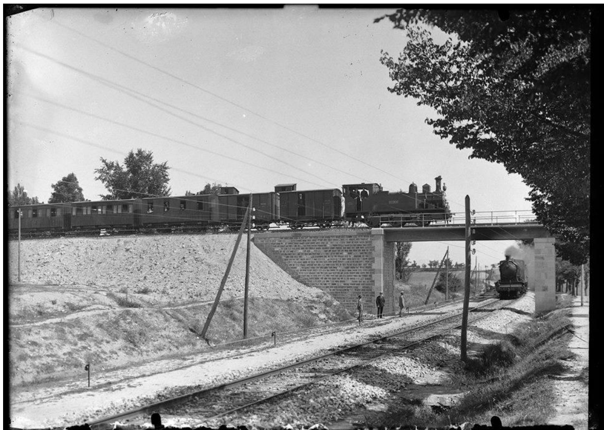
Estación del Norte y el Vasco-Navarro.
