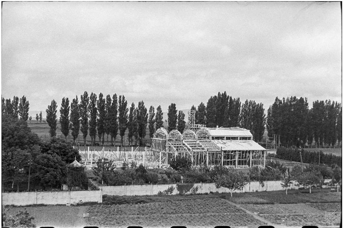
Construcción de la ampliación de la fábrica de Aranzábal.1949
