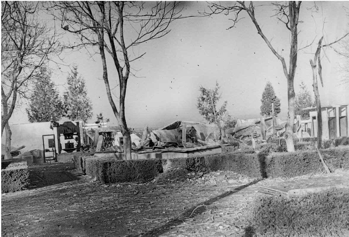
Pirotecnia de Lecea. Estado en el que quedó la fábrica tras la explosión en la que fallecieron seis trabajadores.
