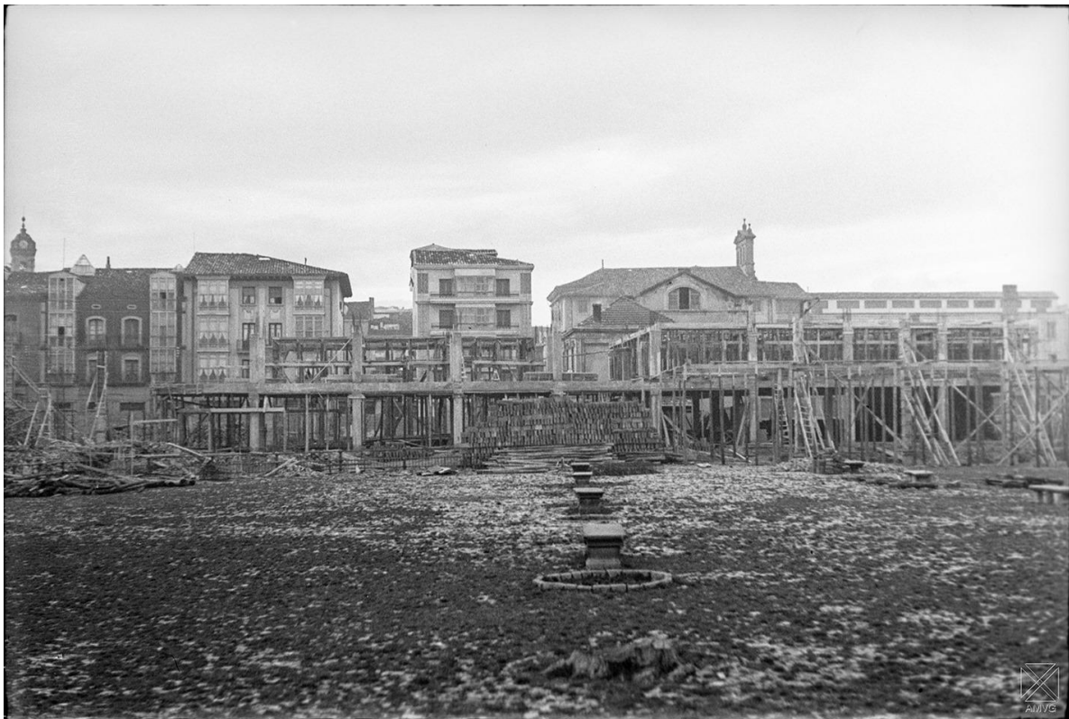
Obras de construcción de la Estación de Autobuses.-1948
