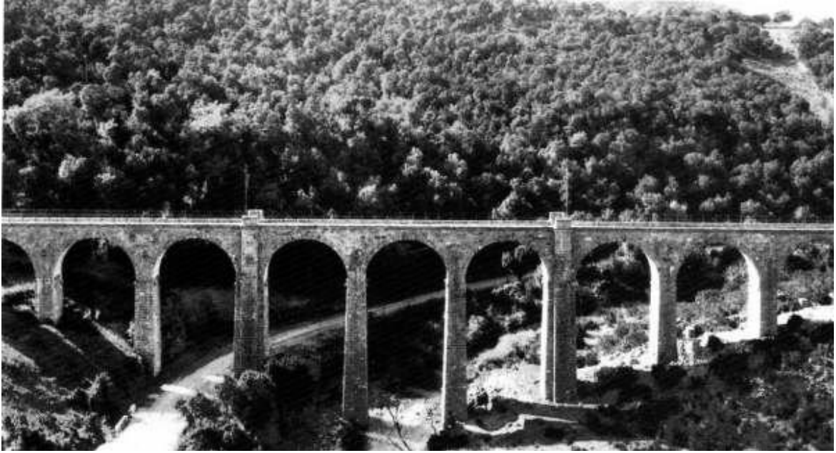
Viaducto de Arquijas
