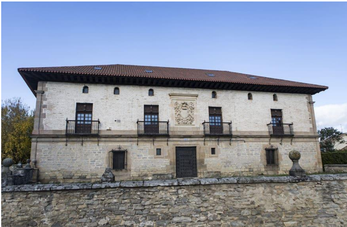
Casa-Solariega-de-Los Otazu en Zurbano.
