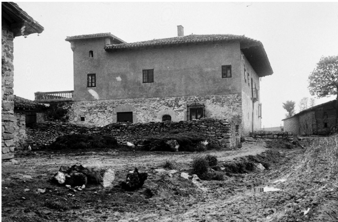
Aberásturi. Casa de los Díaz de Arcaya.-1940-60
