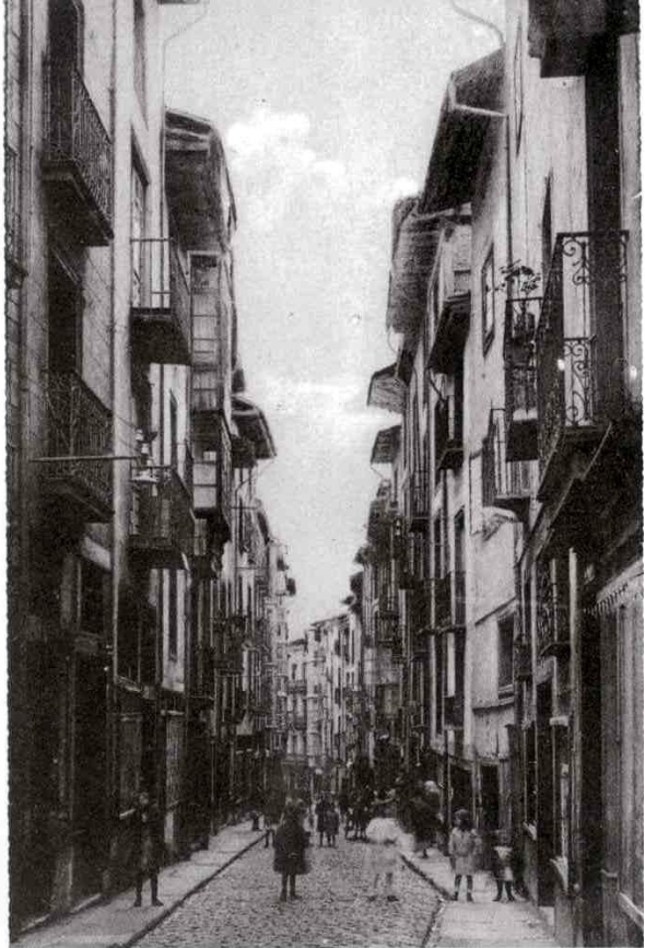
9. - CALLE DE LA CORRERIA
