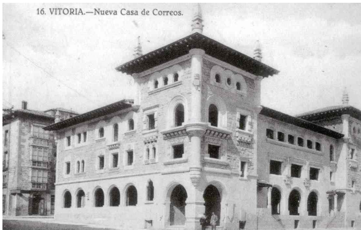
Edificio de Correos.
