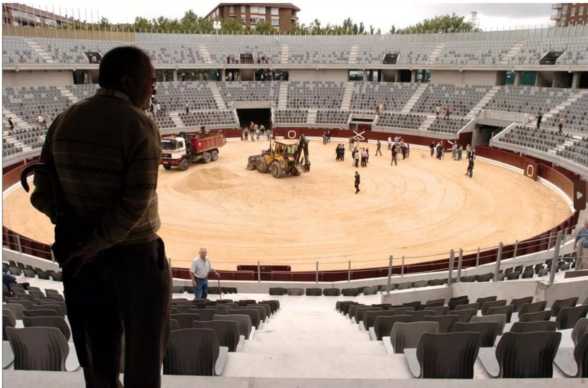
Últimas obras de la plaza de toros , Iradier Arena en 2006
