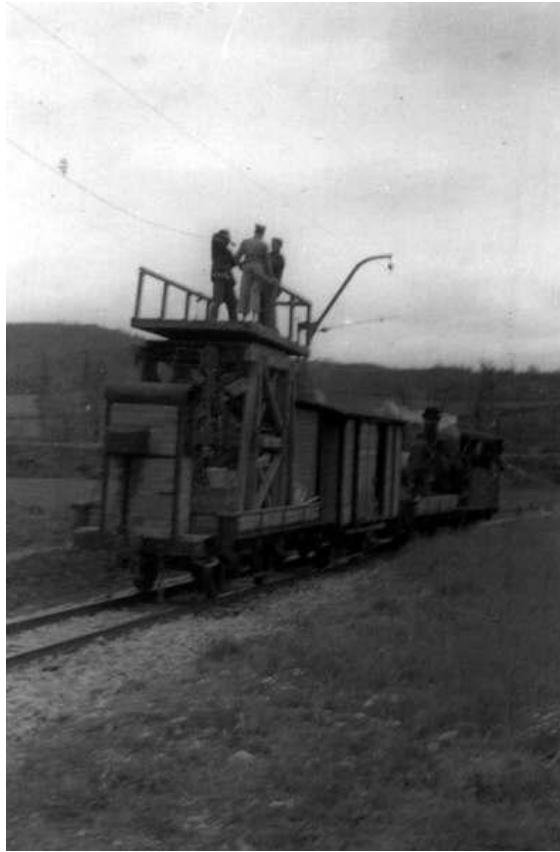
016. Construcción del ramal de Estibalíz-16. Foto Santuario de Estíbaliz
