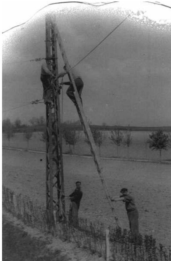
006. Construcción del ramal de Estibalíz-6. Foto Santuario de Estibaliz
