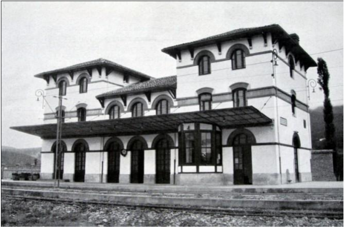
Estación de Santa Cruz de Campezo, Foto tomada de la Memoria de la Junta de Obras del Ferrocarril de Vitoria a Estella, años 1920-1930, fondo: Javier Suso San Miguel
