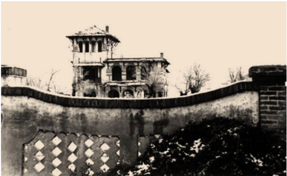
Estación de Olarizu despues del cierre
