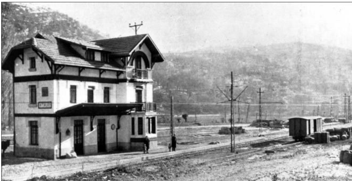
Estación de Atauri, foto tomada de la memoria de la Junta de Obras del Ferrocarril de Vitoria a Estella, del año 1928, fondo : Javier Suso San Miguel
