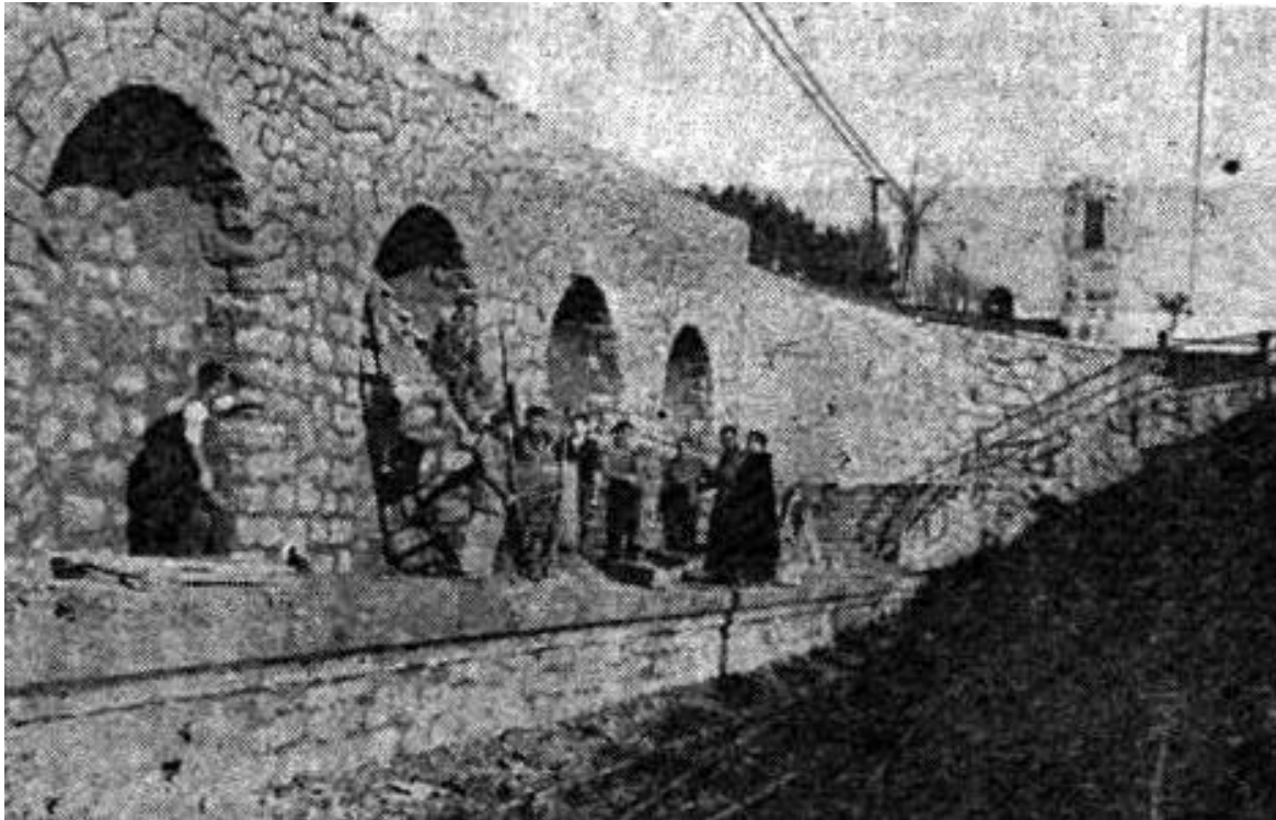
040- Ultimos toques a la estación de Estibaliz-3. Santuario de Estíbaliz.
