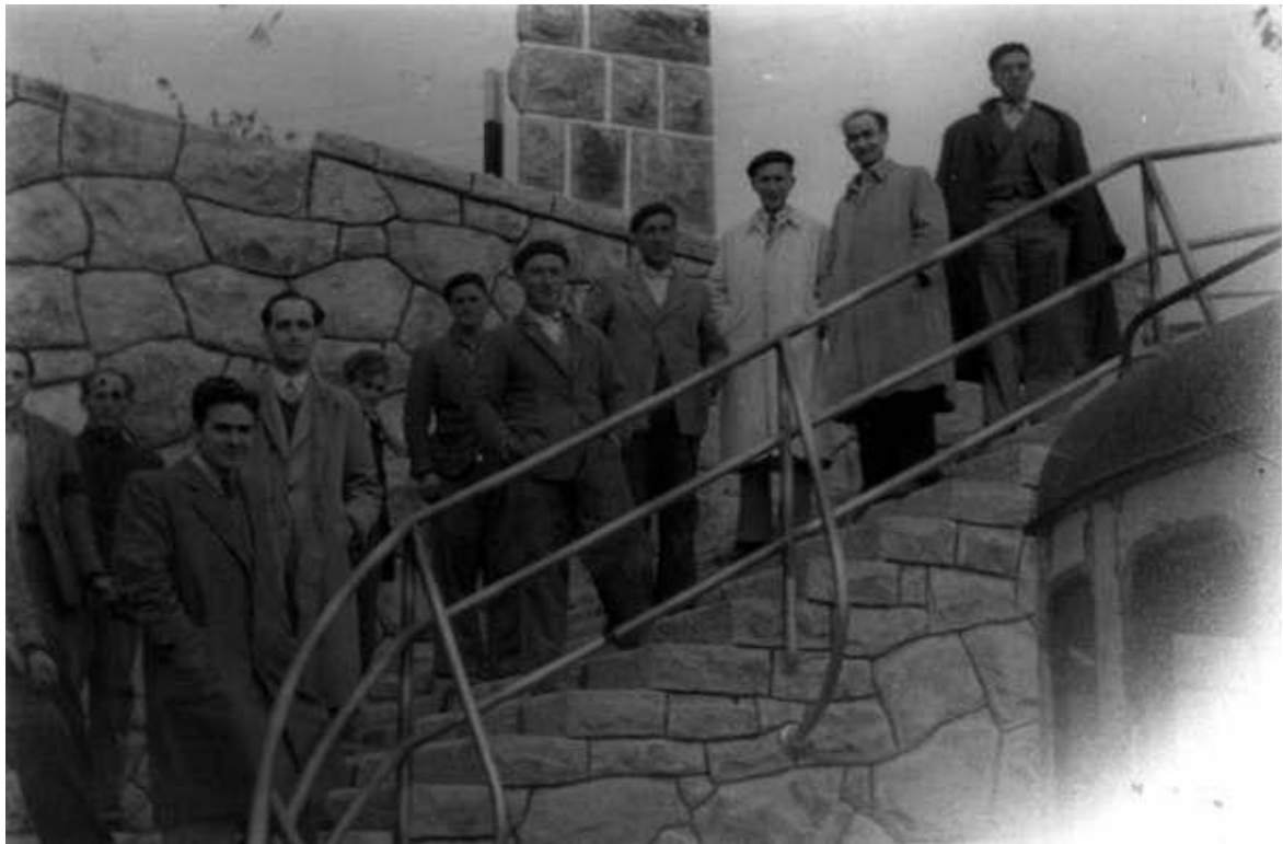
026. Construcción del ramal de Estibáliz-26. Foto Santuario de Estíbaliz
