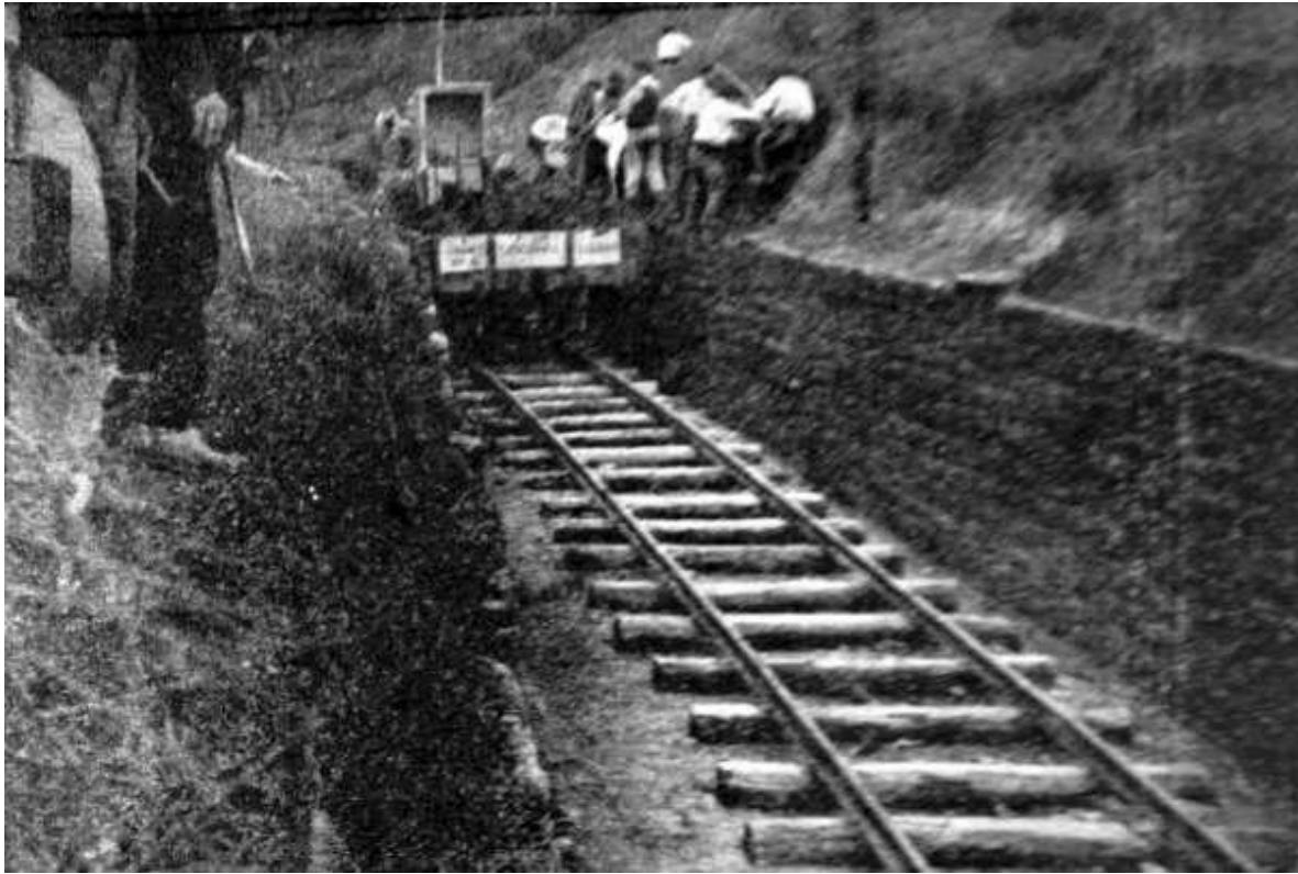
Construcción de la línea Vitoria-Los Martires. Sin documentar
