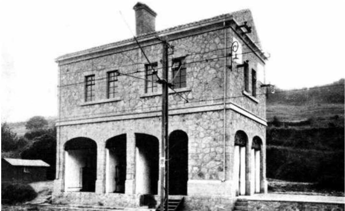
Subestación de Antoñana
