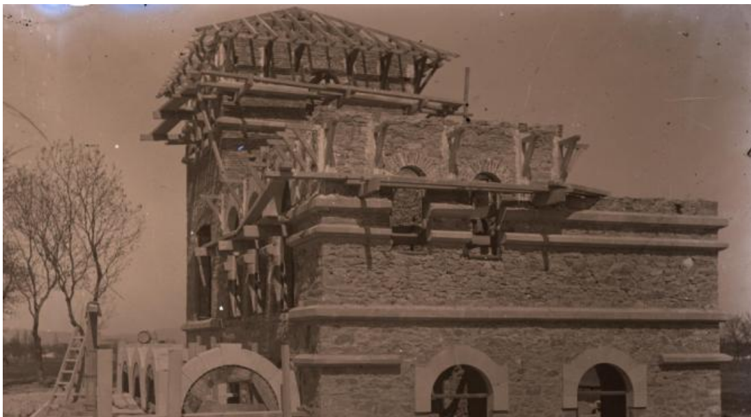
Estación de Olárizu en construcción, año 1923, Archivo Fundación Sancho el Sabio Fundazioa
