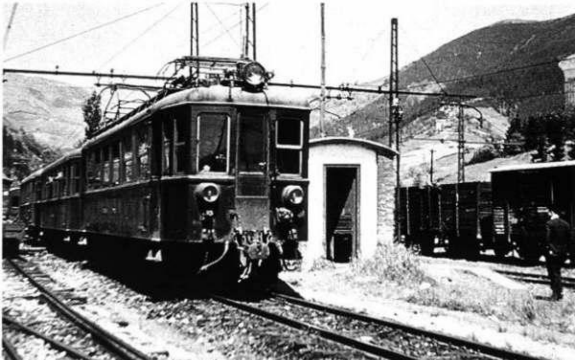
Estación de Mecolalde
