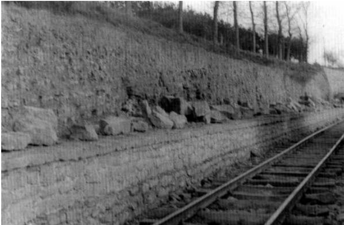
003. Construcción del ramal de Estibalíz-3. Foto Santuario de Estibalíz
