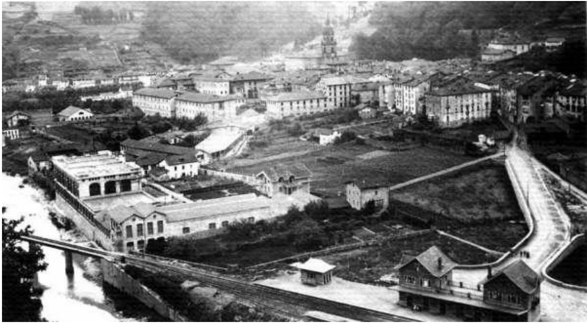
Estación de Vergara
