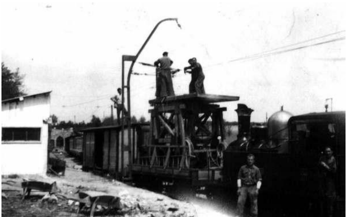
015. Construcción del ramal de Estibalíz-15. Foto Santuario de Estíbaliz
