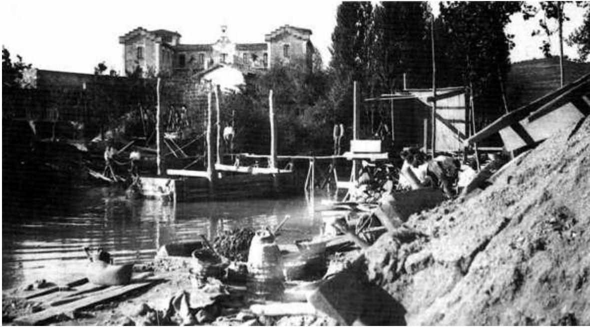
Cimentación del puente de Los Llanos Estella
