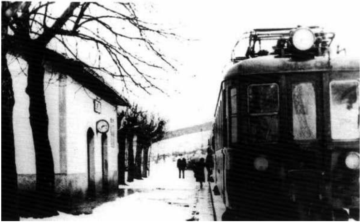
Estación de Urbina
