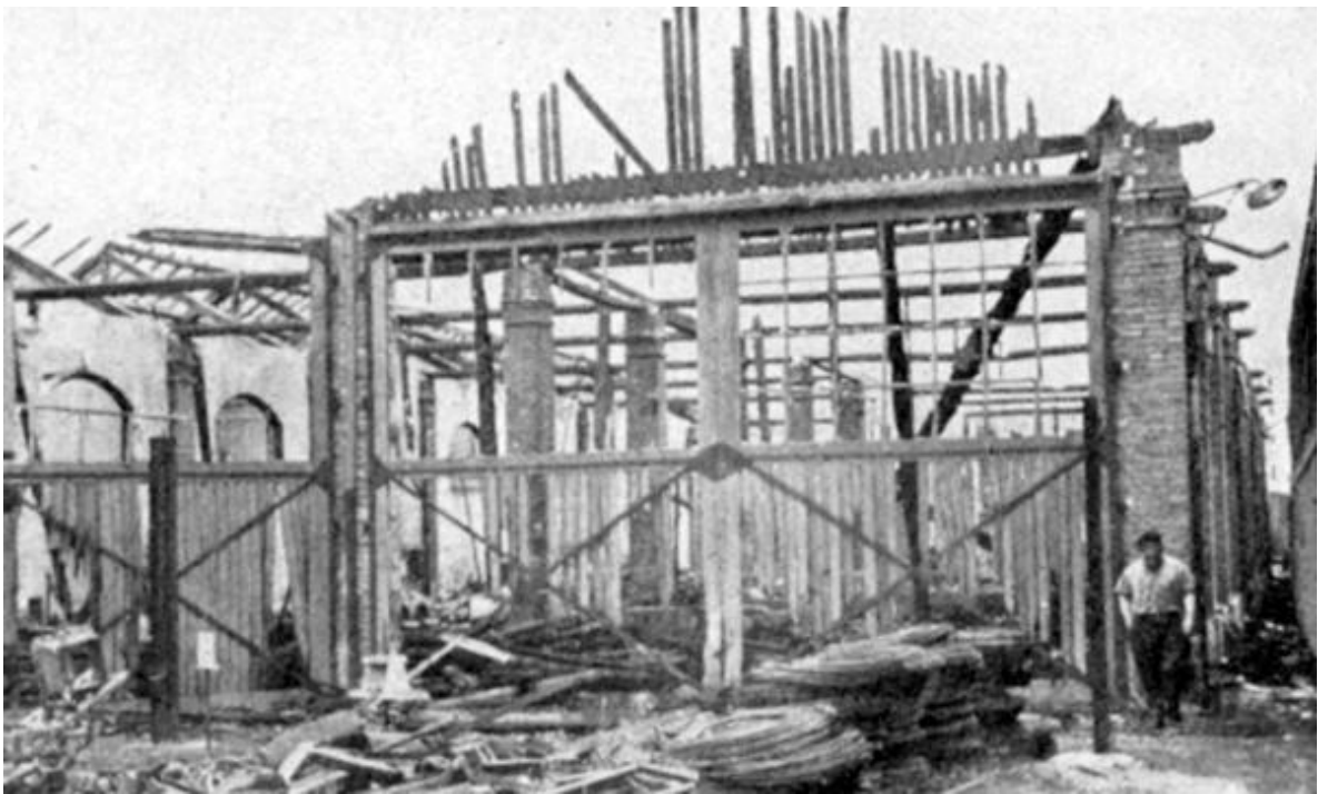
Desmantelamiento y demolición.-31 de diciembre de 1967,
