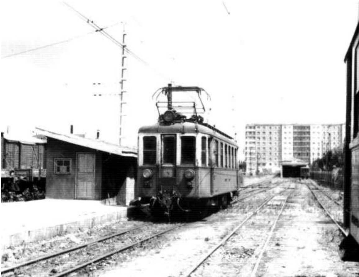
Automotor en la Estación del Norte Vitoria 1965
