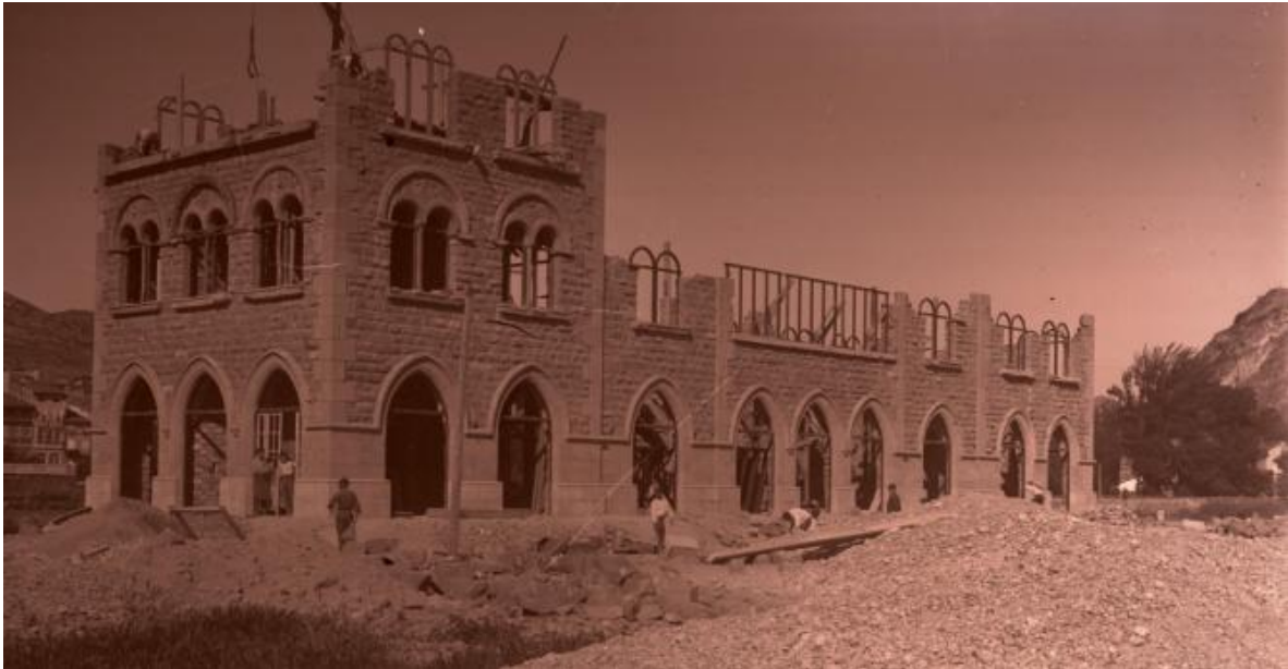
Construcción de la estación de Estella en 1923, Archivo Fundación Sancho el Sabio Fundazioa
