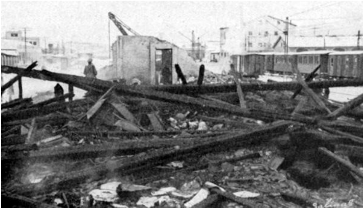
"El Trenico": el derribo y desmantelamiento
