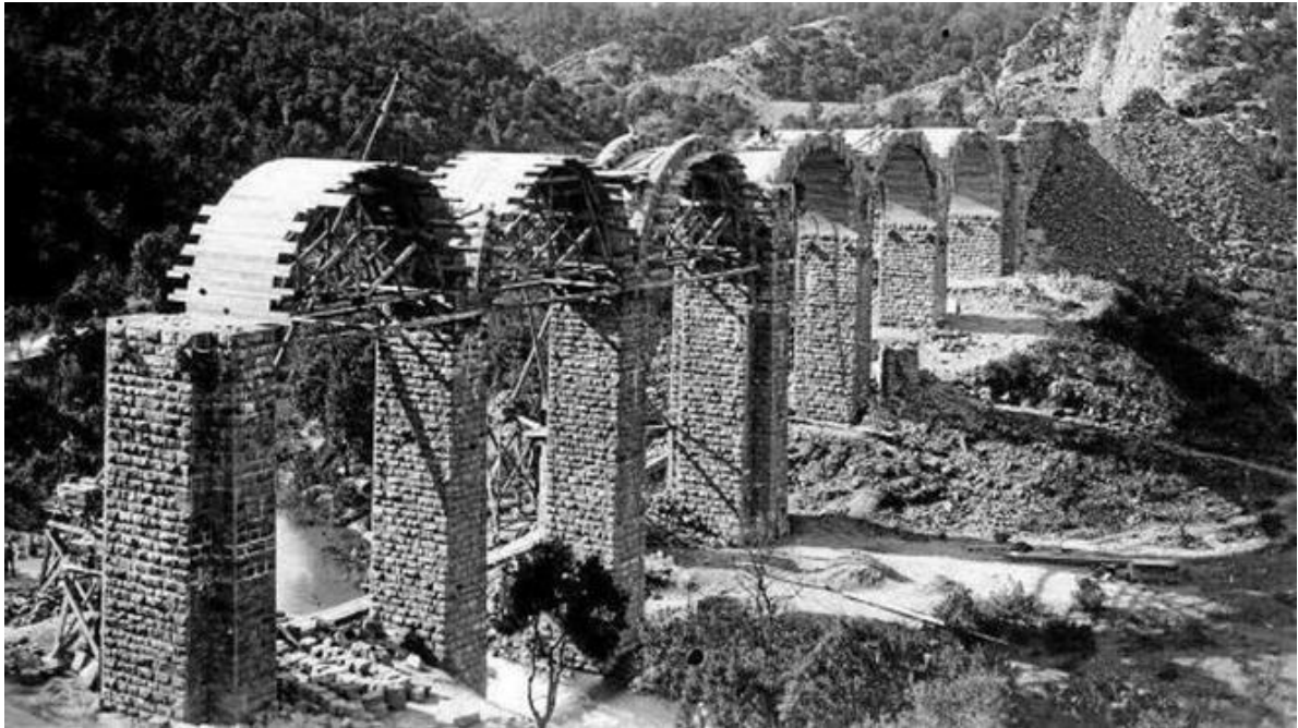
Construcción del viaducto de Arquijas, entre Acedo y Zúñiga. Fotos cedidas
