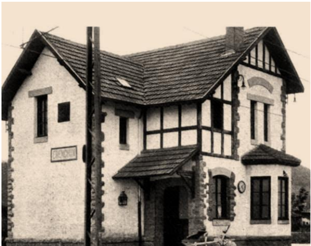
Estación de Erenchun
