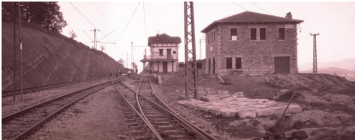
Estación de Ulibarri Jaúregui y subestación, Archivo Fundación Sancho el Sabio Fundazioa
