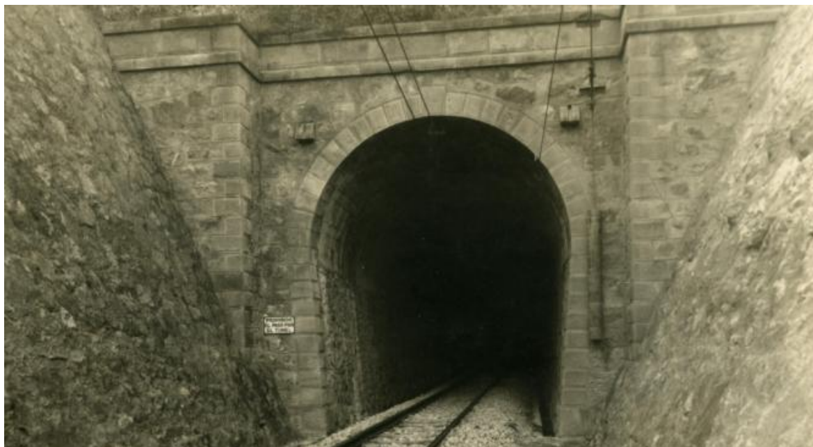
Boca Sur del Túnel de Arguijas, octubre de 1931, Archivo Fundación Sancho el Sabio Fundazioa
