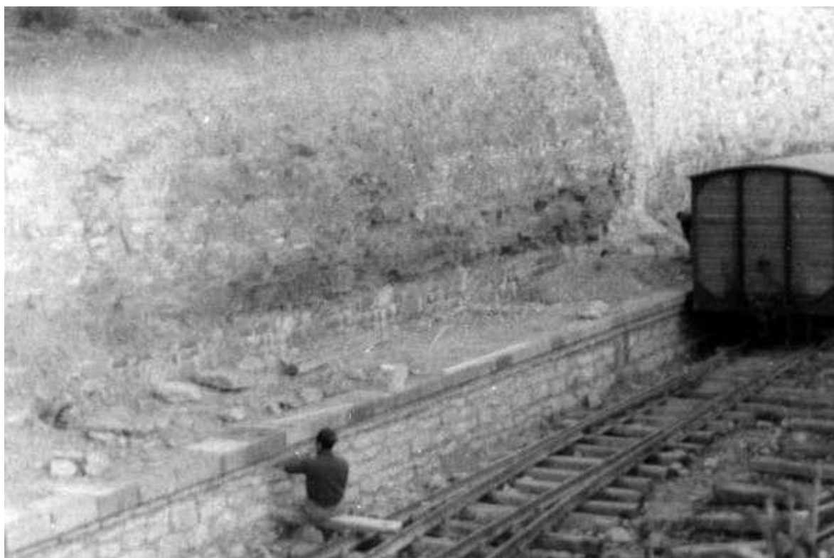
004. Construcción del ramal de Estibalíz-4. Foto Santuario de Estibaliz
