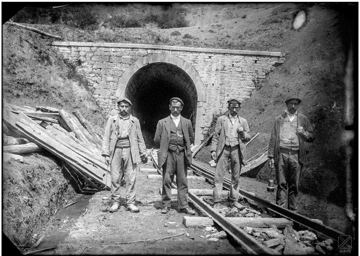
Trabajadores de las obras de construcción del ferrocarril Vasco-Navarro.-1915
