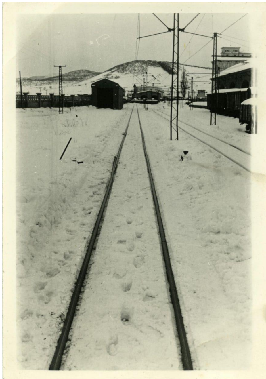
A la derecha de la fotografía se puede ver una de las vías del antiguo ramal.
