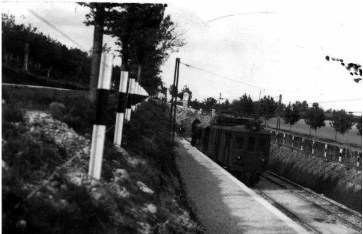
023. Construcción del ramal de Estibalíz-23. Foto Santuario de Estíbaliz
