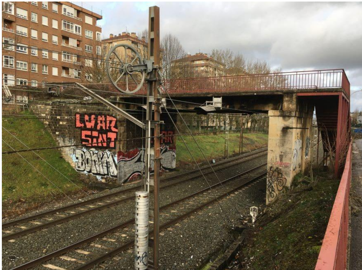
Antiguo puente del Vasco-Navarro sobre las vías de la línea Madrid-Irún.
