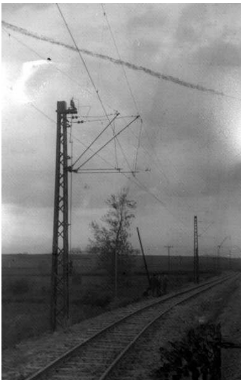
018. Construcción del ramal de Estíbaliz-18. Foto Santuario de Estíbaliz
