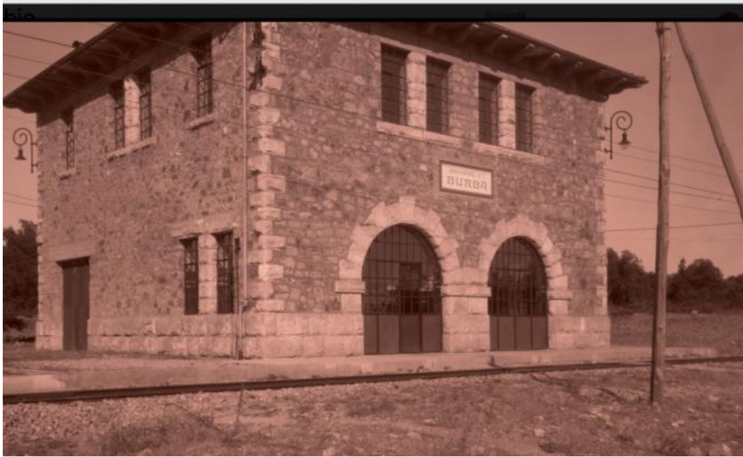
Edificio de la subestación de Burba en Ancin, Archivo Fundación Sancho el Sabio Fundazioa
