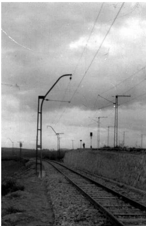
019. Construcción del ramal de Estíbaliz-19. Foto Santuario de Estíbaliz
