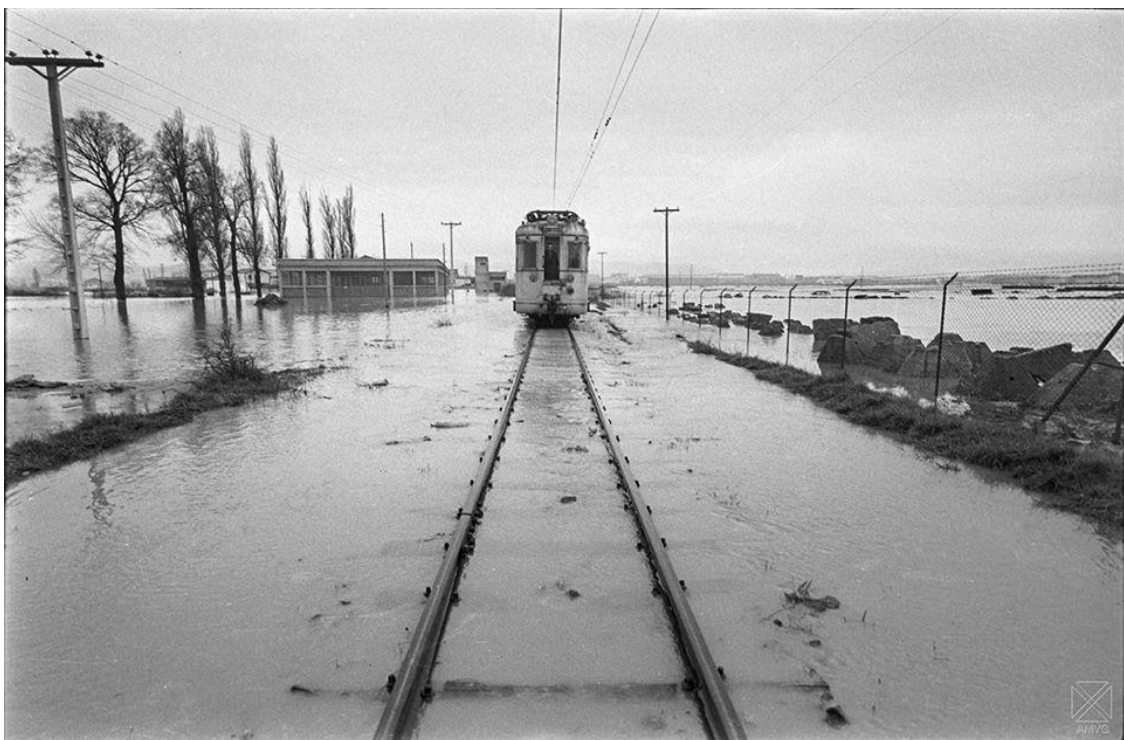
Vía del ferrocarril inundada.-1960
