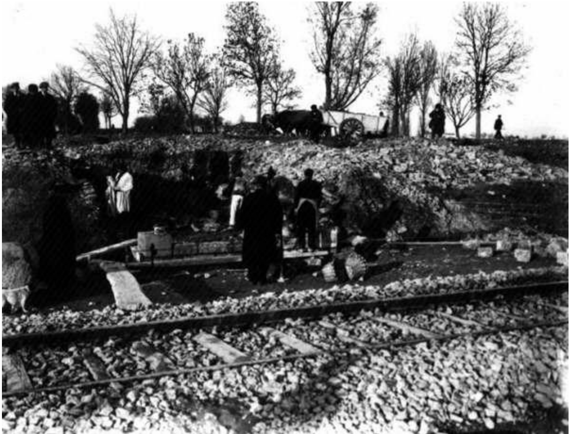
064. Construcción del ferrocarril-2. Foto E. Guinea. Archivo Municipal Vitoria-Gasteiz.
