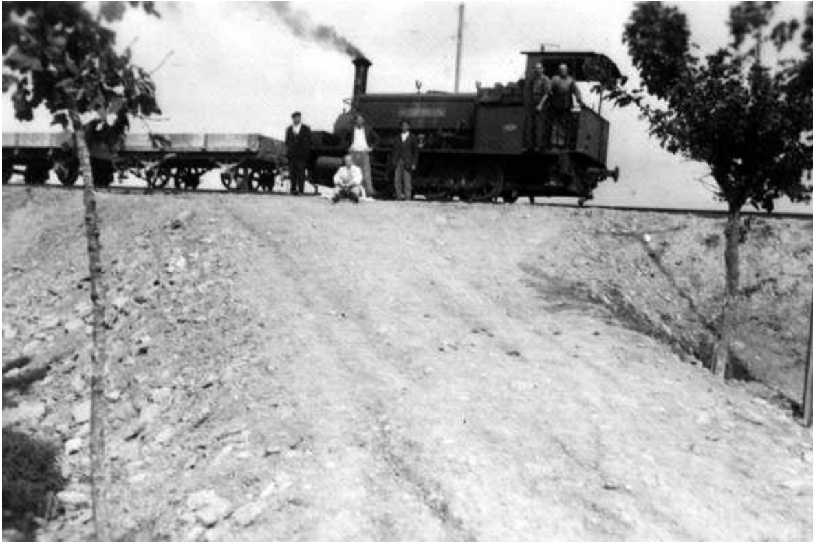
020. Construcción del ramal de Estibáliz-20. Foto Santuario de Estíbaliz
