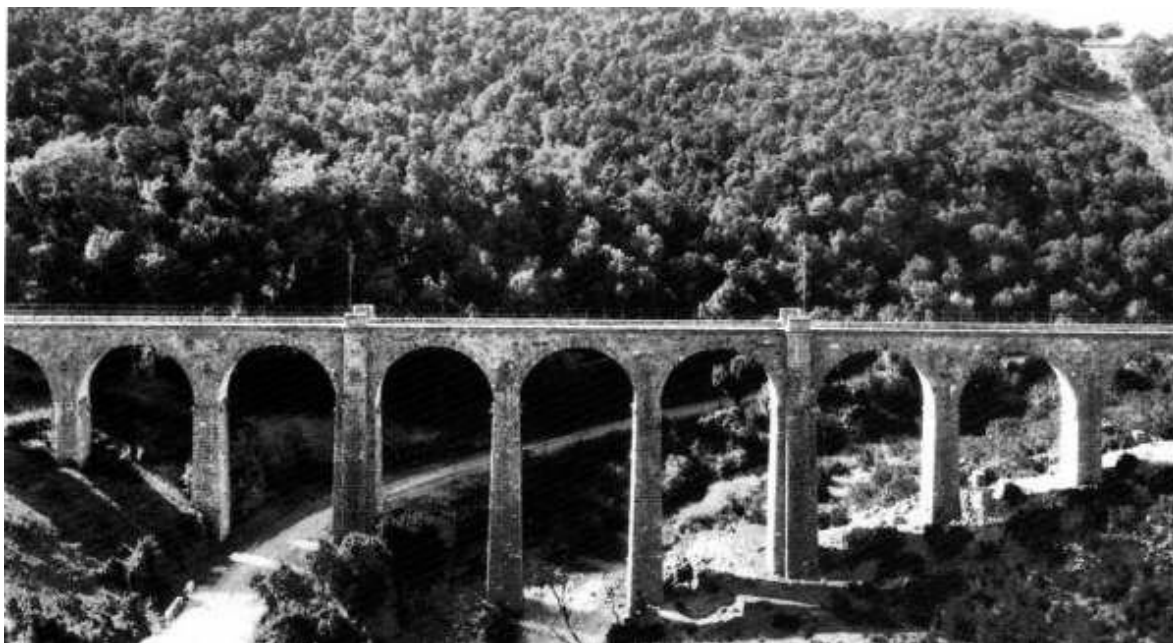
Viaducto de Arquijas
