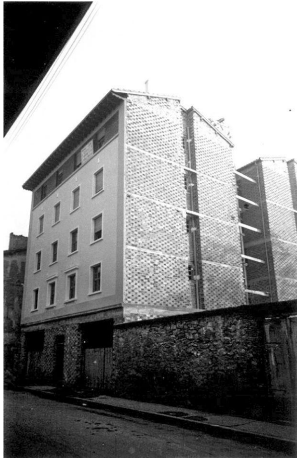
Calle Cercas Bajas-Edificio de viviendas. Octubre de 1954
