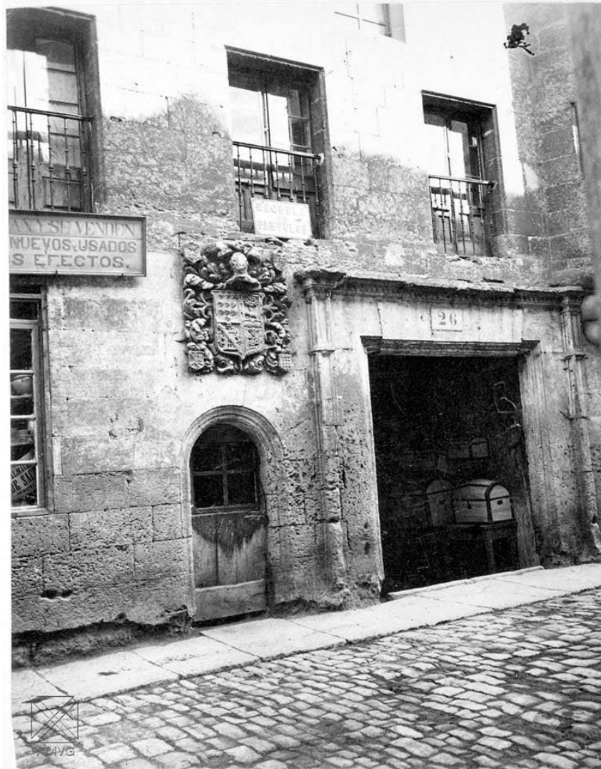
Calle cuchillería. Casa de los Cubos. Año 1874.
