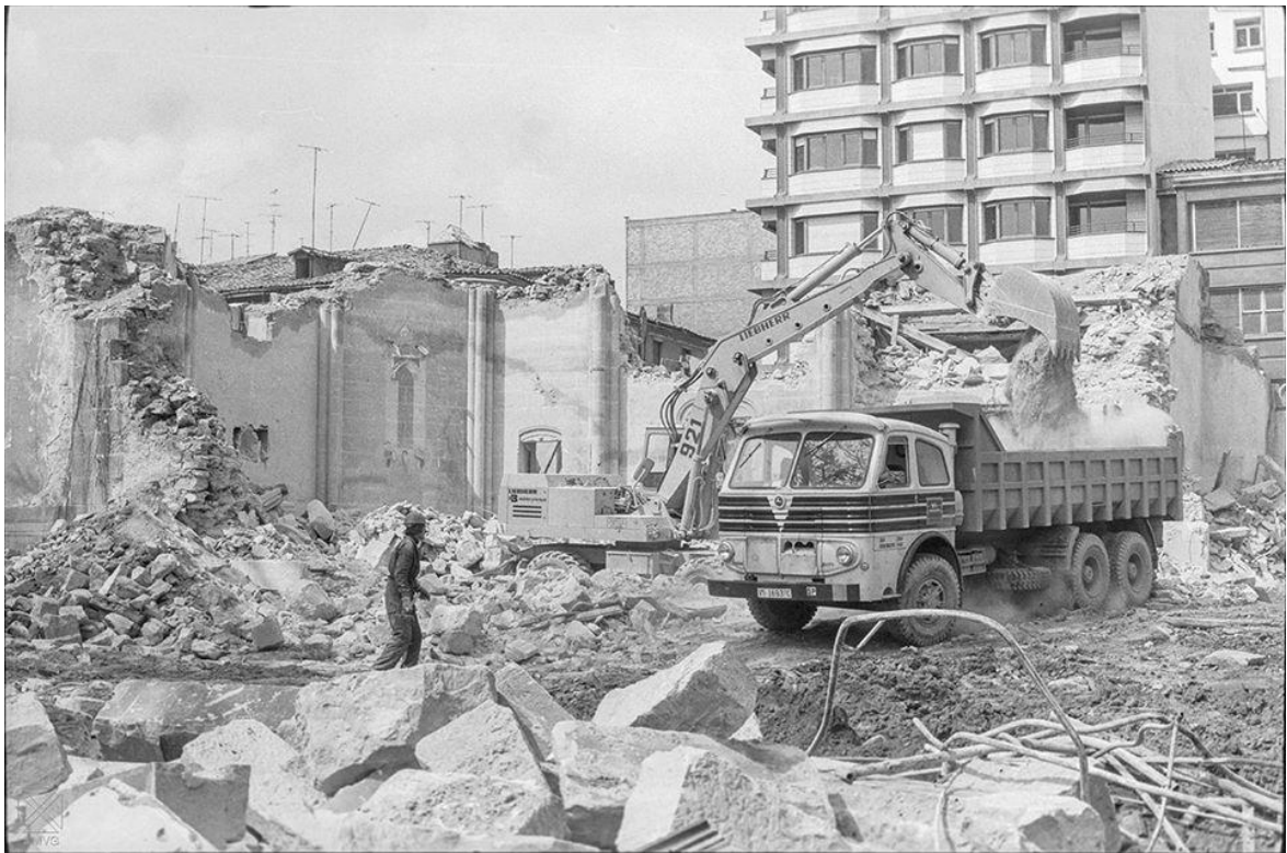
Calle la paz.-derribo de la Capilla del Hospital.-1976
