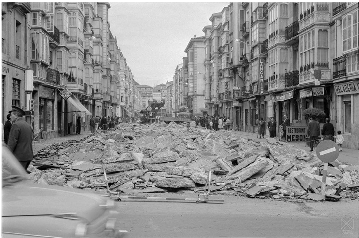
Calle Dato en obras.-1963
