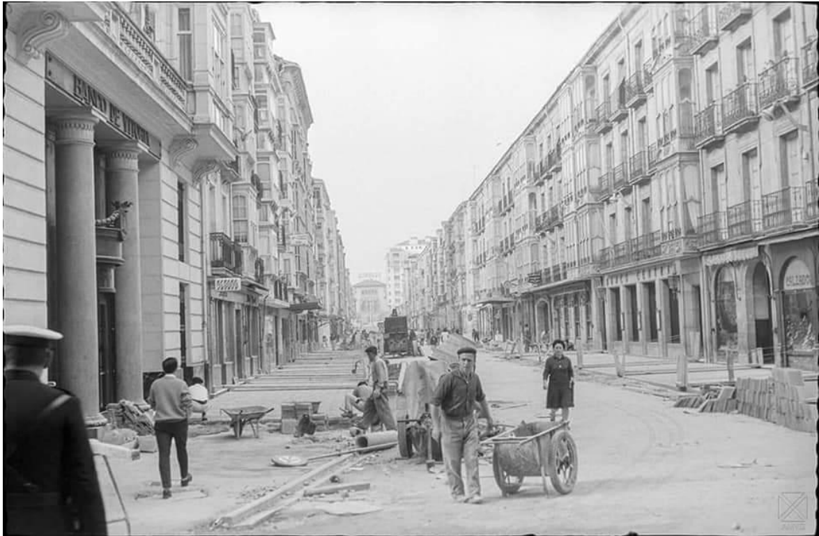
Calle Dato.-9-7-1963-pavimentando las aceras
