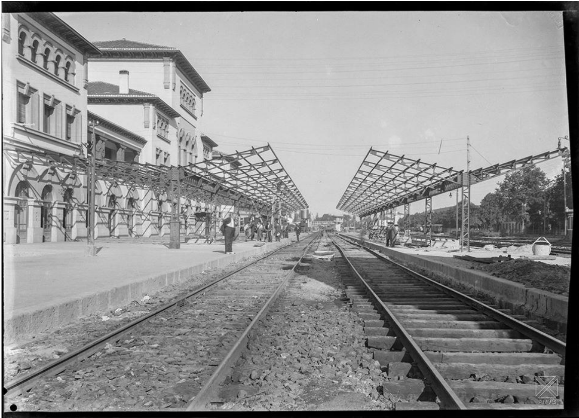
Calle Dato-Renfe, instalación de marquesinas en la Estación del Norte.-1936
