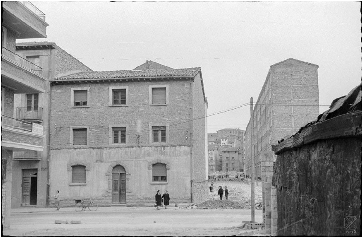
Calle Cercas Bajas con Badaya.
