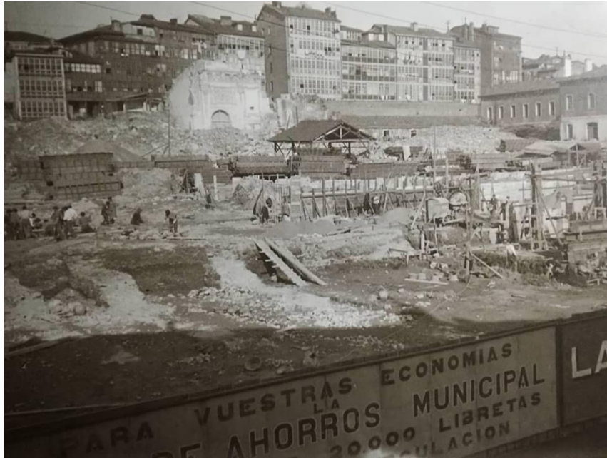
Calle San Francisco. Demolición convento San Francisco
