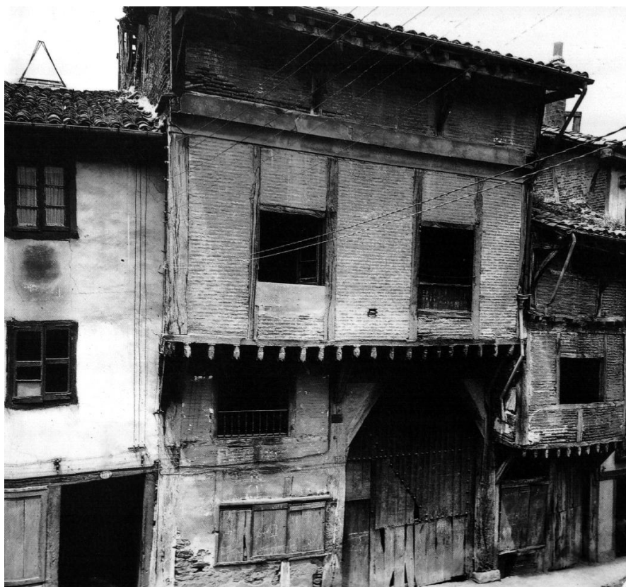
Calle Correría. Antes de su restauración.
