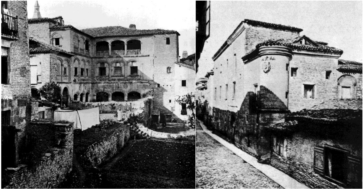
Calle Cuchillería. Palacio de Bendaña.
