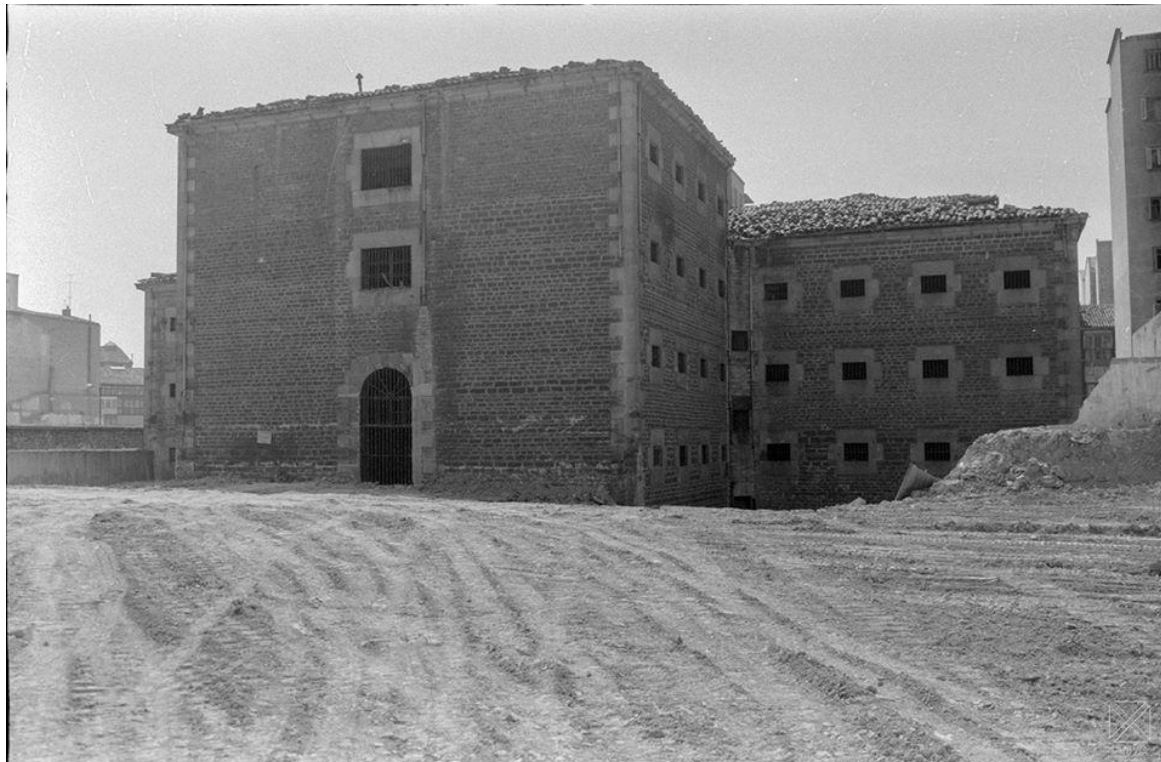
Calle La Paz. Demolición de la cárcel .1974
