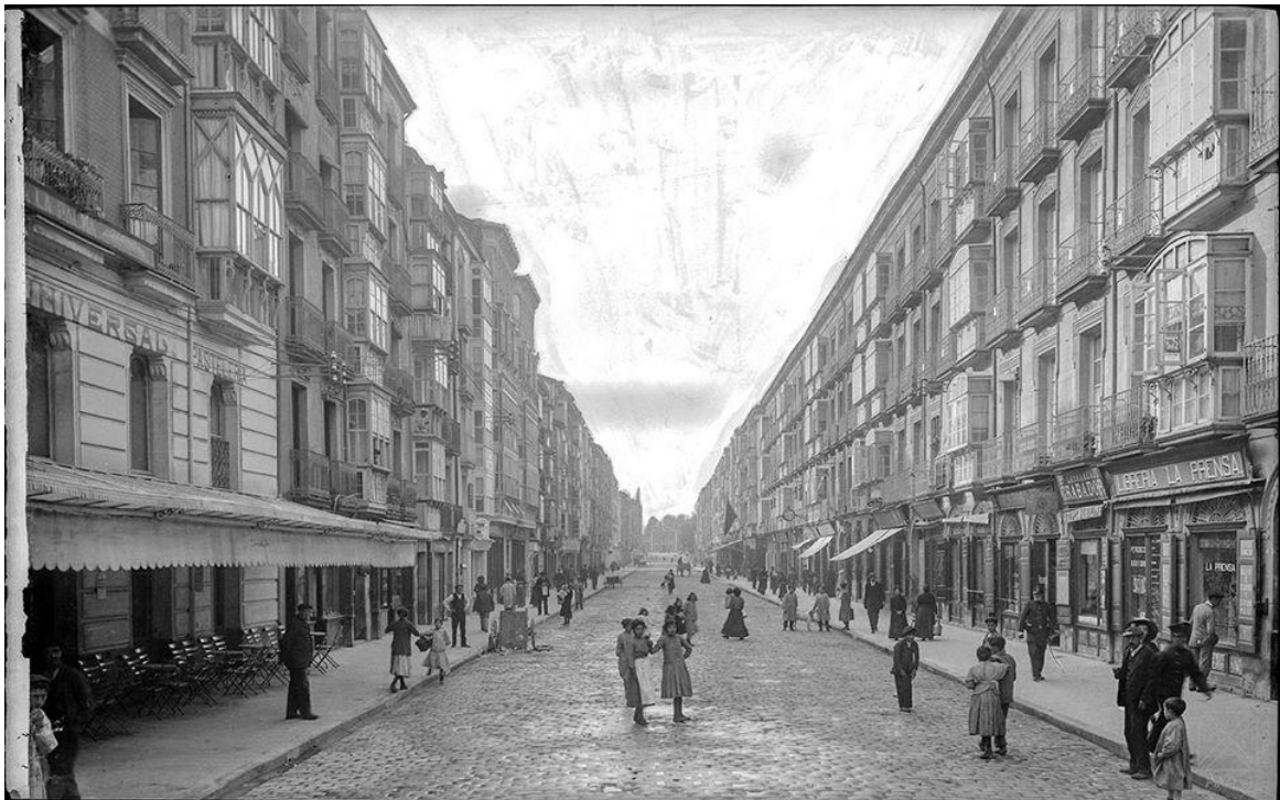
Calle de la Estación, actual Dato.-1905
