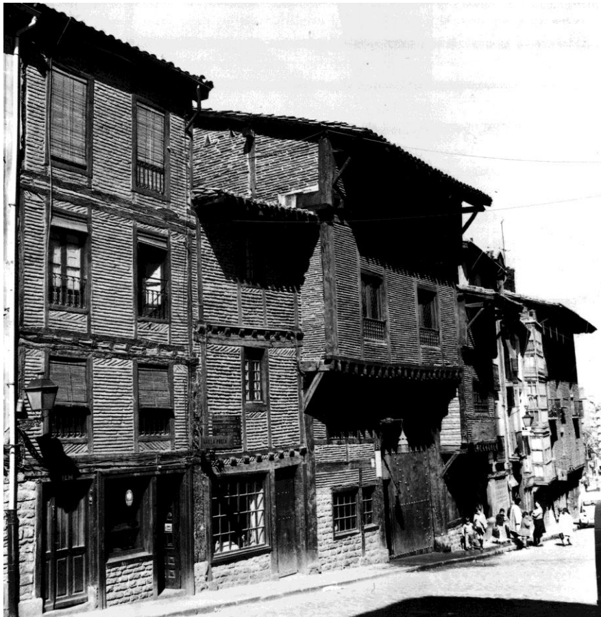
Calle Correría, 151.-Fachada restaurada del Portalón.
