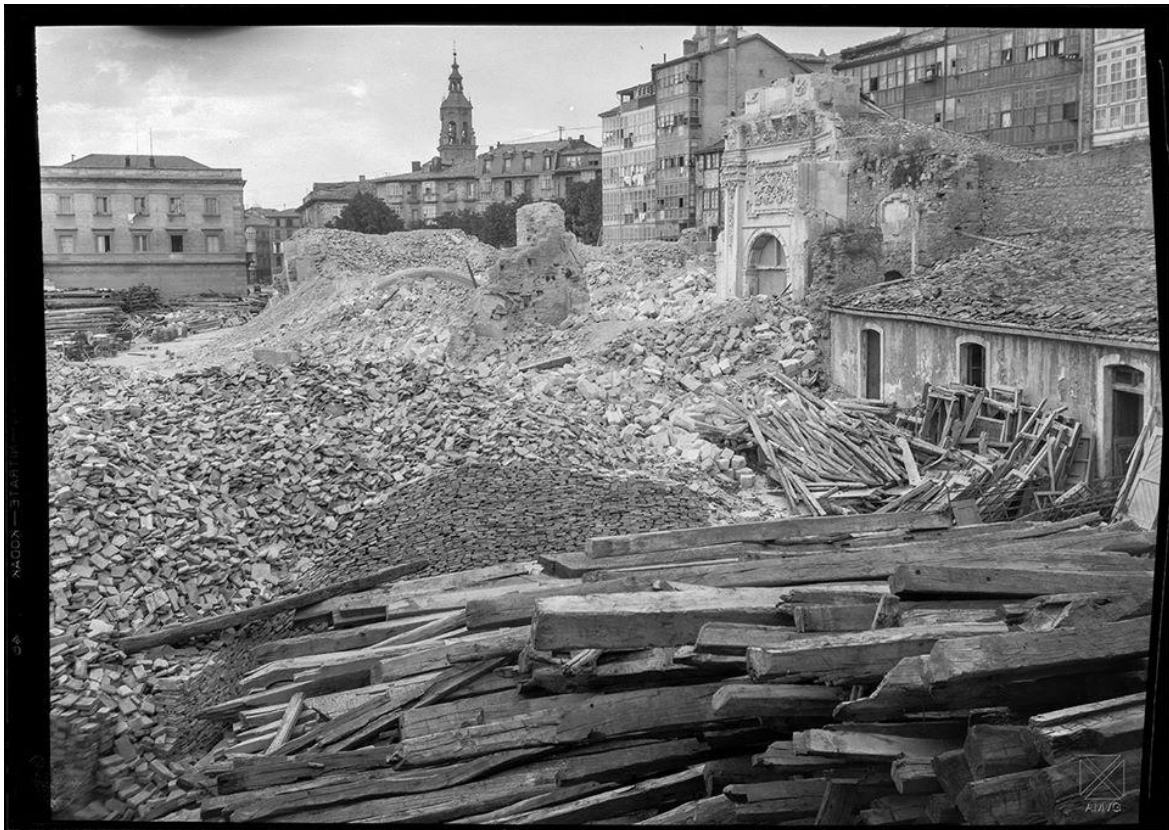
Calle San Francisco y postas.-derribo del Convento de San Francisco.-1929
