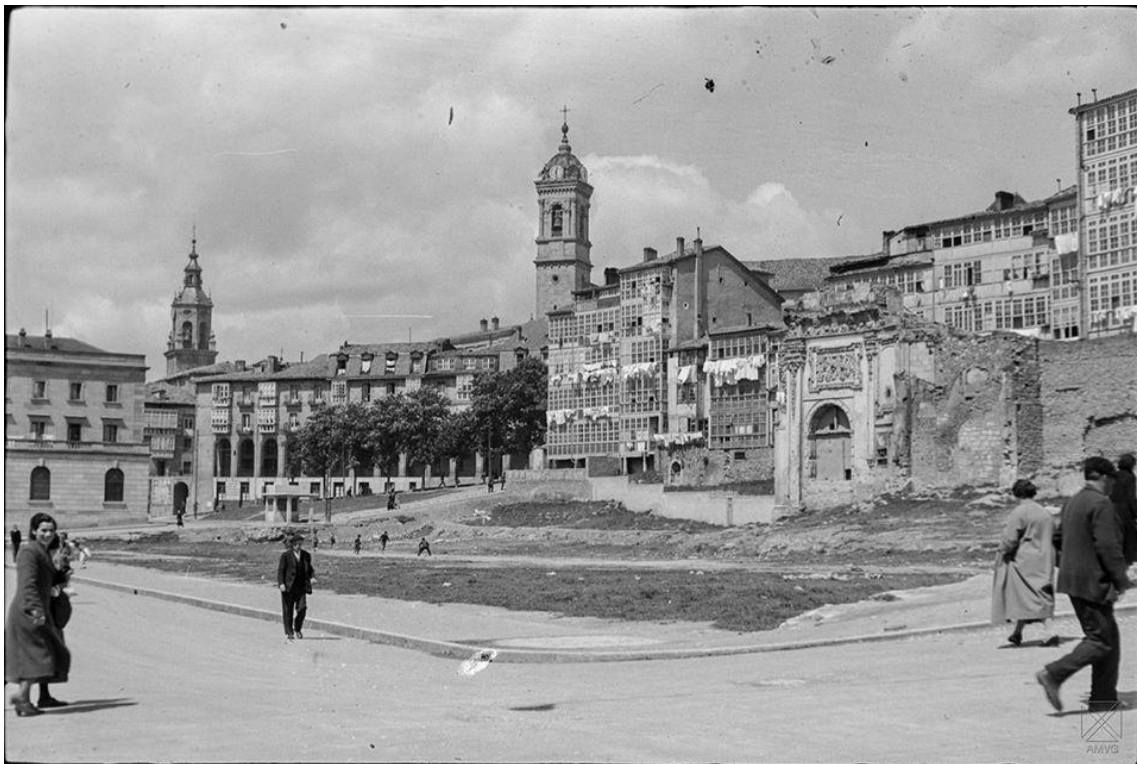
Calle San Francisco. Solar del derribado convento de San Francisco. 04-194
