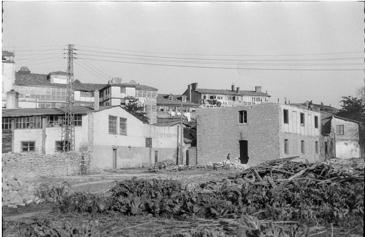
Vitoria-Gasteiz, obras de prolongación de la calle General Álava.
