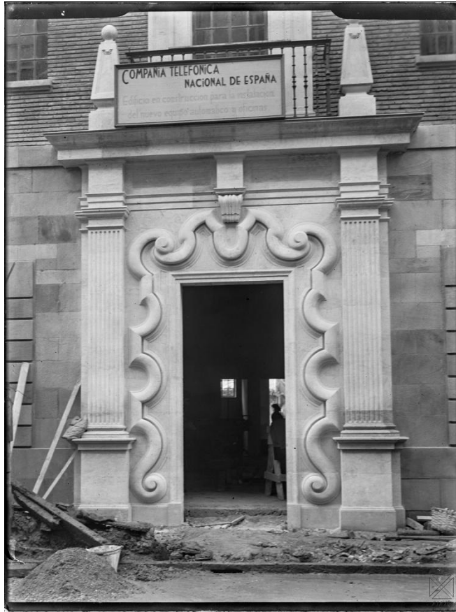
Vitoria-Gasteiz, obras de construcción del edificio de la Compañía Telefónica en la calle General Álava.
