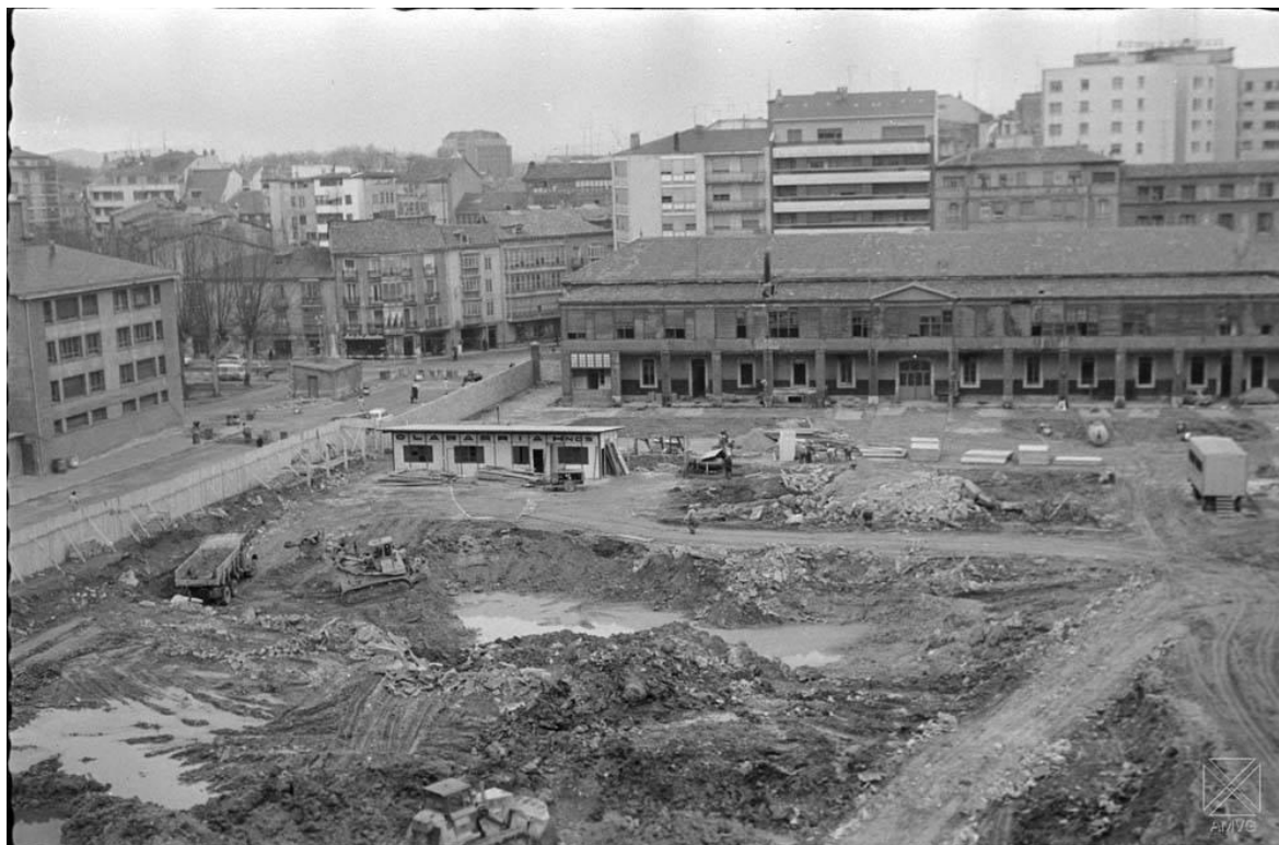
Derribo de los pabellones del Cuartel de Artillería en la calle Jesús Guridi. Santiago Arina. (Marzo 1972)
