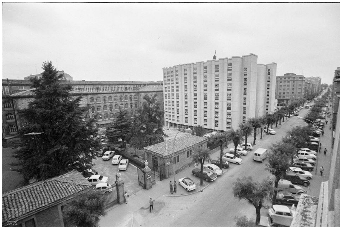
Calle Olaguíbel.-1973-con las dos alas el hospital de Santiago
