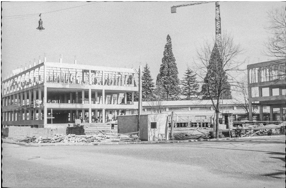
Calle Nieves Cano, obras de construcción del nuevo Instituto.-16-2-1962
