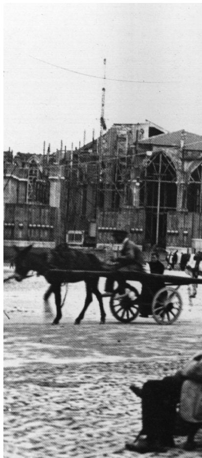
Calle Magdalena-calle magdalena-Catedral nueva en construcción
