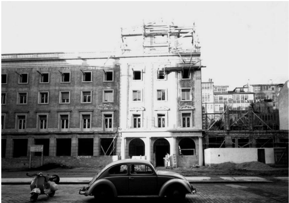
Calle Olaguibel. Hacienda en construcción. Años 50
