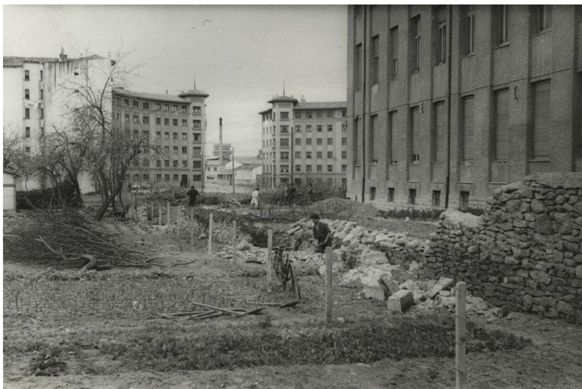
Calle Landázuri sin pisos.
