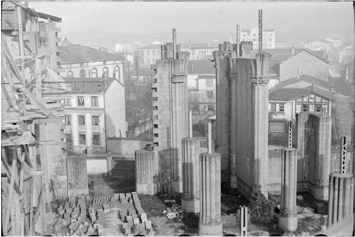
Calle Magdalena-catedral de M ª Inmaculada en construcción.-enero 1948
