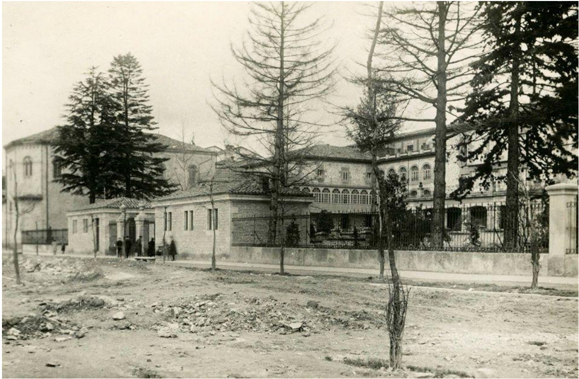
Calle Olaguibel-1929 - Hospital General de Santiago
