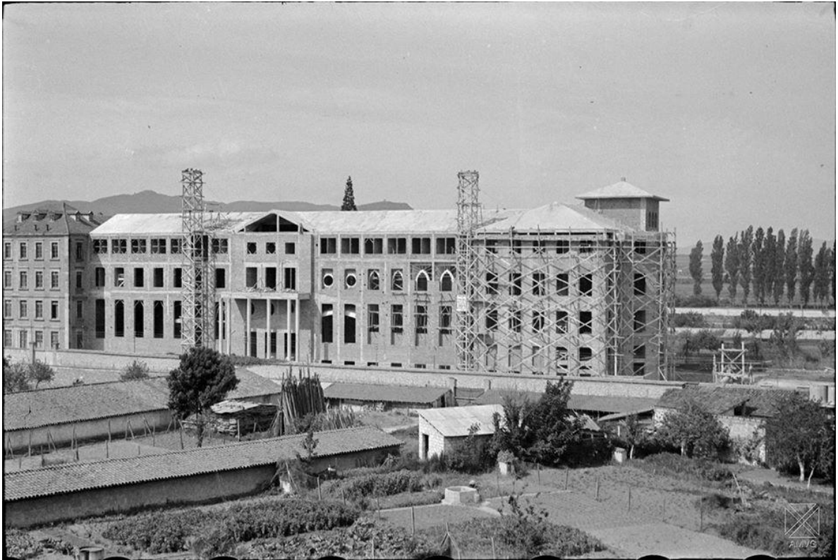
Calle Luis Heintz. -obras de ampliación del colegio de Santa María.08-1948
