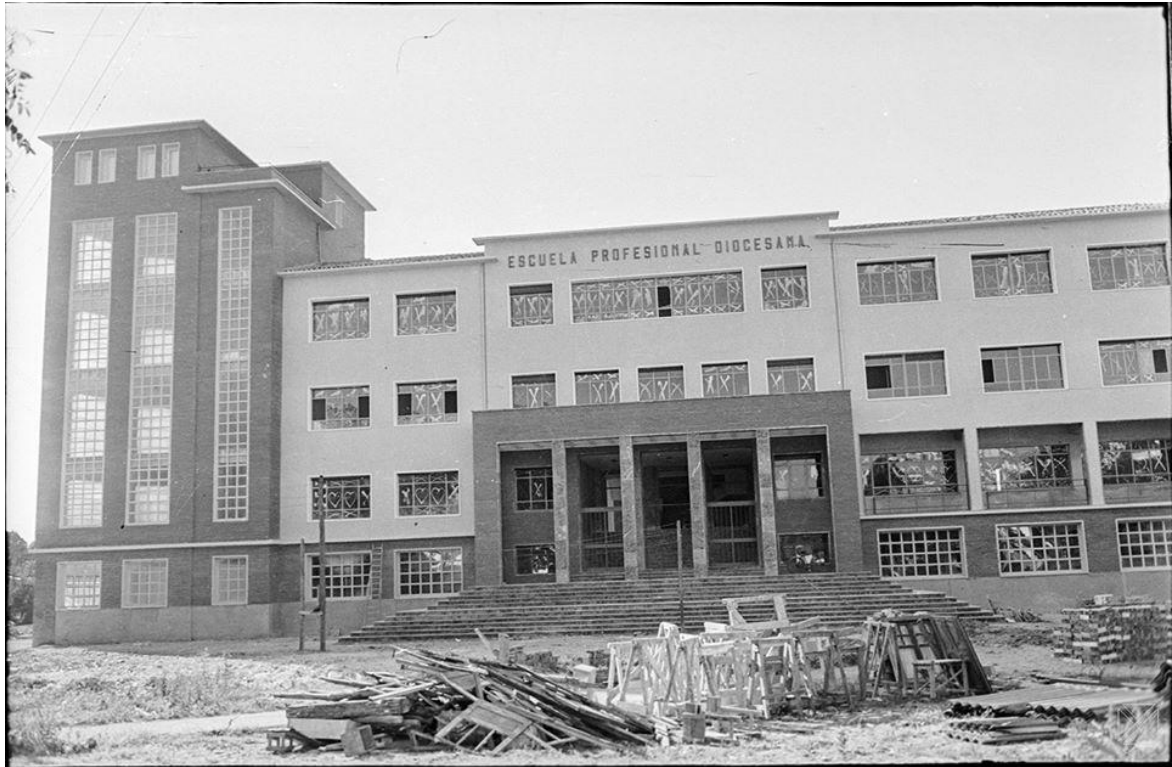
Calle Nieves Cano, edificio de las Escuelas Diocesanas En construcción.-16-2-1962
