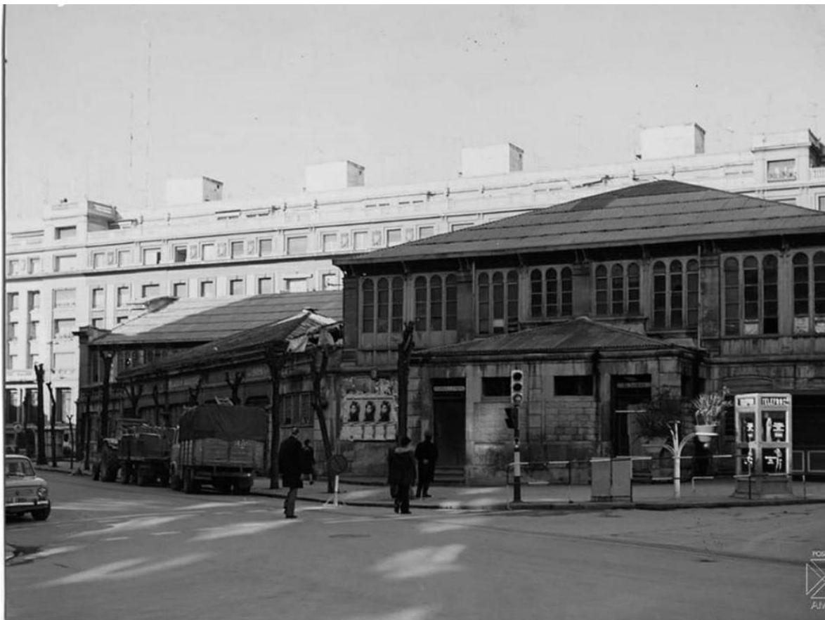
Calle fueros-postas-Plaza de Abastos-2 ARQUÉ.(1975)
