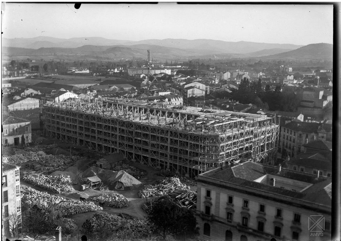
Calle Olaguibel y postas.-edificio de la Caja de Ahorros en construcción.1932
