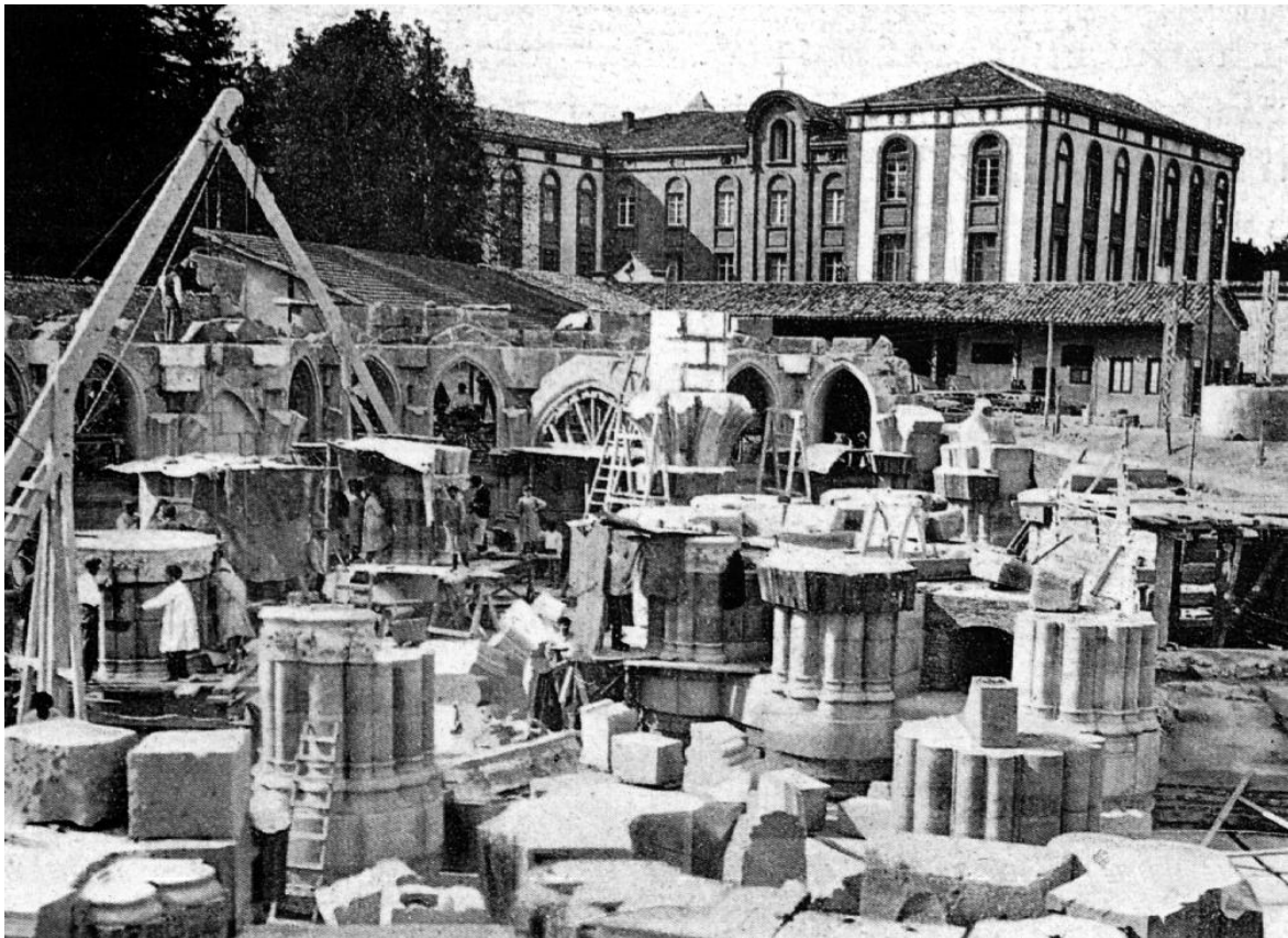
Calle Magdalena-Catedral nueva– Aspecto de la Cripta en construcción
