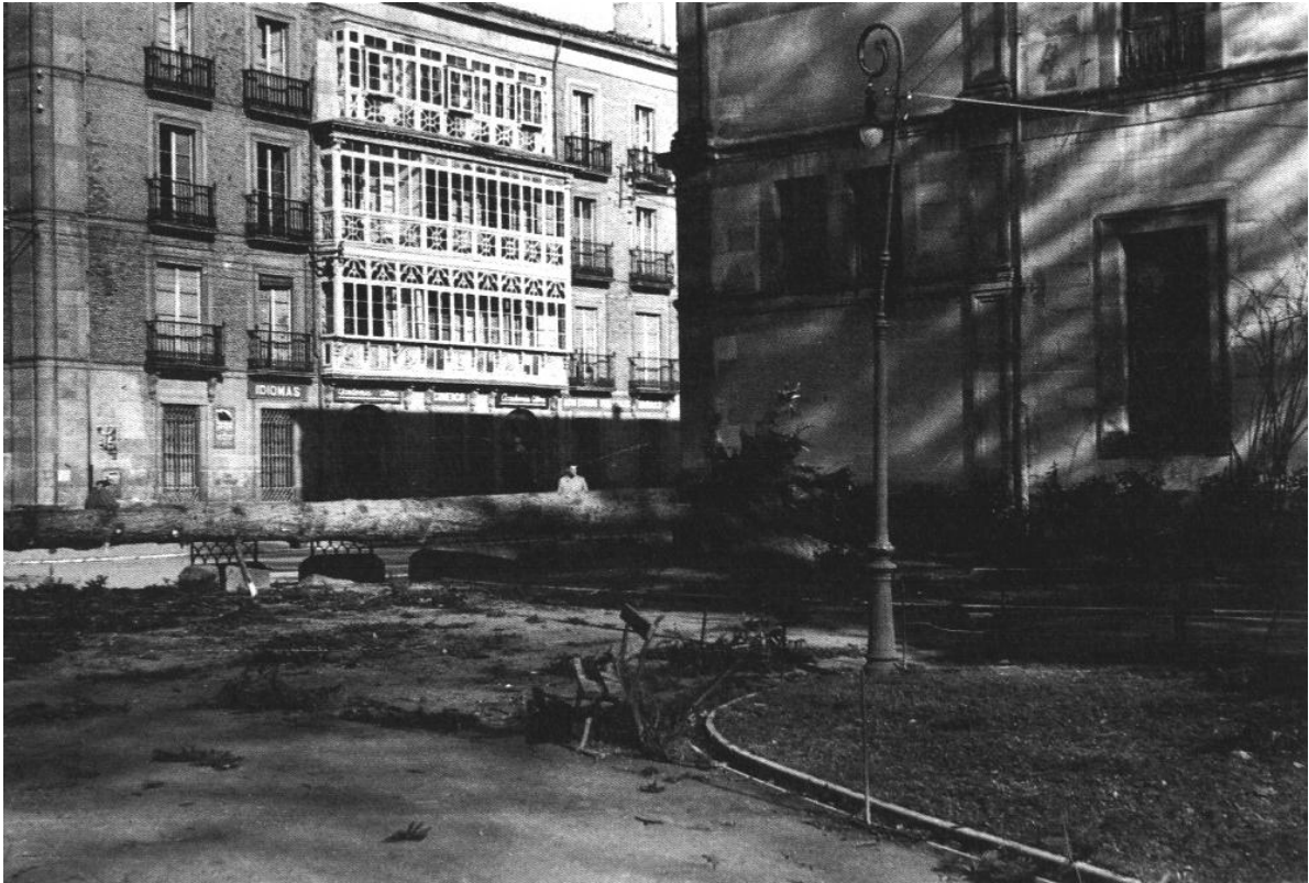
Calle Parque de la Florida.-Tifón en la Florida – Febrero de 1941
