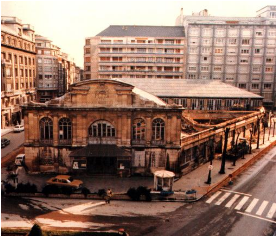
Calle Plaza de Abastos.-Demolición
