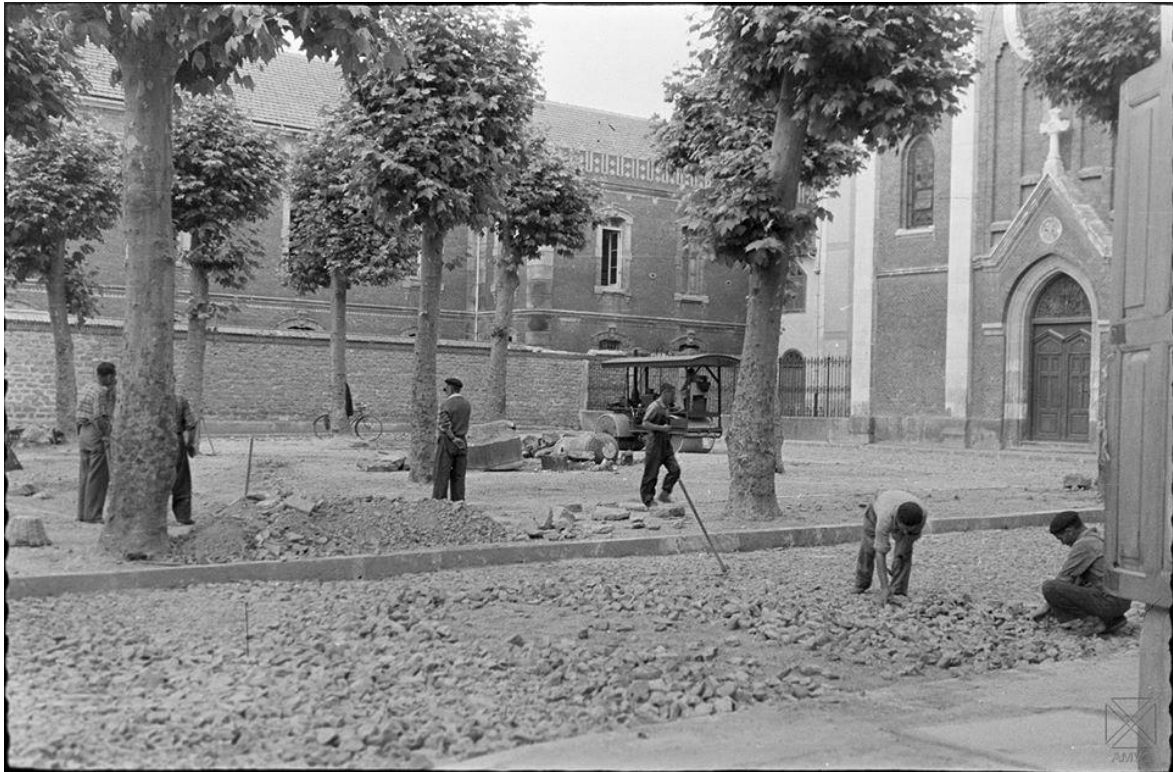
Calle de los Desamparados.-reforma de la plaza -1956
