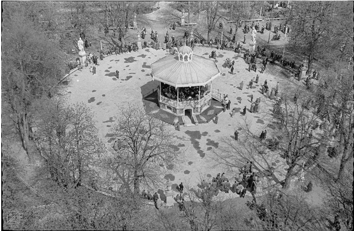
Calle parque de La Florida.-6-4-1958
