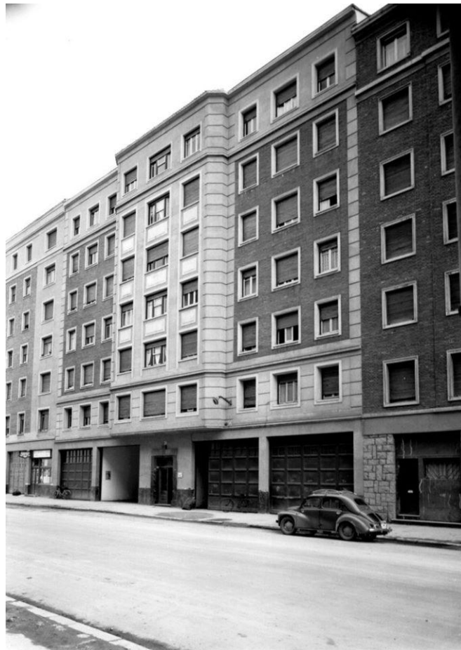
Calle paseo de la Zumaquera edificio de la Patatera en el (16)
