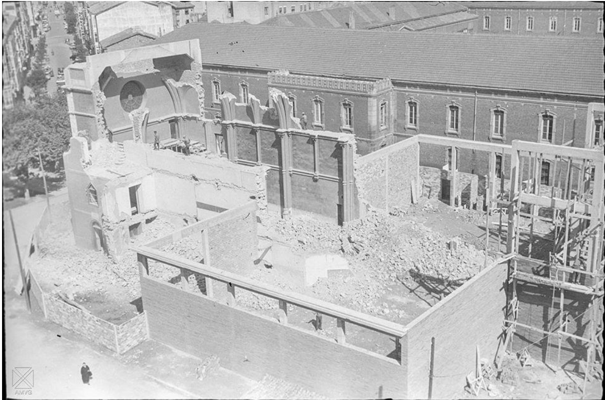
Calle Desamparados.-obras en la iglesia de Los Desamparados.-2-9-1963
