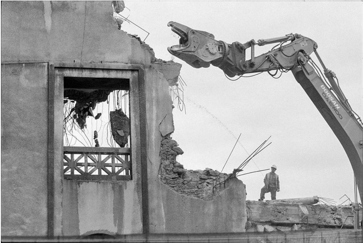
Trabajos de demolición de la plaza de toros.2007
