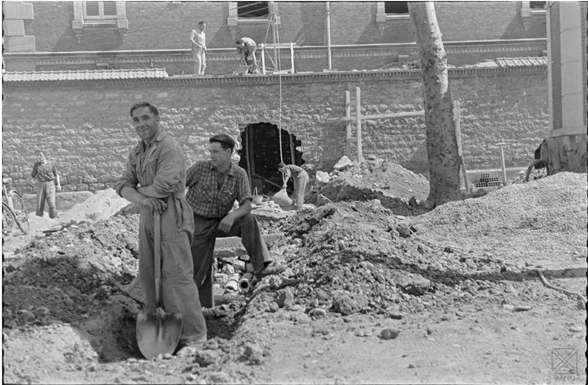
Calle de los Desamparados.-reforma de la plaza -31-7-1956
