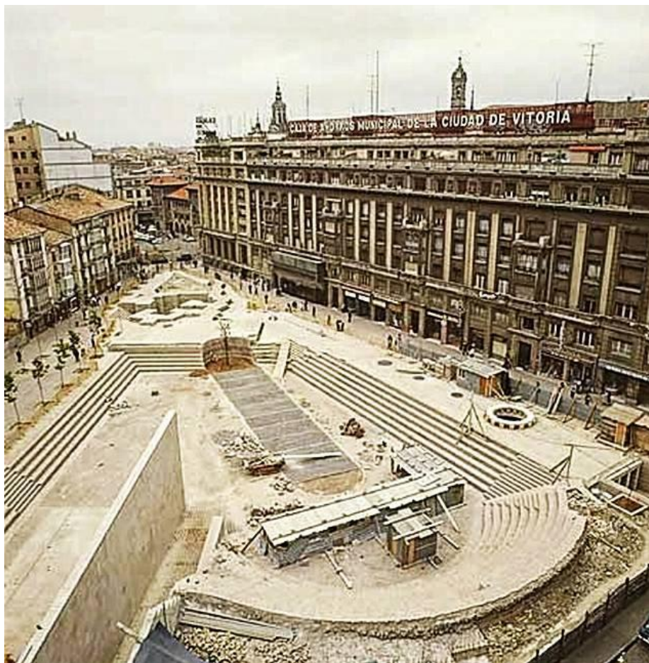
Calle Plaza de los Fueros en construcción.(1980)
