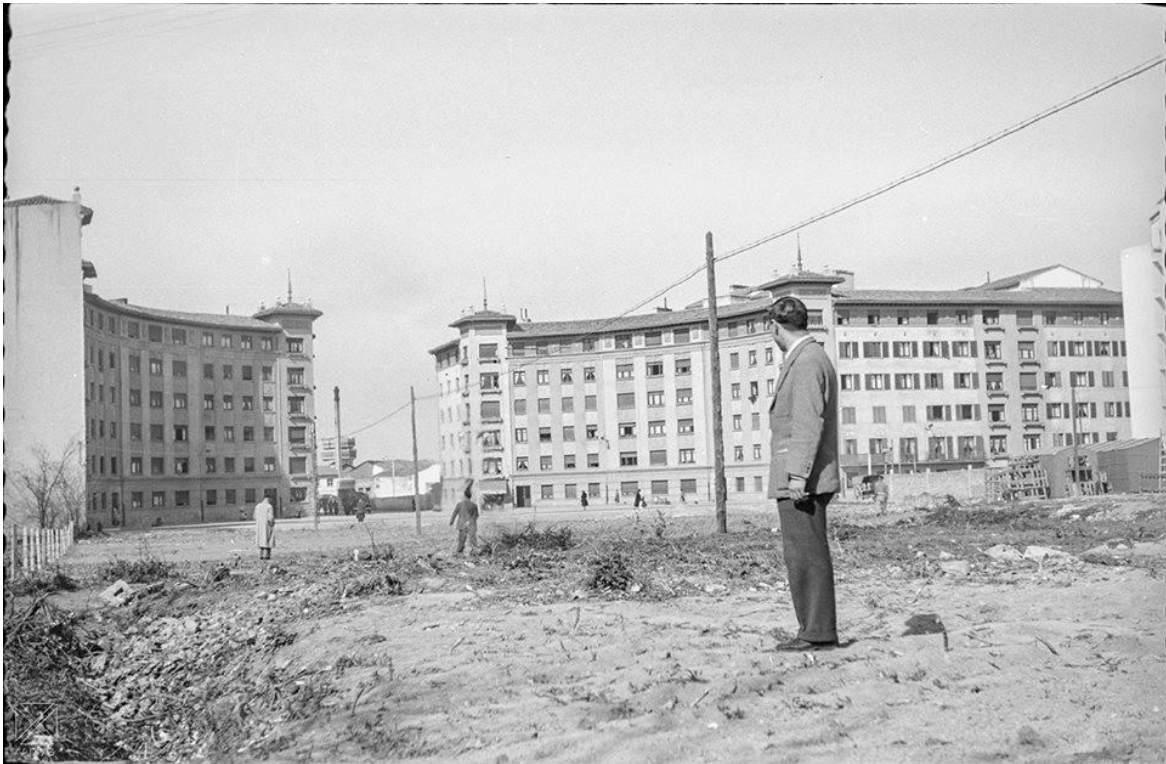
Calle plaza Juan de Ayala en construcción.
