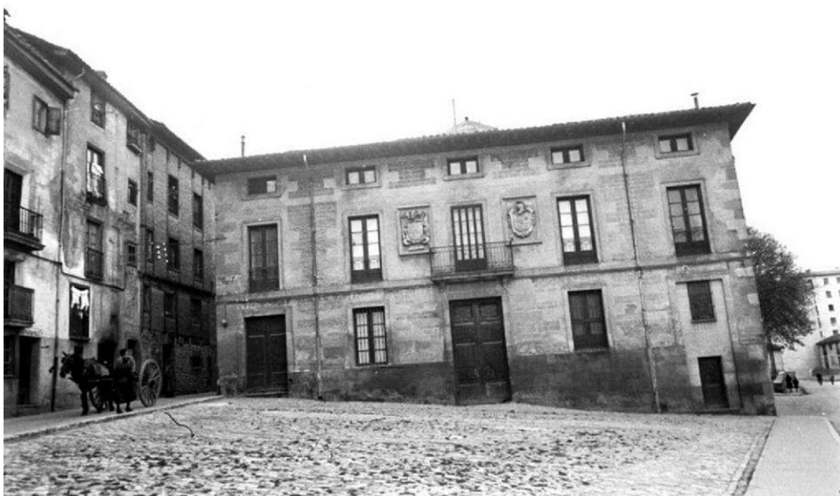
Calle plazuela sto. domingo,1.-Casa de los Alava-Velasco .1955
