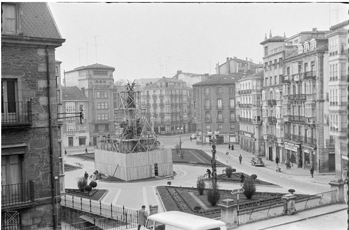
Calle plaza de la Virgen Blanca.29-3-1963-reparacion monumentto a la batalla de vitoria
