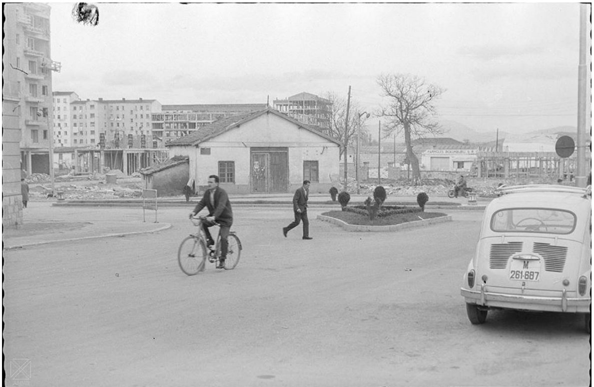
Calle Portal de Arriaga.-18-4-1964-molino de frente
