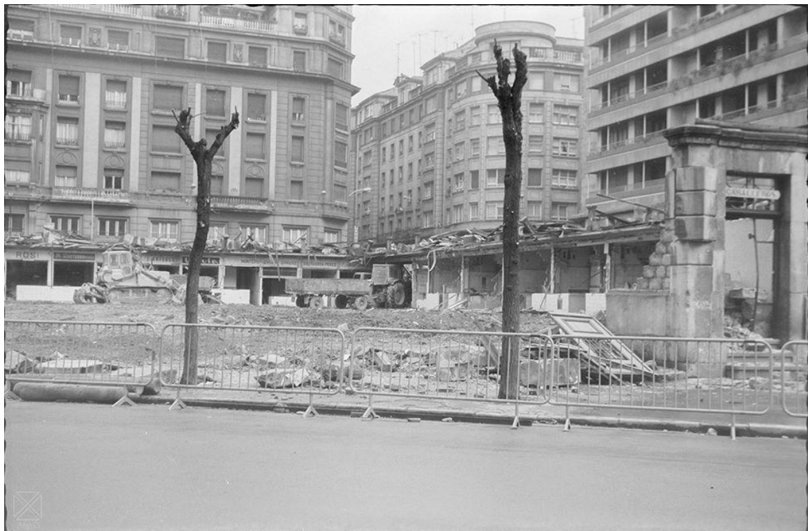
Calle plaza de Los Fueros.-1975-derribos
