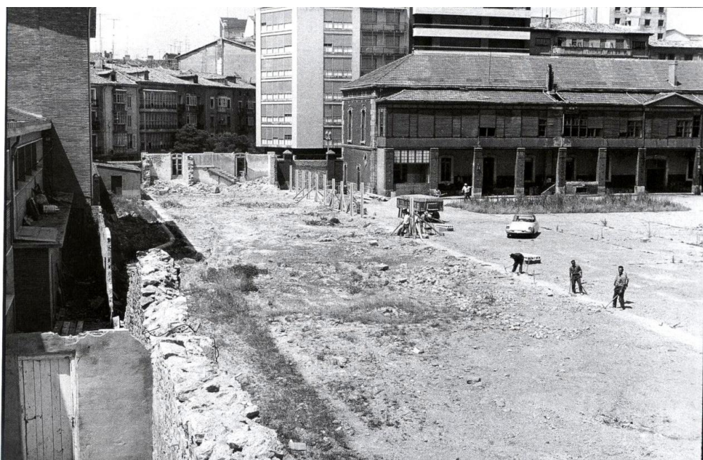
Calle plaza de Santa Bárbara.-Derribos para la construcción del nuevo Mercado de Abastos. 1973.
