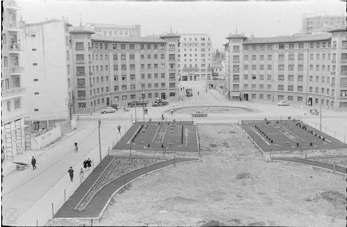
Calle plaza Juan de Ayala en construcción.-5-7-1960
