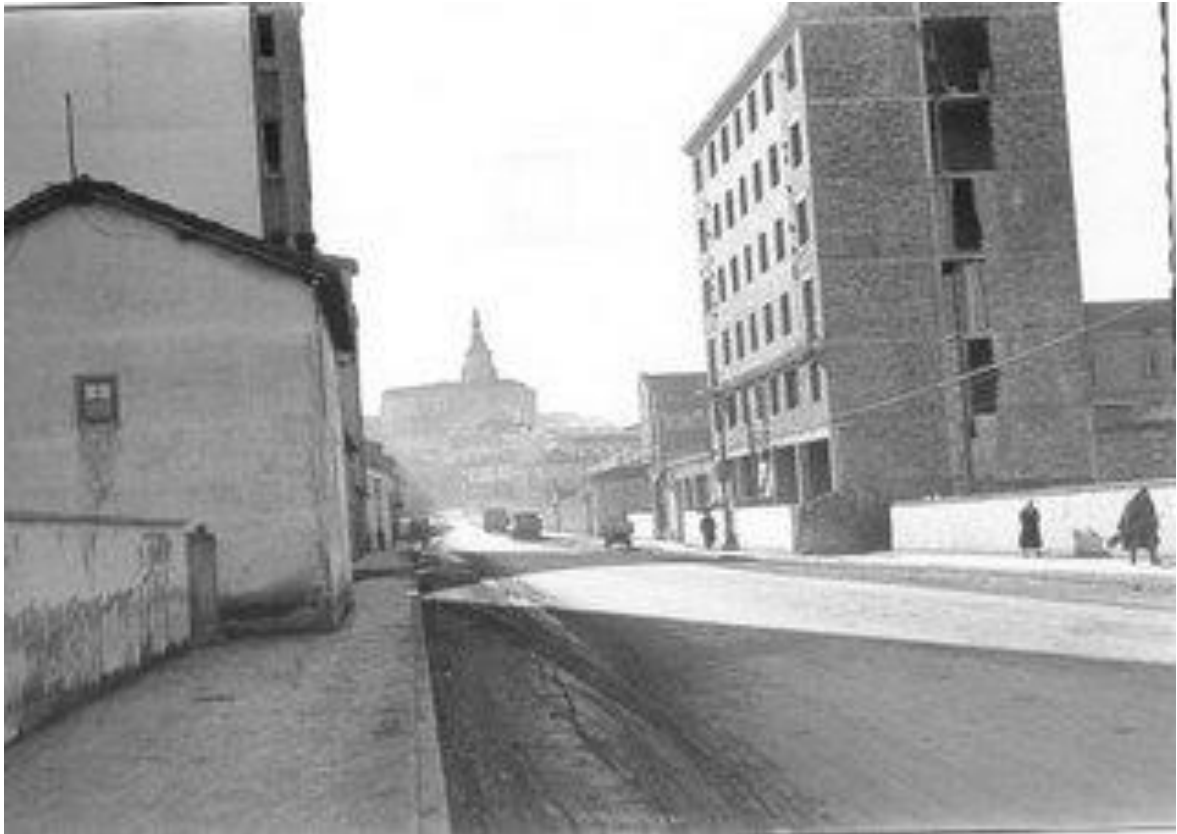
Calle Portal de Arriaga con calle Coronación
