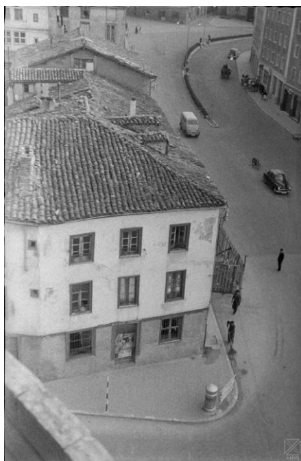
Vitoria-Gasteiz, calle Portal de Arriaga.-24-8-1959
