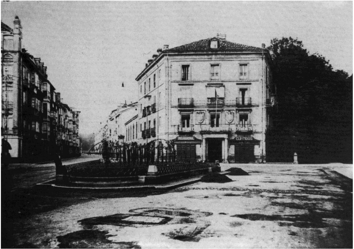
Calle Plaza General Loma
