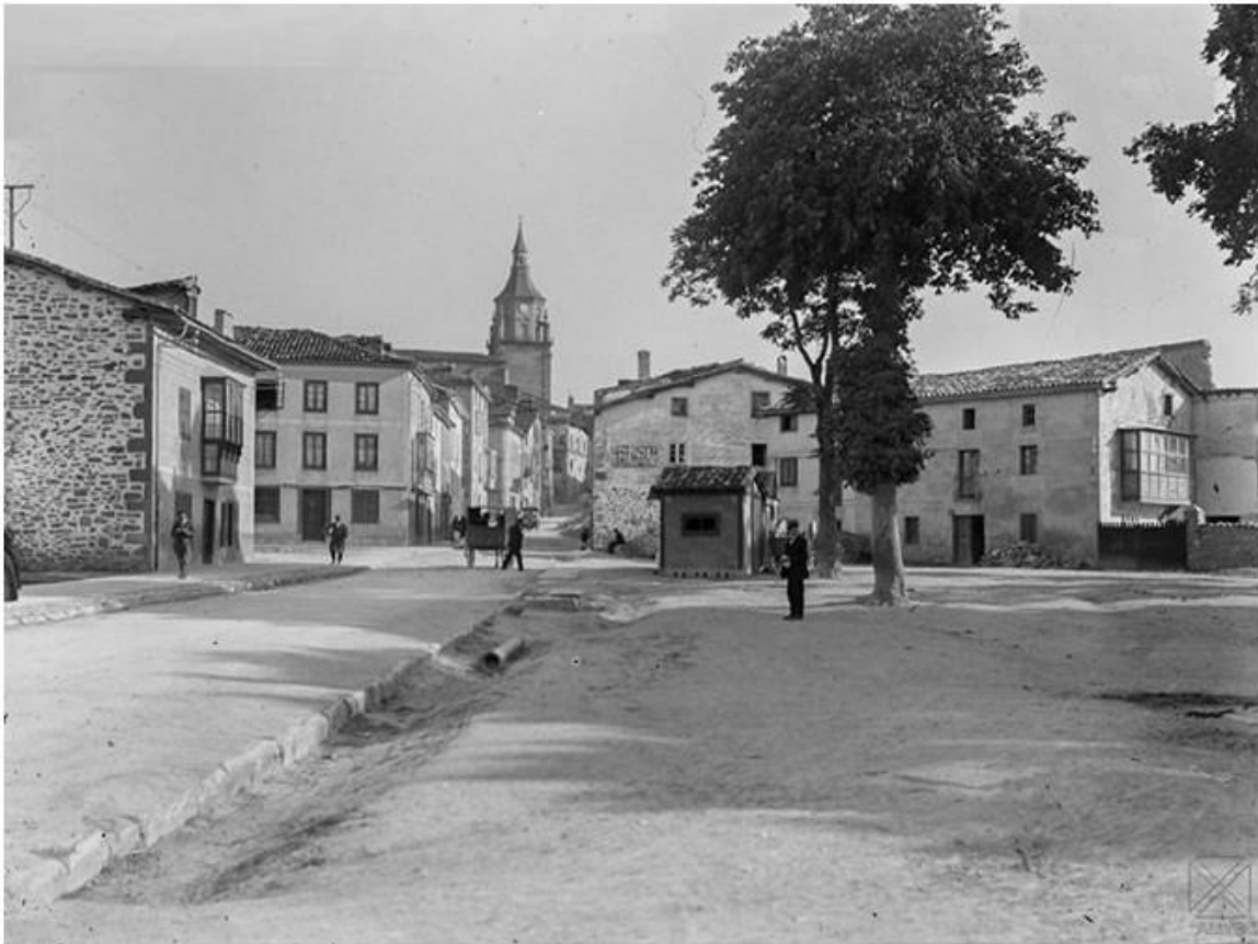
Vitoria-Gasteiz, obras en la calle Portal de Arriaga.
