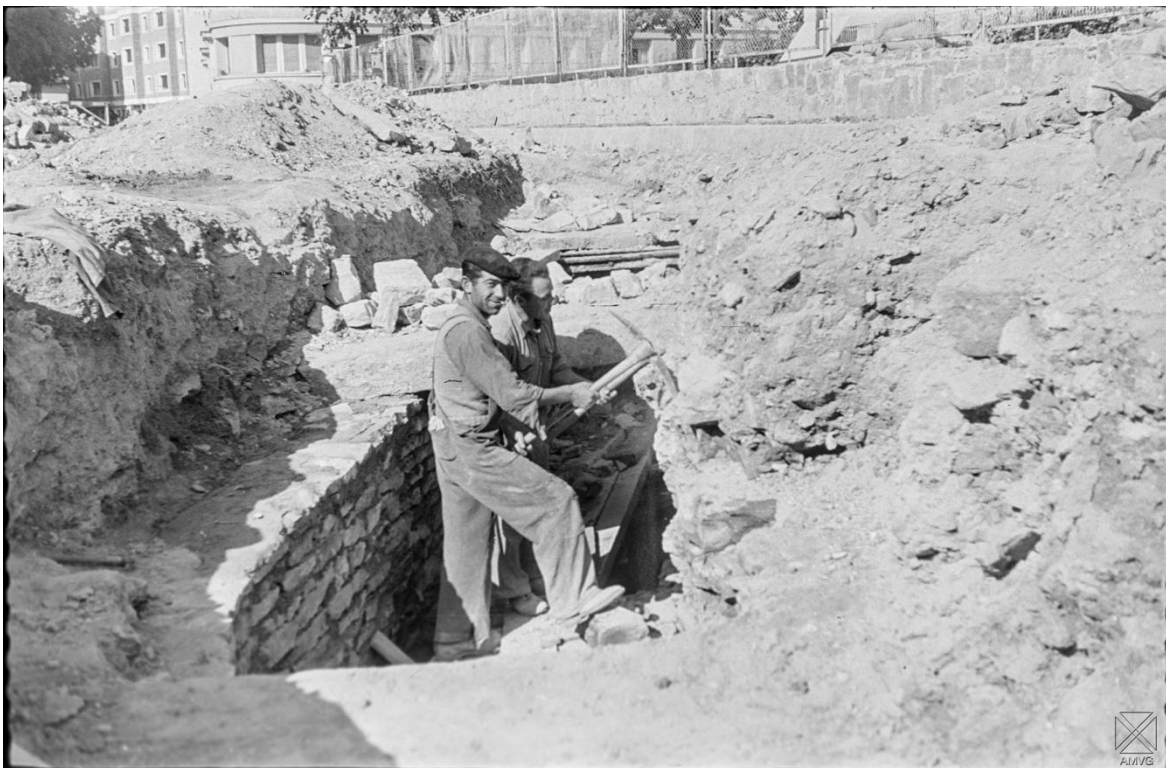
Vitoria-Gasteiz, obras en la calle Portal de Arriaga.-18-6-1956
