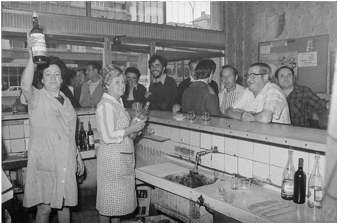
Calle Portal de Villarreal, 48.-Bodegón Gaona
