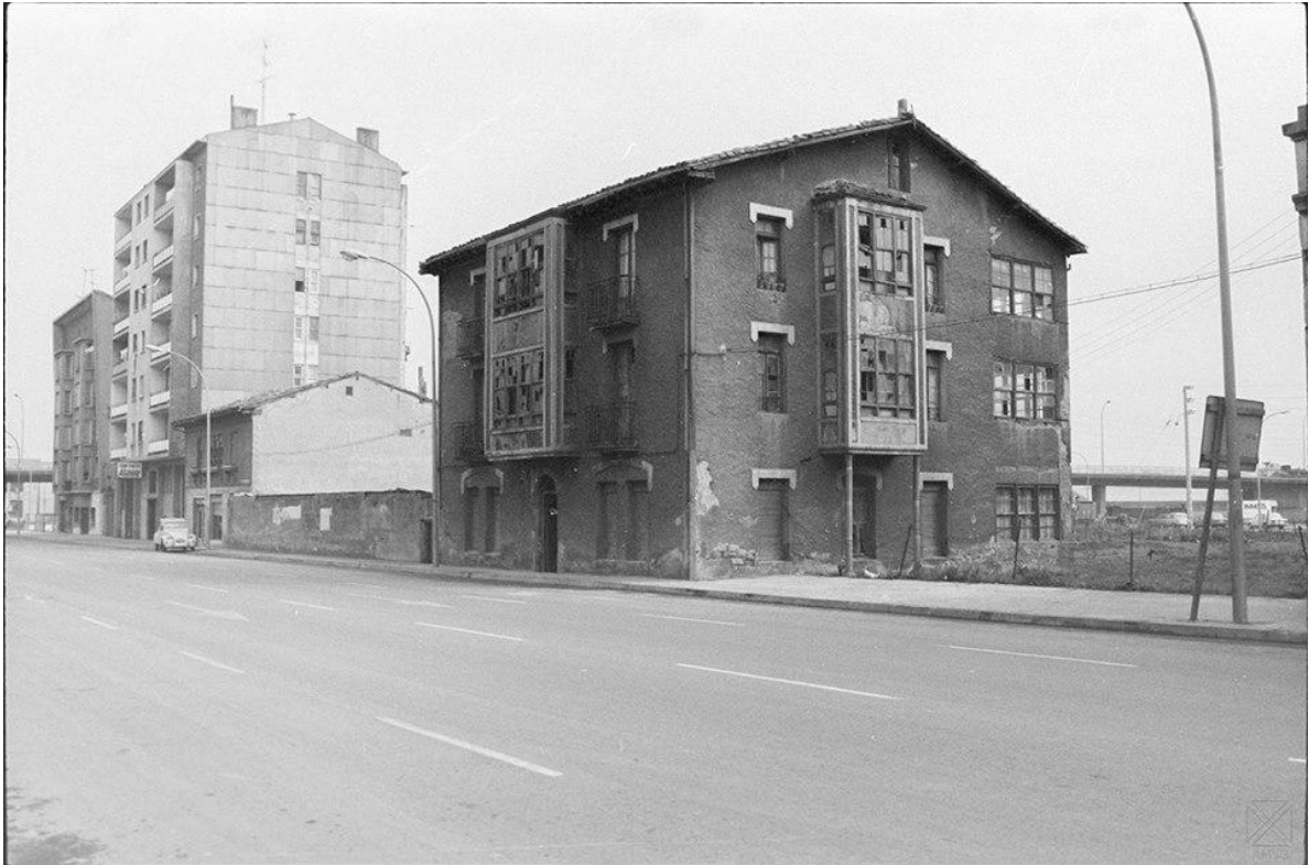
Calle portal de gamarra-enfrente de antigua central lechera
