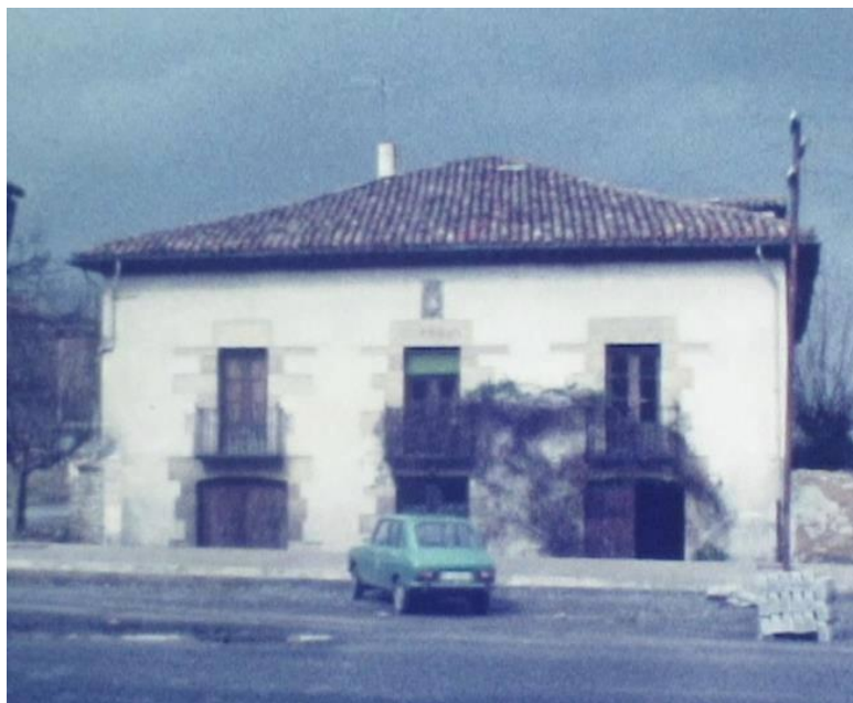
Calle portal de castilla-Etxezaharra- casa Napoleón
