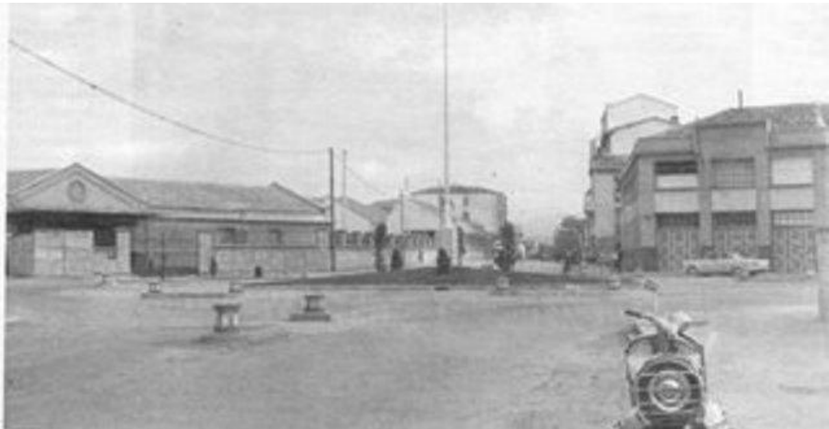
Calle portal de villarreal-esquina del matadero
