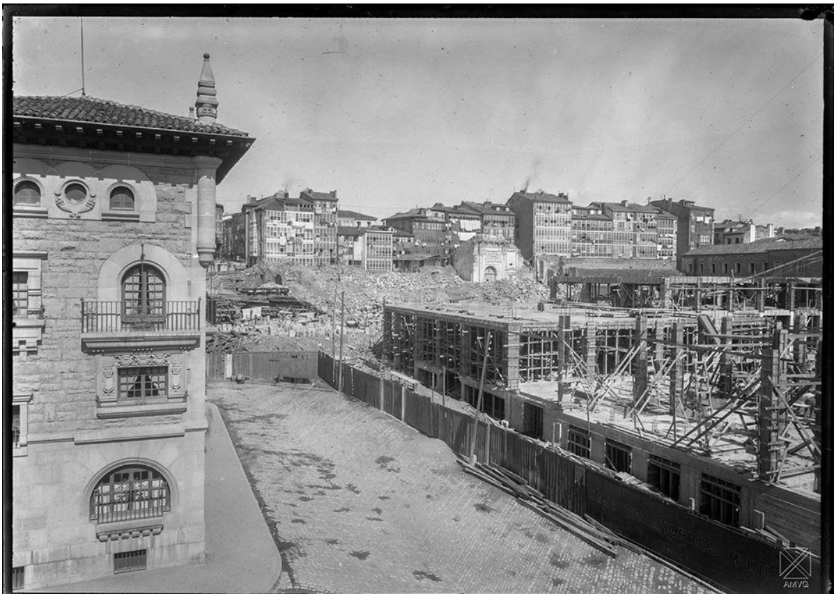
Calle postas.-edificio de la Caja de Ahorros Municipal en construcción.-1931
