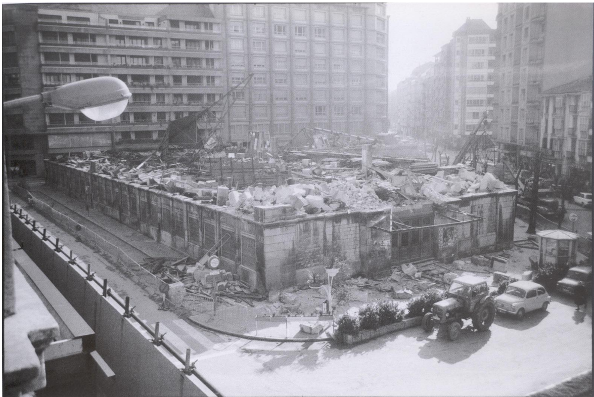
149. Derribo del edificio de la Plaza de Abastos. Febrero de 1975.
