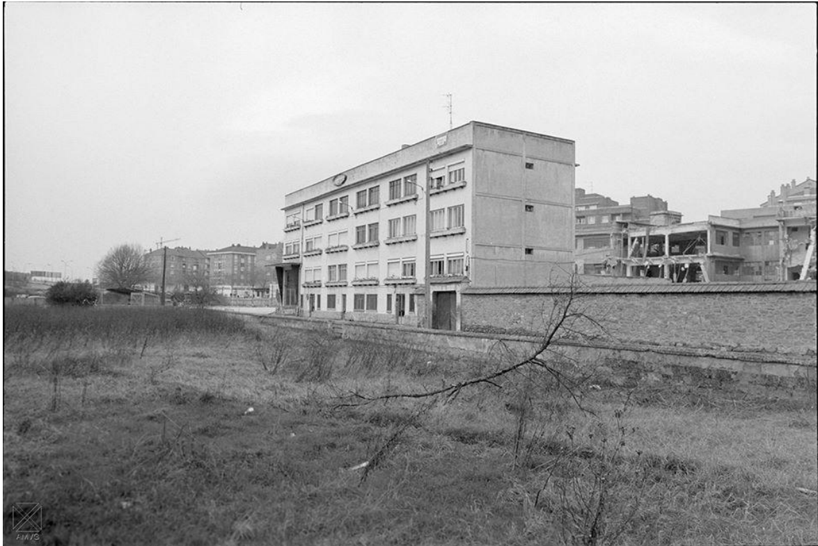
Calle portal de castilla.-derribo de la fábrica de Areitio.-11-2-1993
