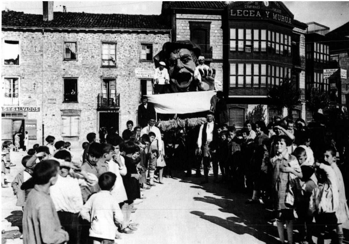
Calle portal de Villarreal-Francia.-El Gargantúa
