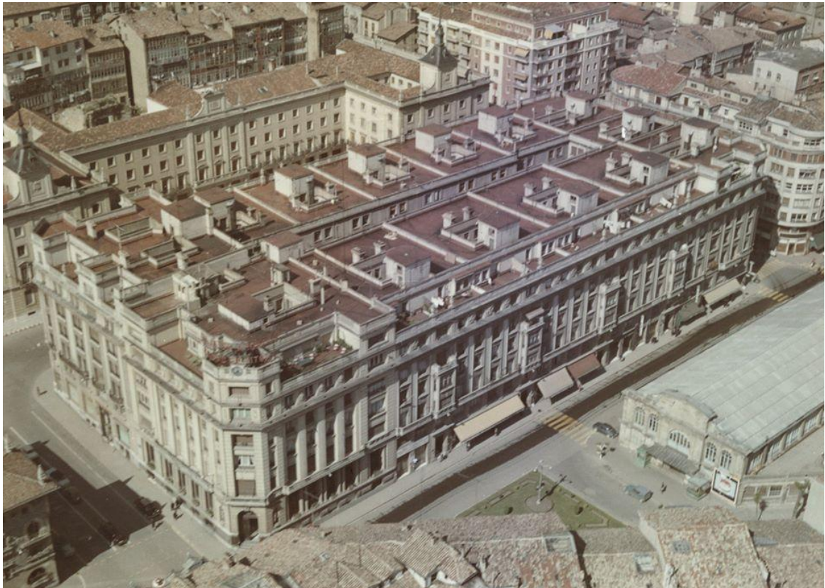
Calle postas-calle Marqués de Estella y caja municipal de vitoria , vista aerea foto 1962
