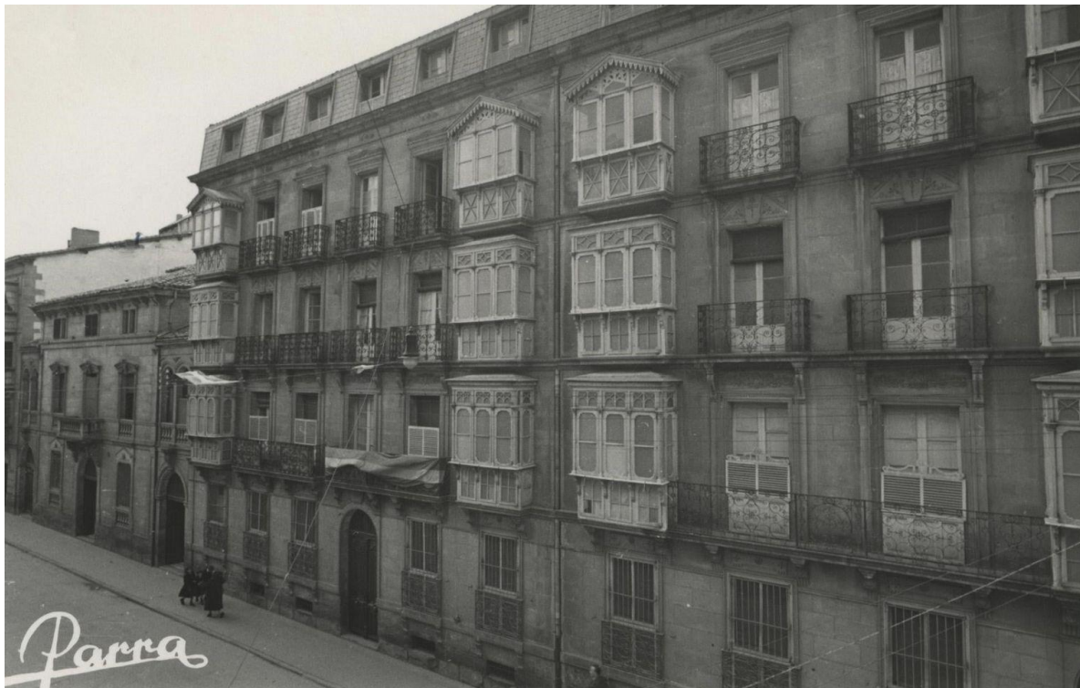
Calle San Antonio, Convento de María Reparadora y Casa de la Música (1960)
