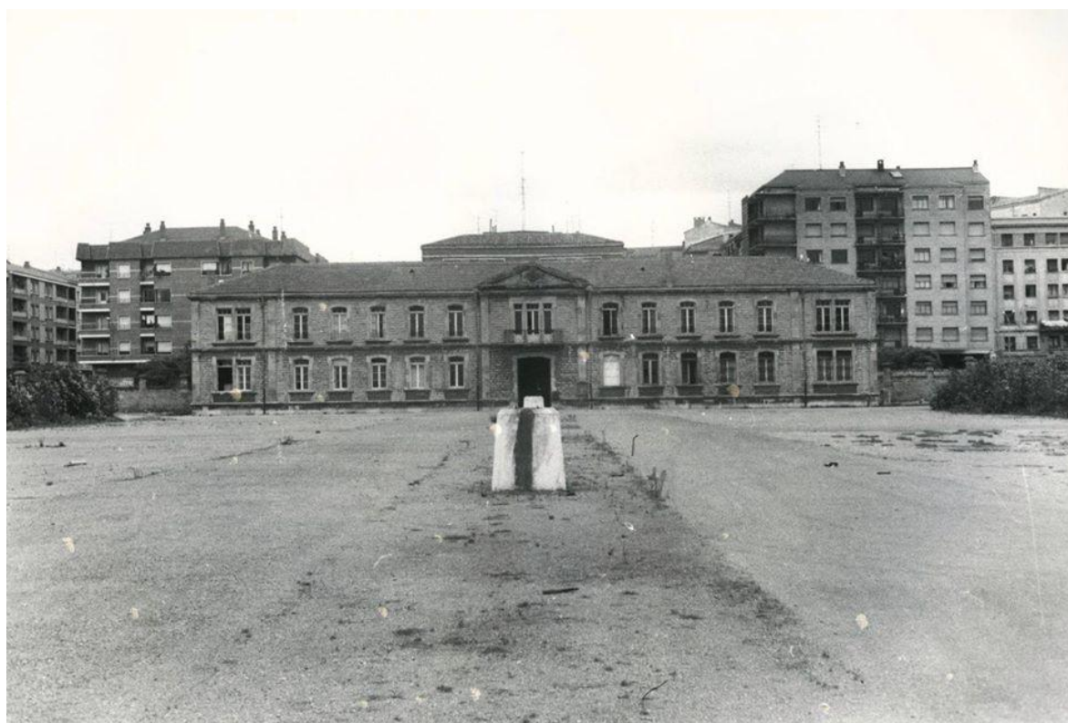
Cuarteles de Sancho el Sabio antes de su derribo en 1977.
