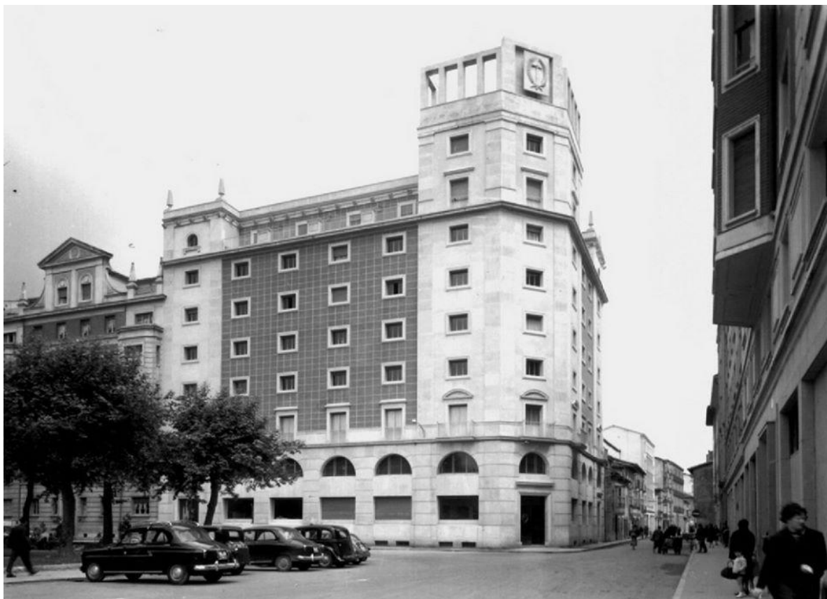
Calle Samaniego. Edificio sindicatos-años 50
