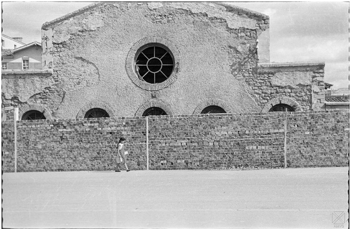
Calle Samaniego.-28-8-1956-lavadero publico
