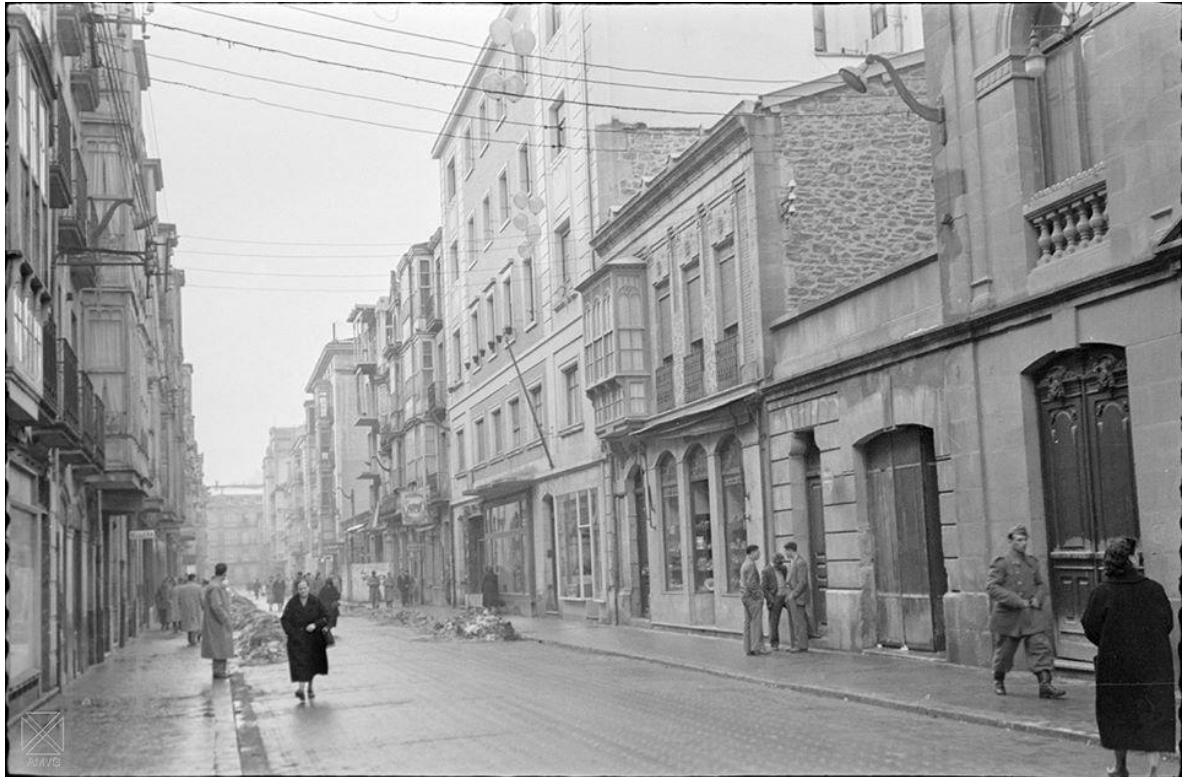
Calle San Prudencio.-27-1-1957-en obras
