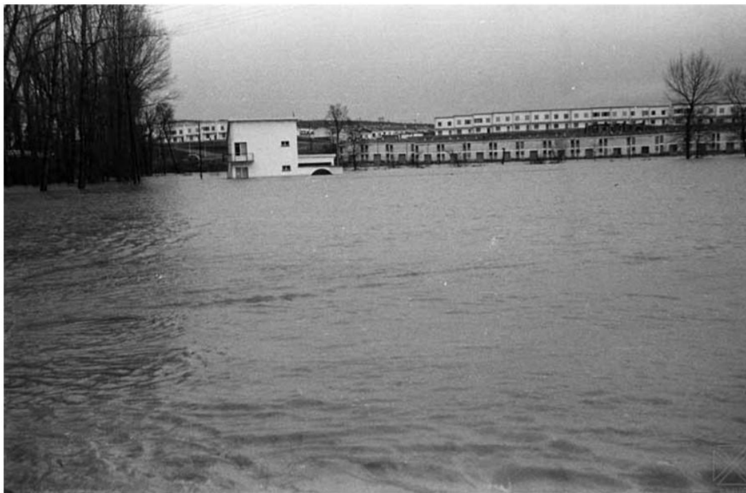
Desbordamiento del río Zadorra a su paso por Abechuko. 30 de diciembre de 1960. Foto Santiago Arina y Albizu. AMVG.
