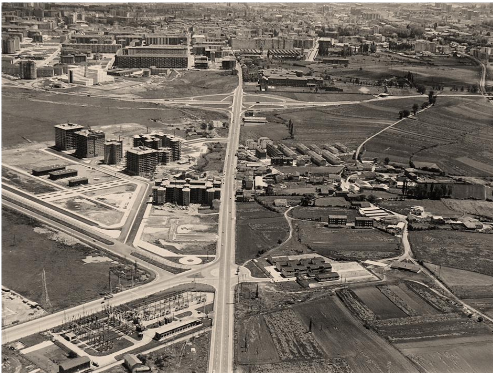
Barrio de Sansomendi en construcción.
