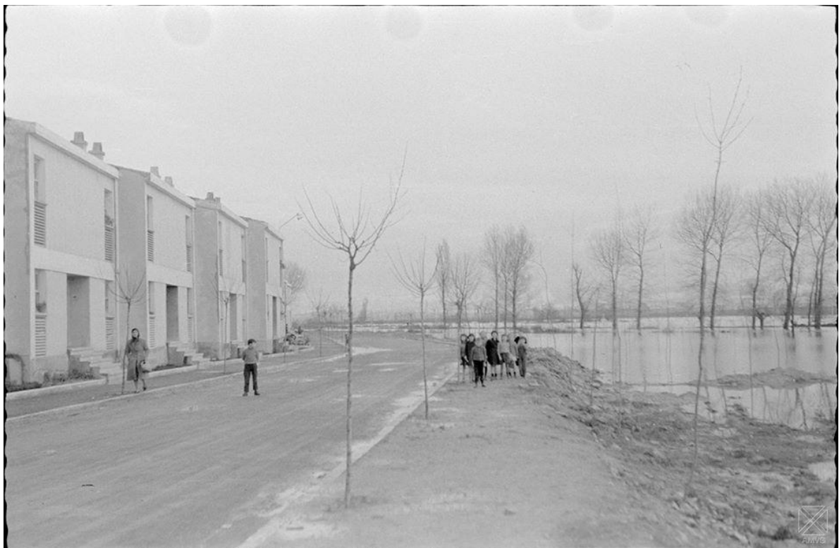
Inundaciones en el barrio de Abechuco.-23-4-1960
