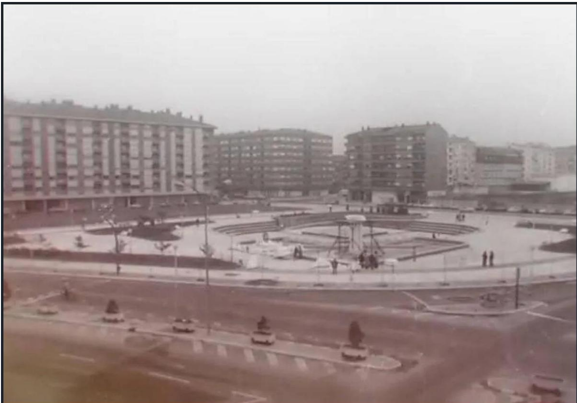
Barrio del Pilar. Plaza de la Constitución en construcción.
