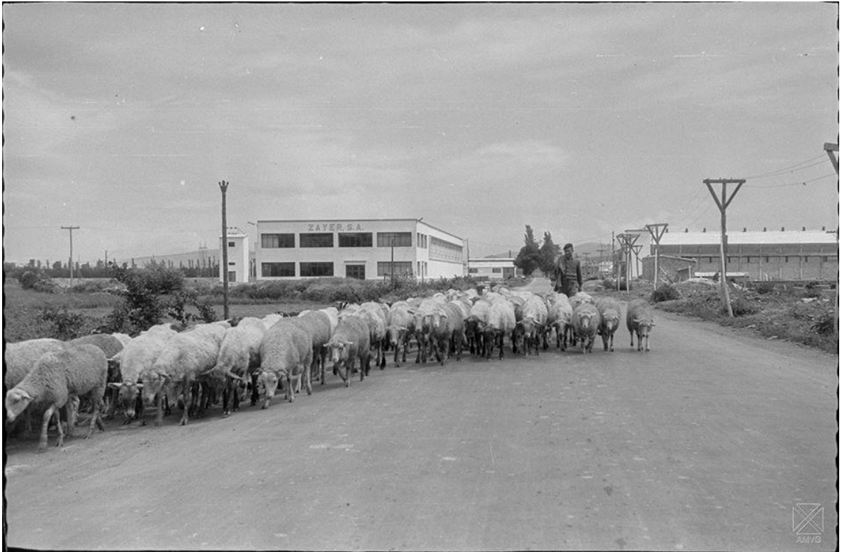
Barrio de Betoño. Zona industrial. 19-4-1958
