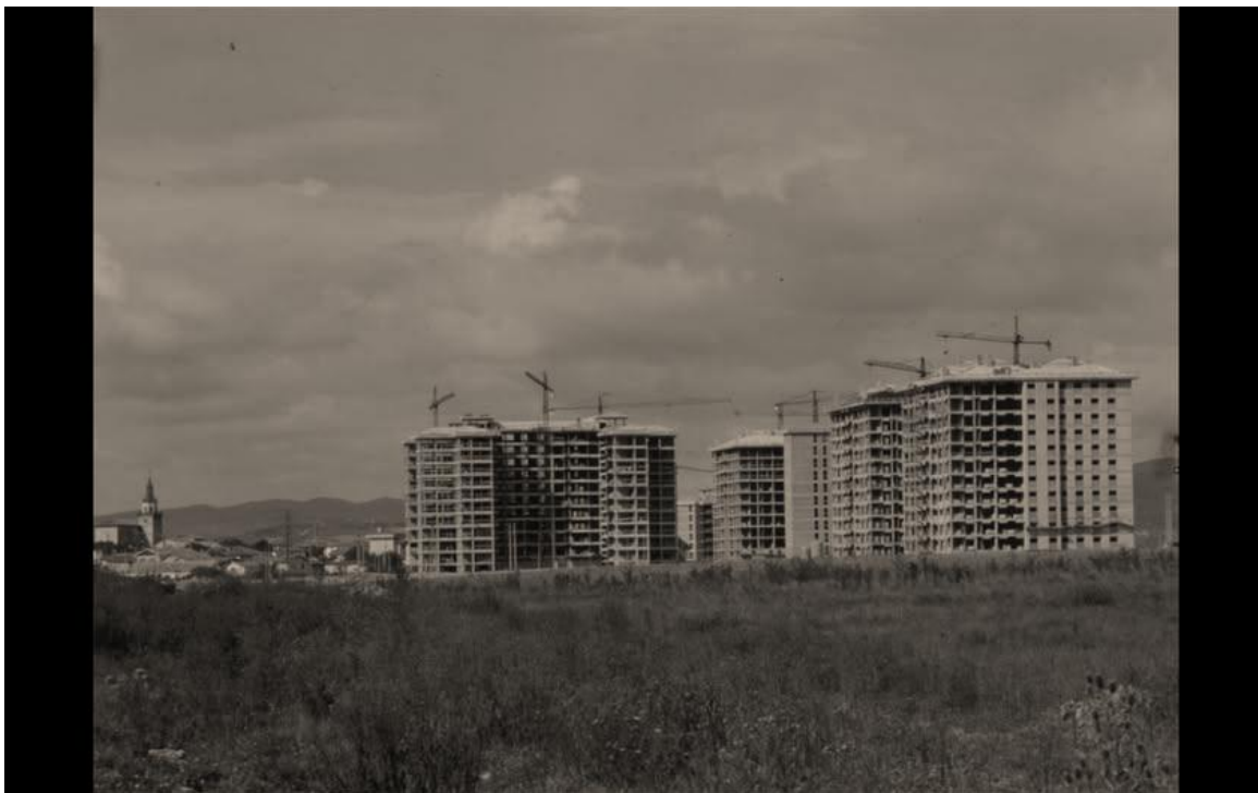
Barrio de Sansomendi en construcción
