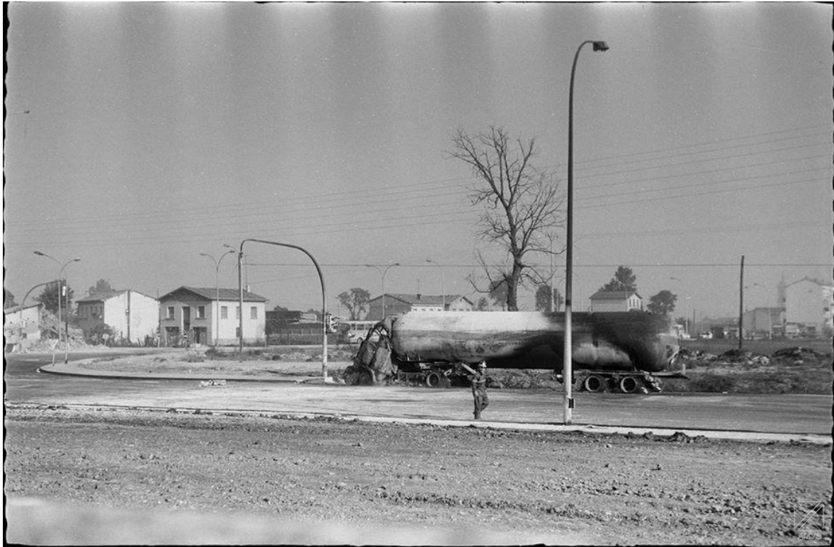
Vitoria-Gasteiz, barrio de Zaramaga, restos del gran accidente.1974
