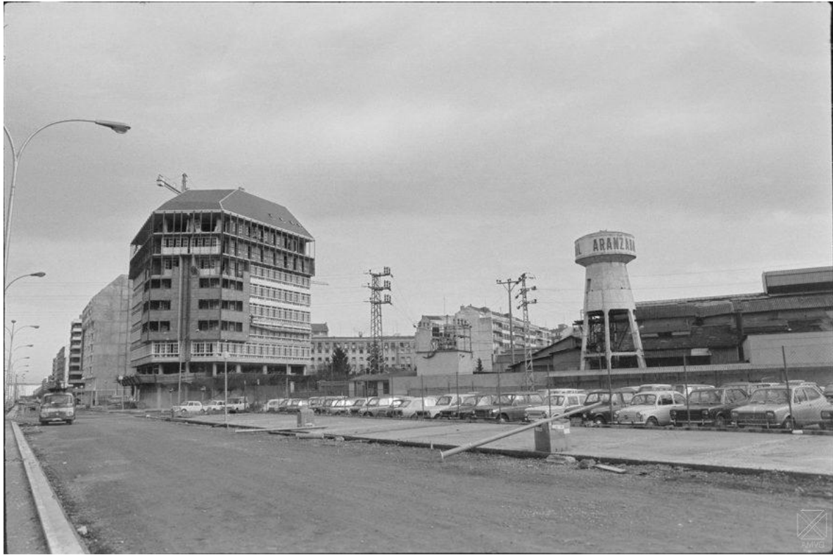
Avenida de Gasteiz y antiguo depósito de agua de Aranzabal en 1978. ARQUÉ. AMVG.
