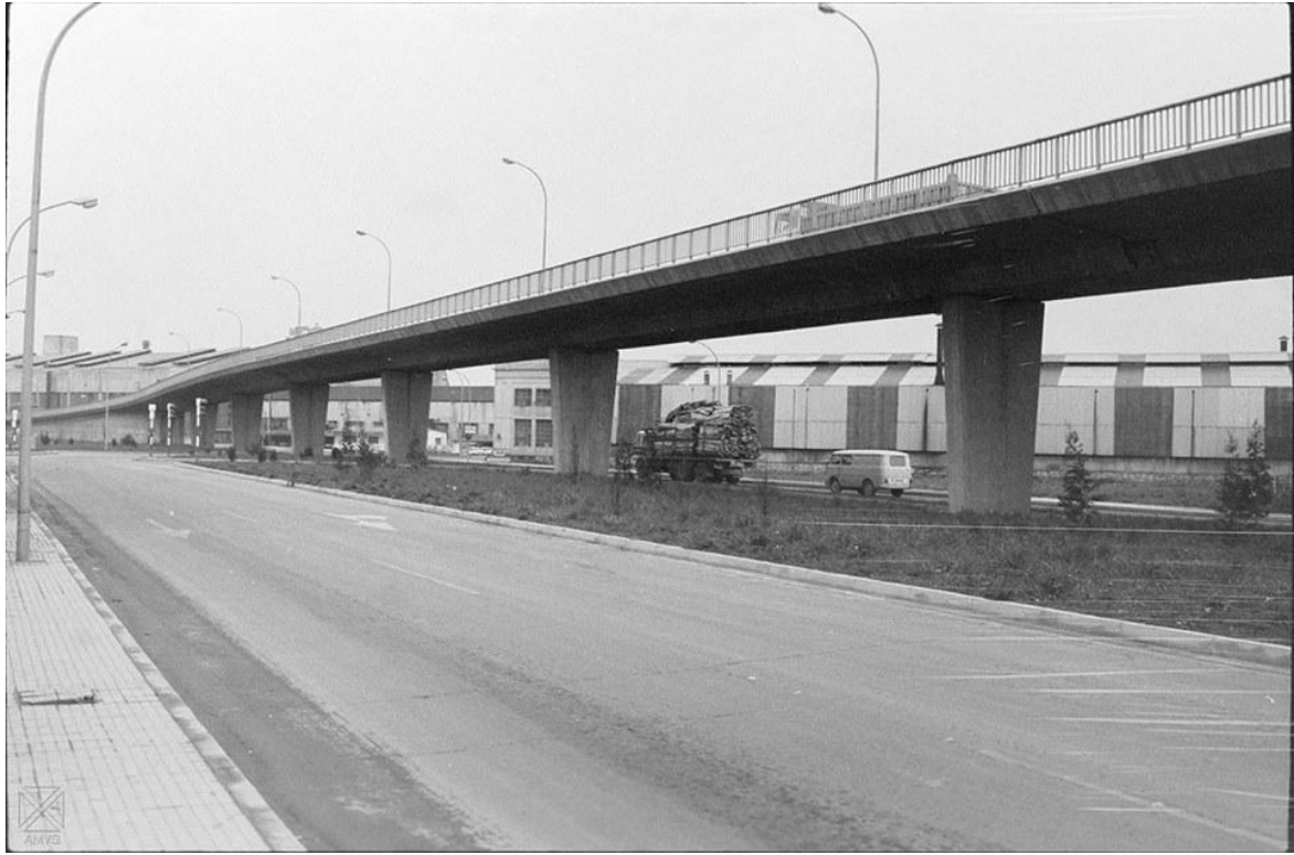
Barrio de Zaramaga. Puente Conocido como Scalectrix
