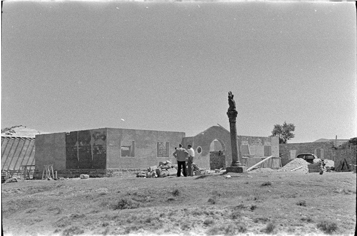
Barrio de Armentia. Construcción de casas en Armentia.-julio-1947
