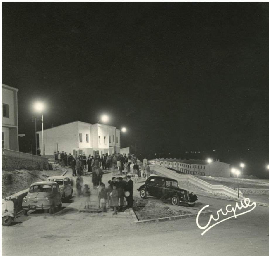
Barrio de Abechuco.-ALUMBRADO ELECTRICO-1959
