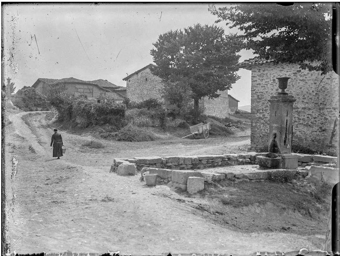
Barrio Ali.-1920. Antigua fuente.
