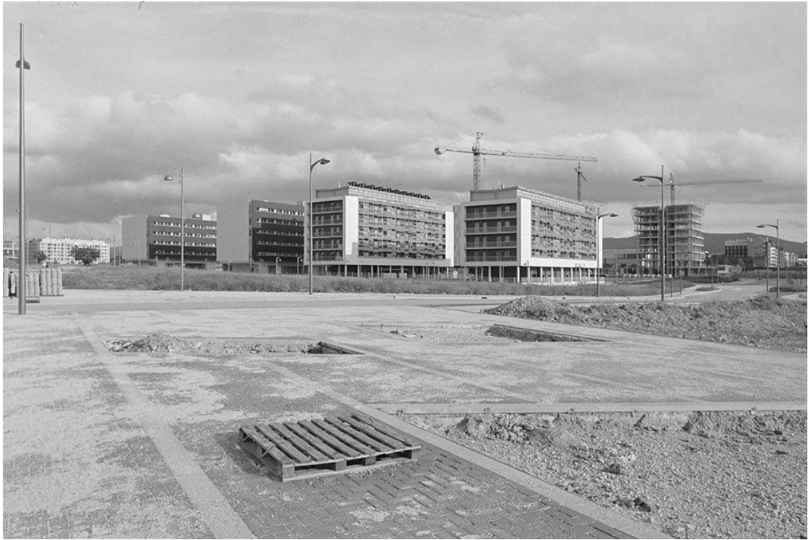
Barrio de Zabalgana en construcción.-junio 2010
