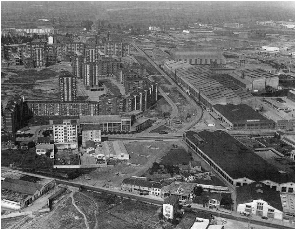
Barrio de Aranbizkarra. Empezando a construir el puente Salextric .
