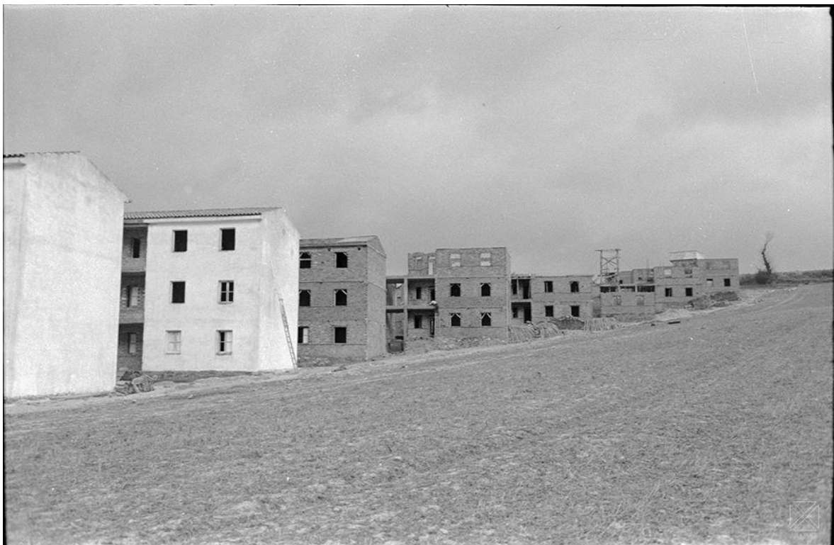
Barrio de Errekalear en construcción.-1959
