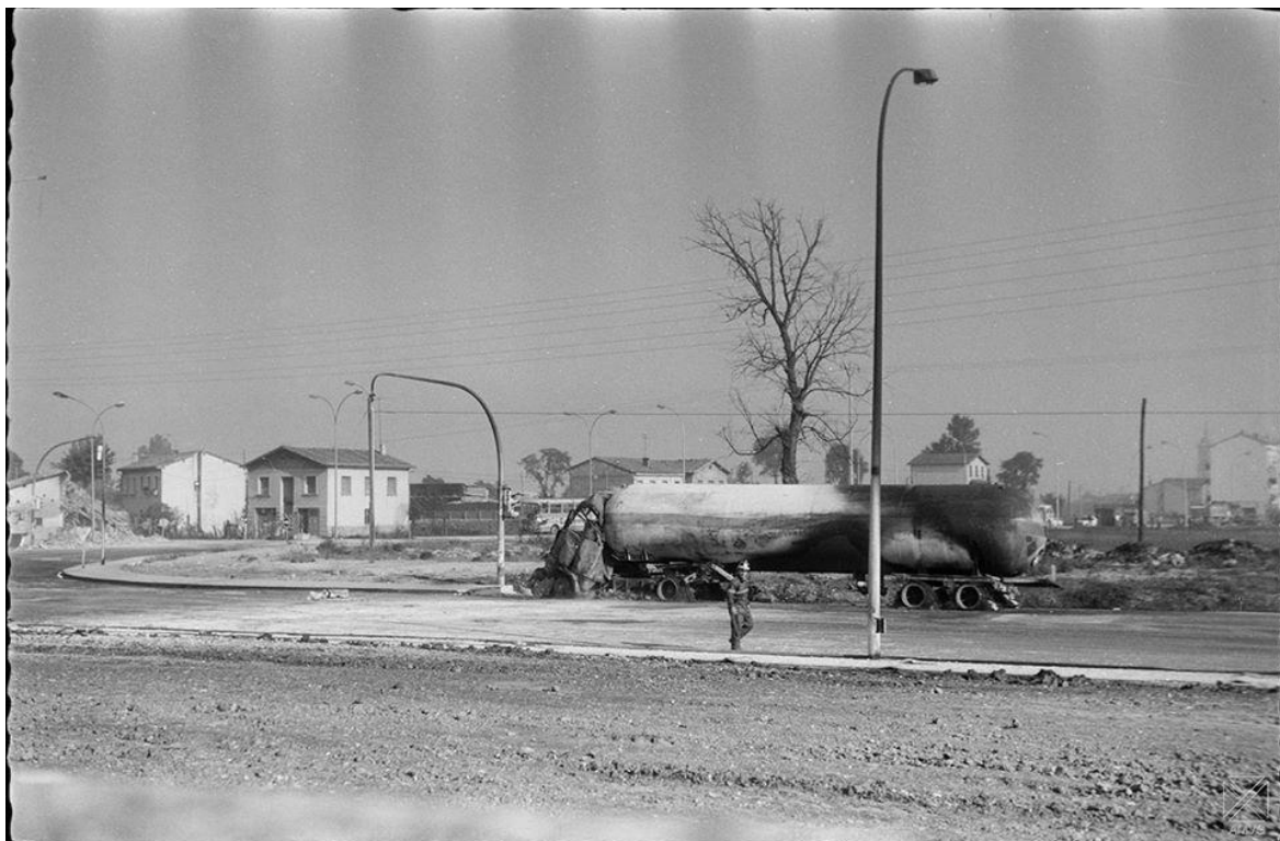
Barrio de Zaramaga, restos del gran accidente.1974
