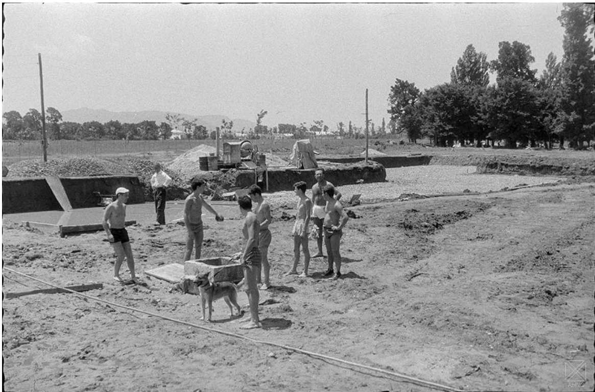
Construcción de las piscinas de Gamarra.-16-6-1962
