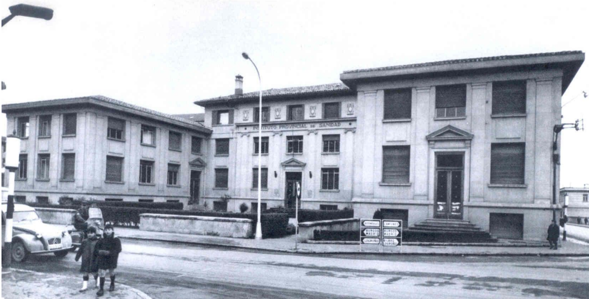
Calle Avenida Santiago.-Instituto Provincial de Sanidad
