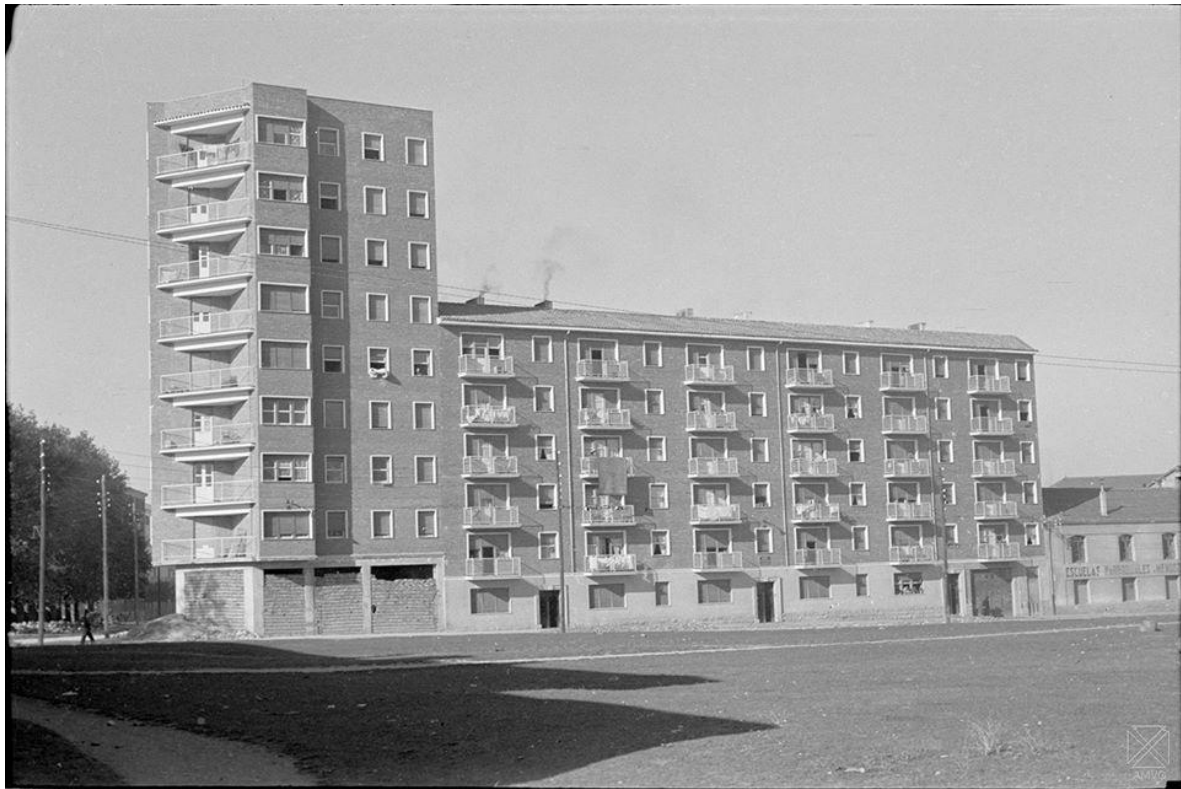
Fechada en 1956. Casa dcha. aneja a la parroquia de san Cristóbal.
