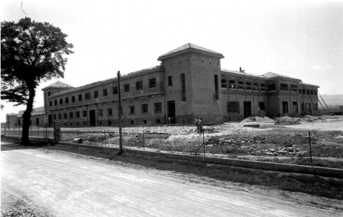
Calle Avenida de los Huetos.- Fabrica Imosa en construccion.
