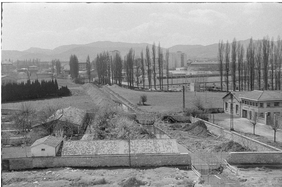
Calle Abendaño-canal del río Abendaño.-24-3-1961
