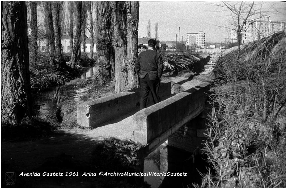
Calle avenida Gasteiz.-Puente sobre el río Chirrio. Se ve la zanja que estaban haciendo Para el desvío y embocinamiento del río. Entre los arboles los pabellones de Armentia y Corres.
