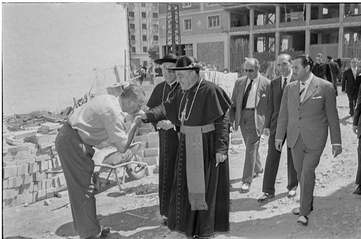
Visita del obispo a las obras de la iglesia de Los Ángeles.1959
