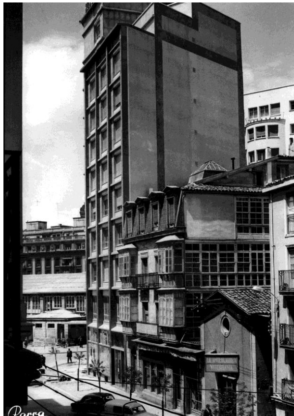
Caja Provincial recién construida 1963
