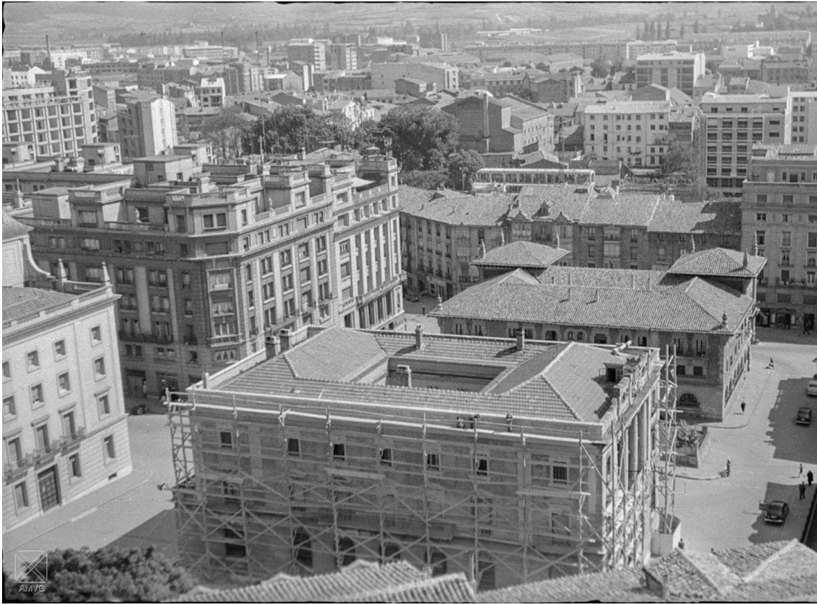
Banco de España en obras. Detrás el edificio de Correos.-20-4-1961
