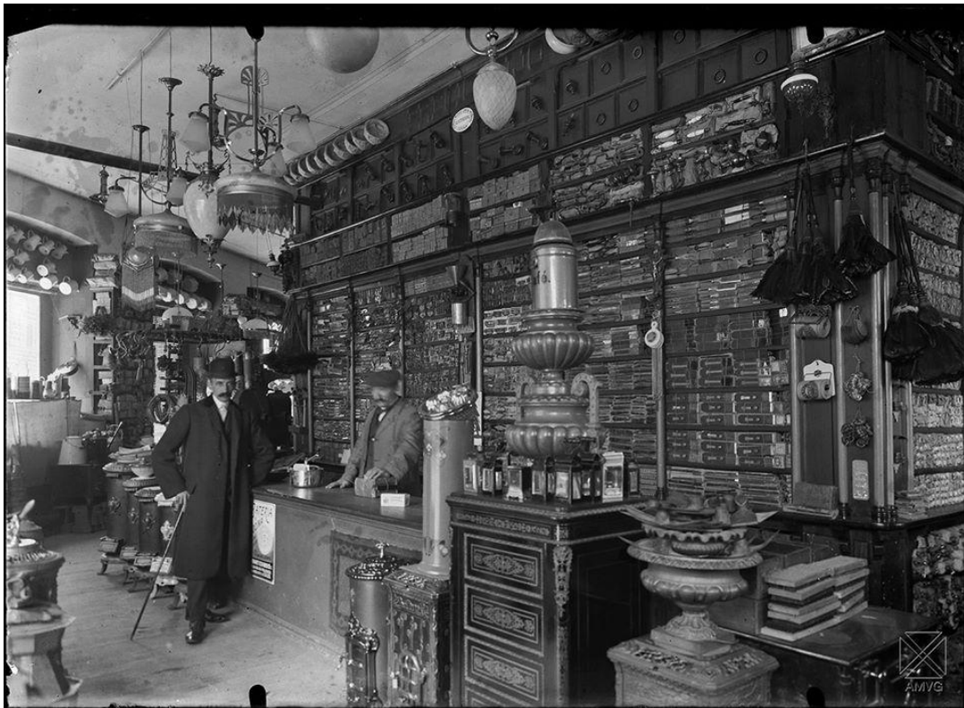
Interior de la ferretería Guinea.1912
