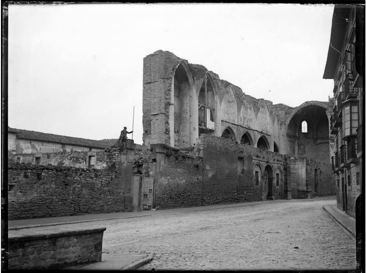
Convento de santo domingo- derribo
