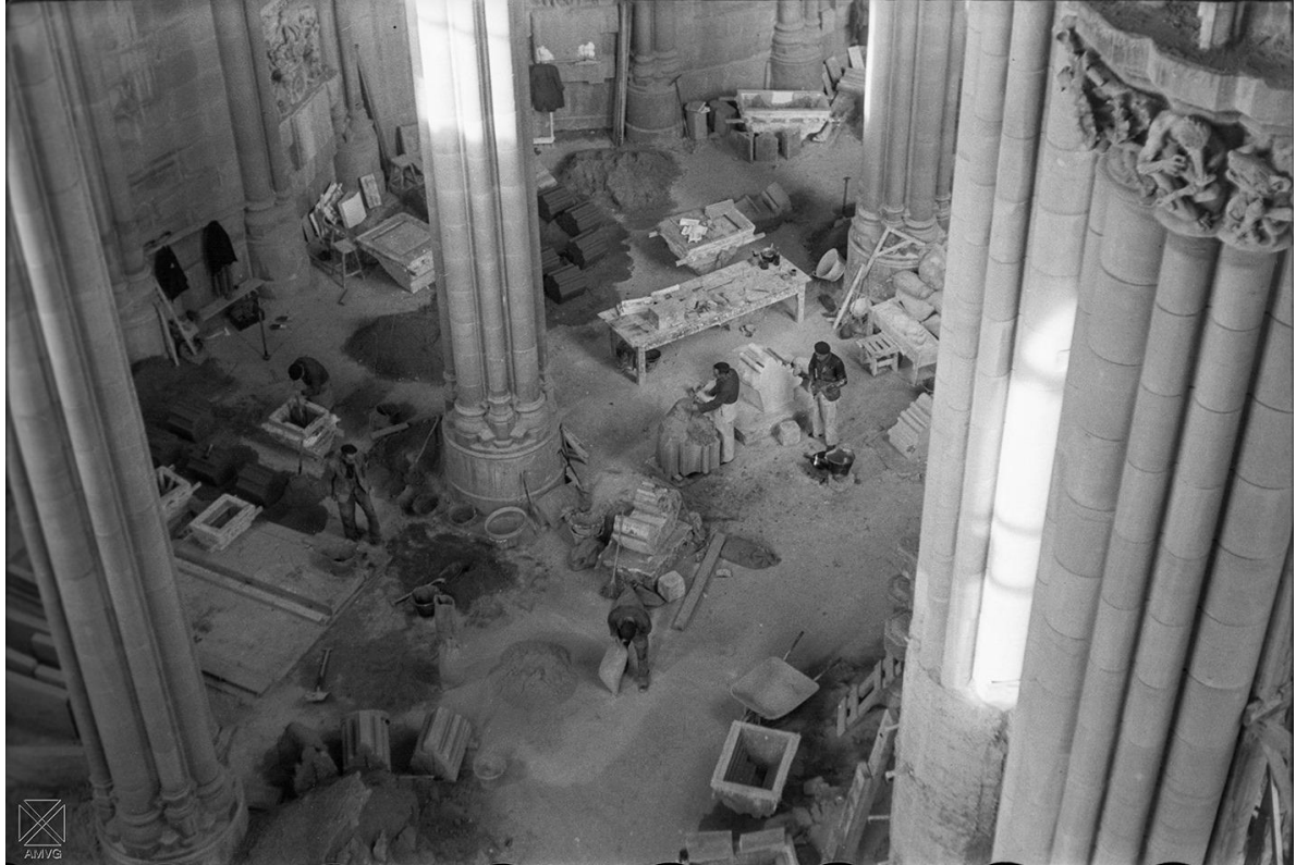
Vitoria-Gasteiz, obras de construcción de la Catedral de M a Inmaculada.-1948
