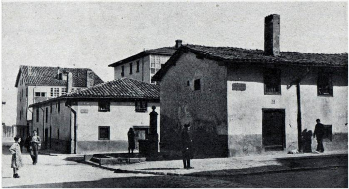
Colegio San Prudencio con Nueva Fuera-1938
