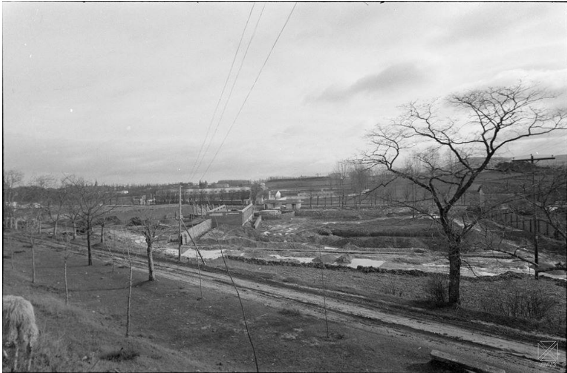
La Sociedad Deportiva Estadio en construcción.-1958
