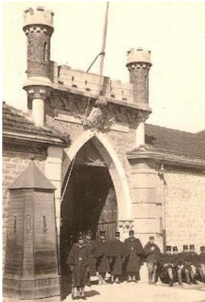
Fachada del Cuartel de Infantería de Guipúzcoa 53, en la Calle de Arechavaleta, actual Comandante Izarduy.
