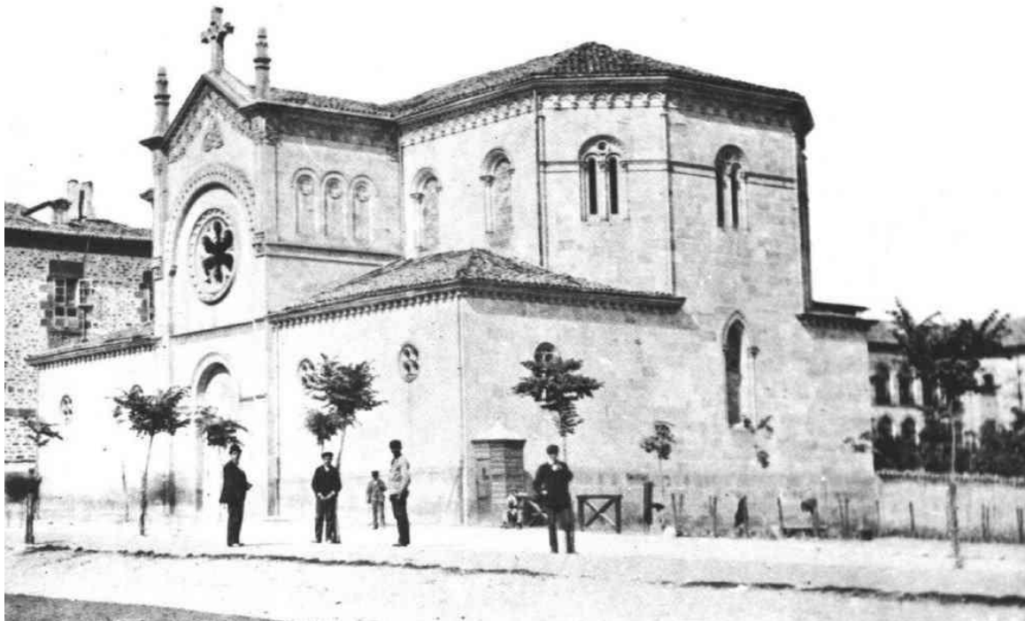
Capilla del hospital.
