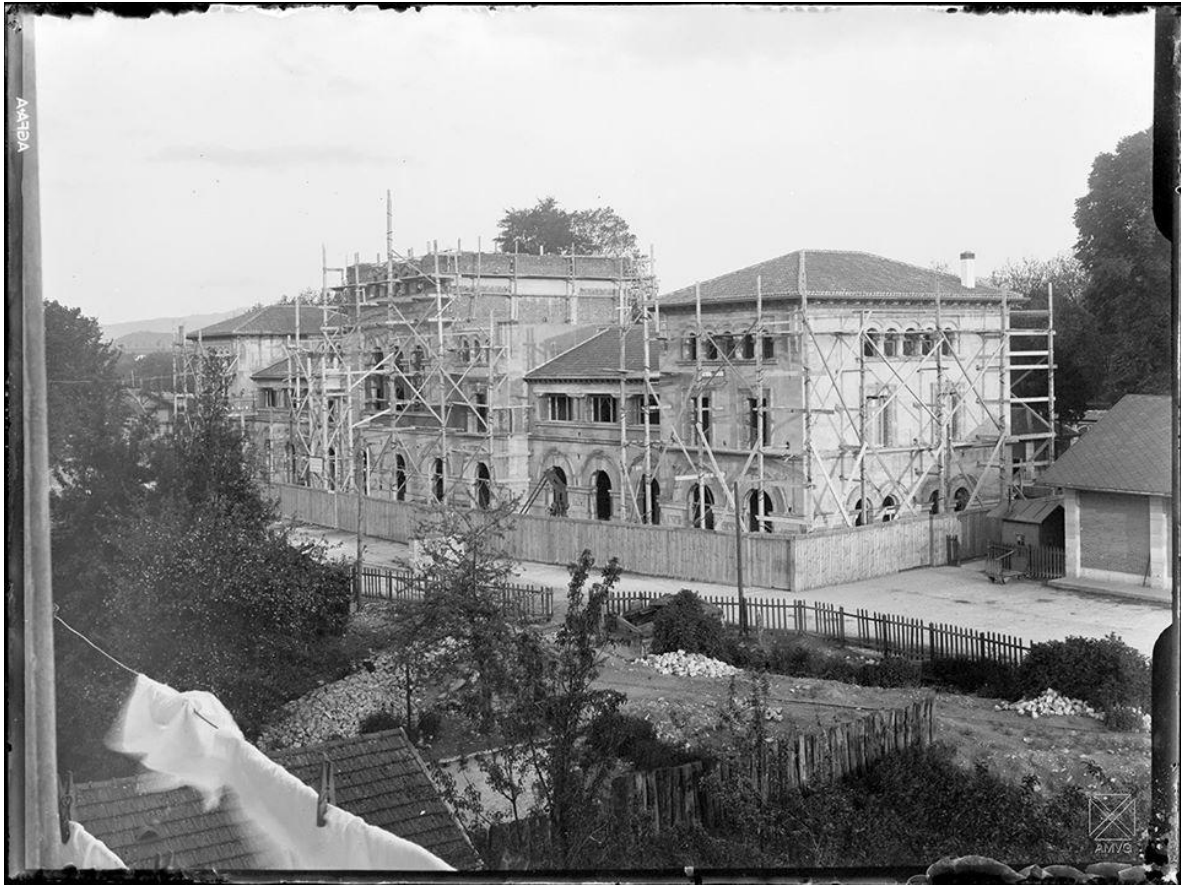
La Estación del Norte en construcción.-1931
