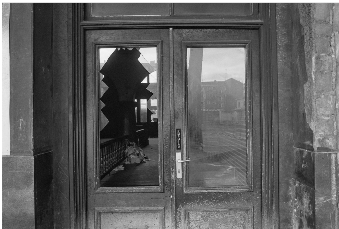
Vitoria-Gasteiz, entrada al vestíbulo de la antigua Estación de Autobuses en ruinas.-1994
