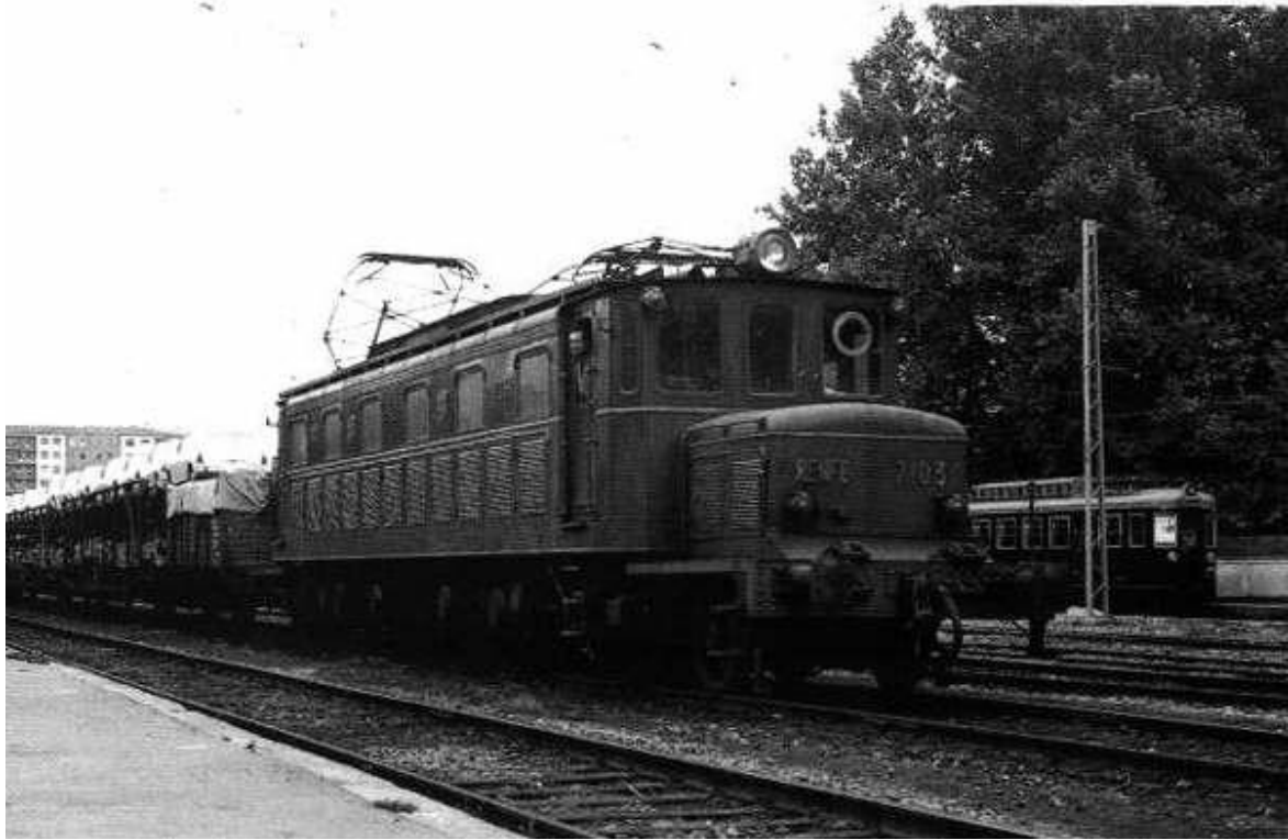
Estación de Vitoria-Norte. En primer plano. Al fondo una unidad del Vasco-Navarro
