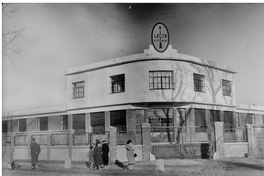
Pirotecnia de Lecea. Estado en el que quedó la fábrica tras la explosión en la que fallecieron seis trabajadores.-1953
