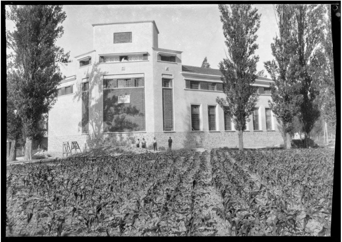
Era la subestación eléctrica de Ajuria, permaneció hasta finales de los 70
