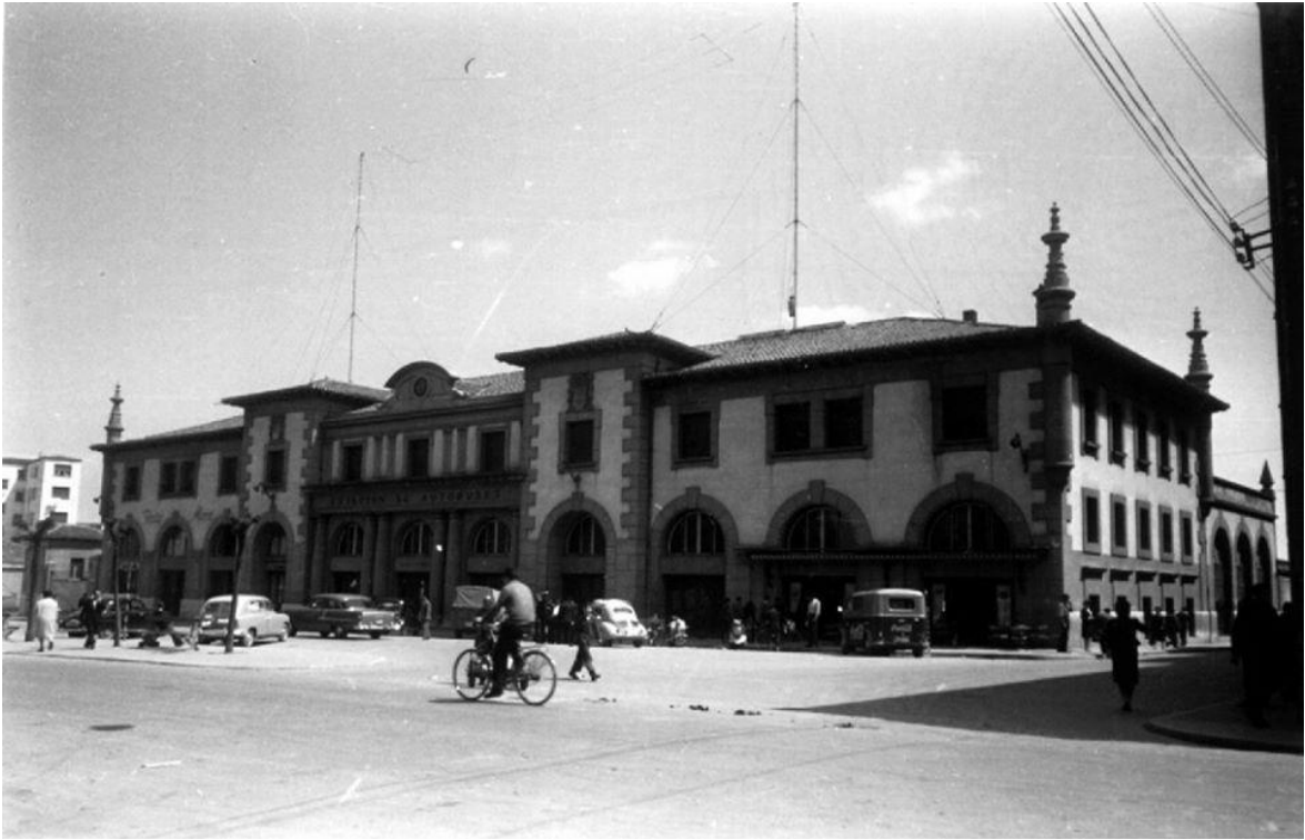
Estación de Autobuses en la calle Francia-1959
