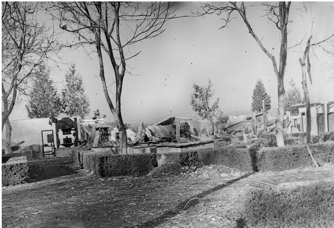
Pirotecnia de Lecea. Estado en el que quedó la fábrica tras la explosión en la que fallecieron seis trabajadores.
