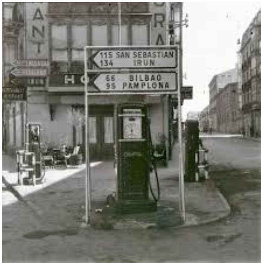
Gasolinera florida con Ortiz de Zarate.
