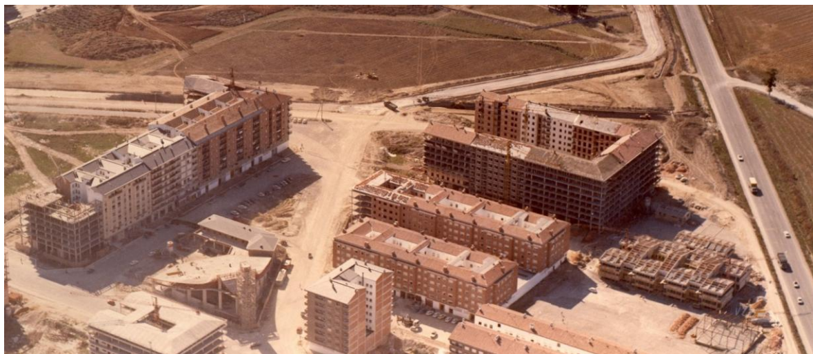
El barrio del Pilar en plena construcción. Nacional-1 a la derecha y la iglesia del pilar a la izda.
