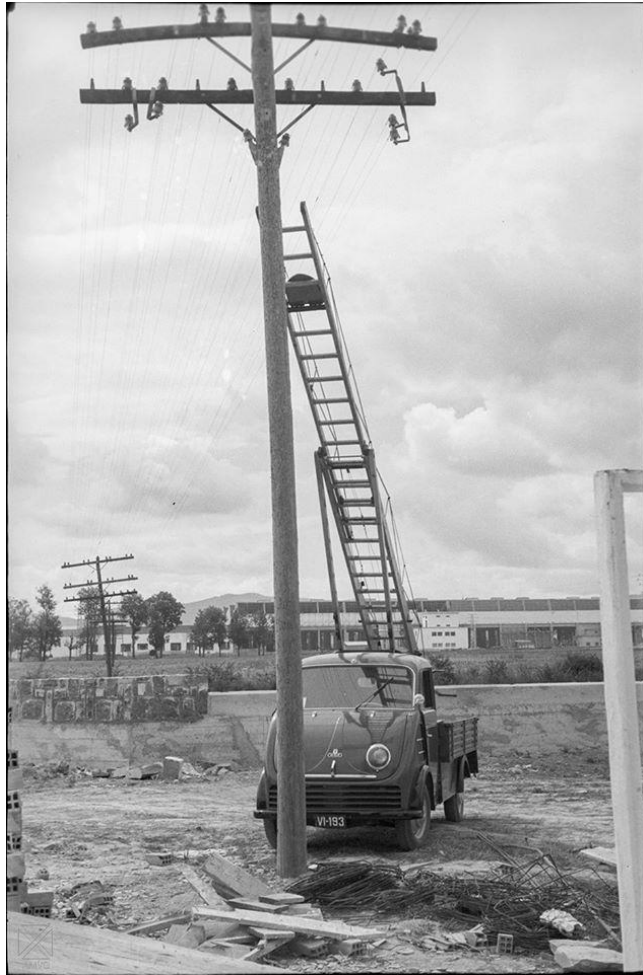
Colocación de postes de telefonía.-septiembre 1957
