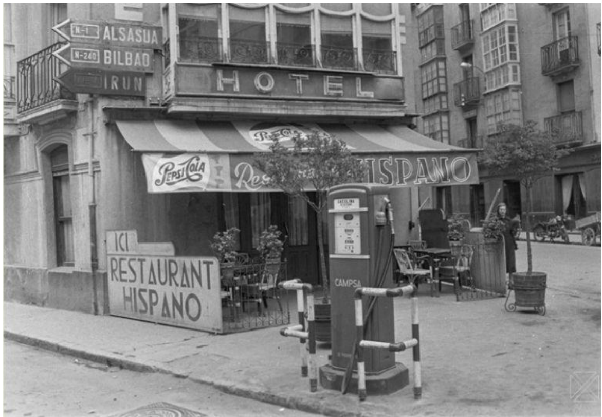
Gasolinera florida con Ortiz de Zarate.
