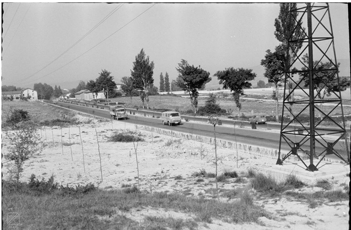
Carretera de Madrid.-17-5-1965
