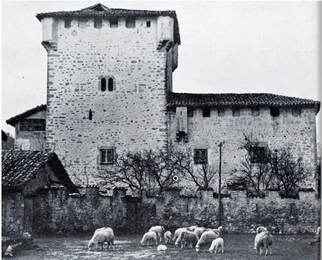
Villanañe.-Torre de los Varona en Villanañe en el Valle de Valdegobia.-1962
