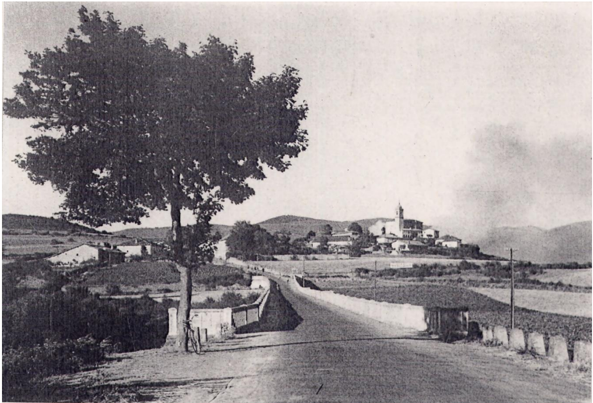
Puente de GANGARIBAI al fondo barrio de Kaminoa
