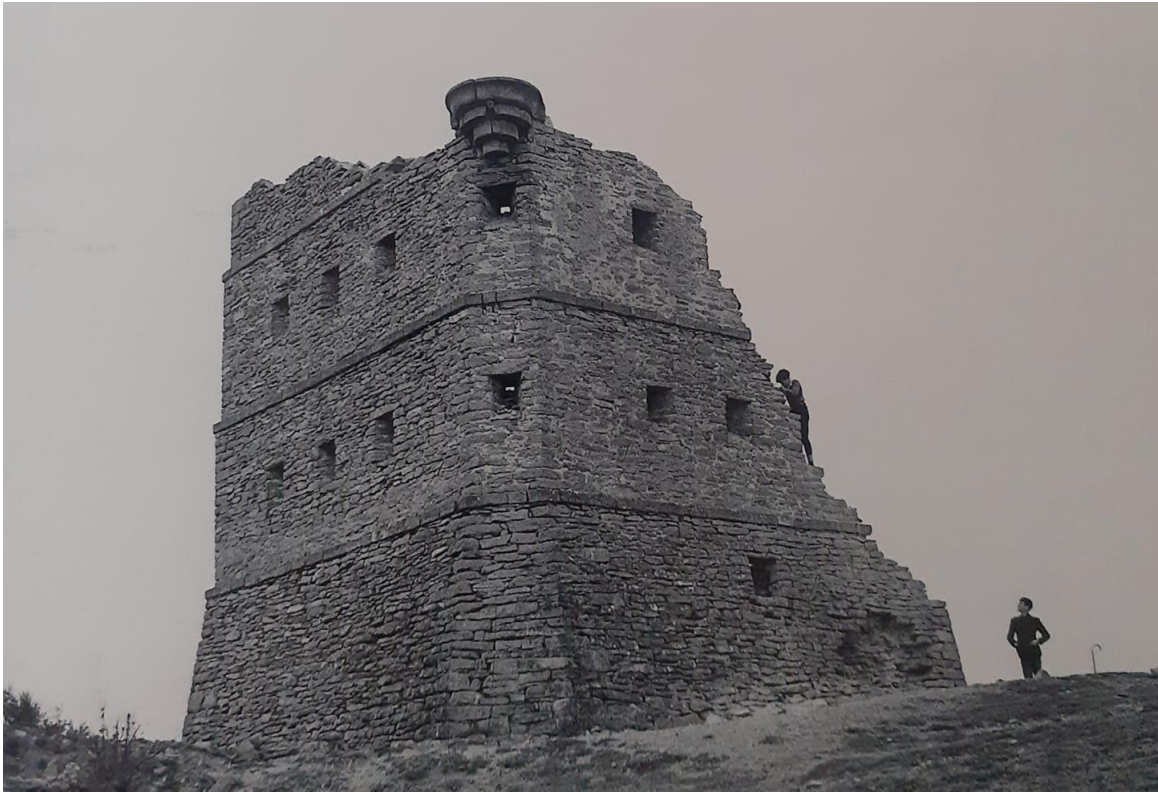
Eskivel.-Torre del telégrafo óptico de Eskibel
