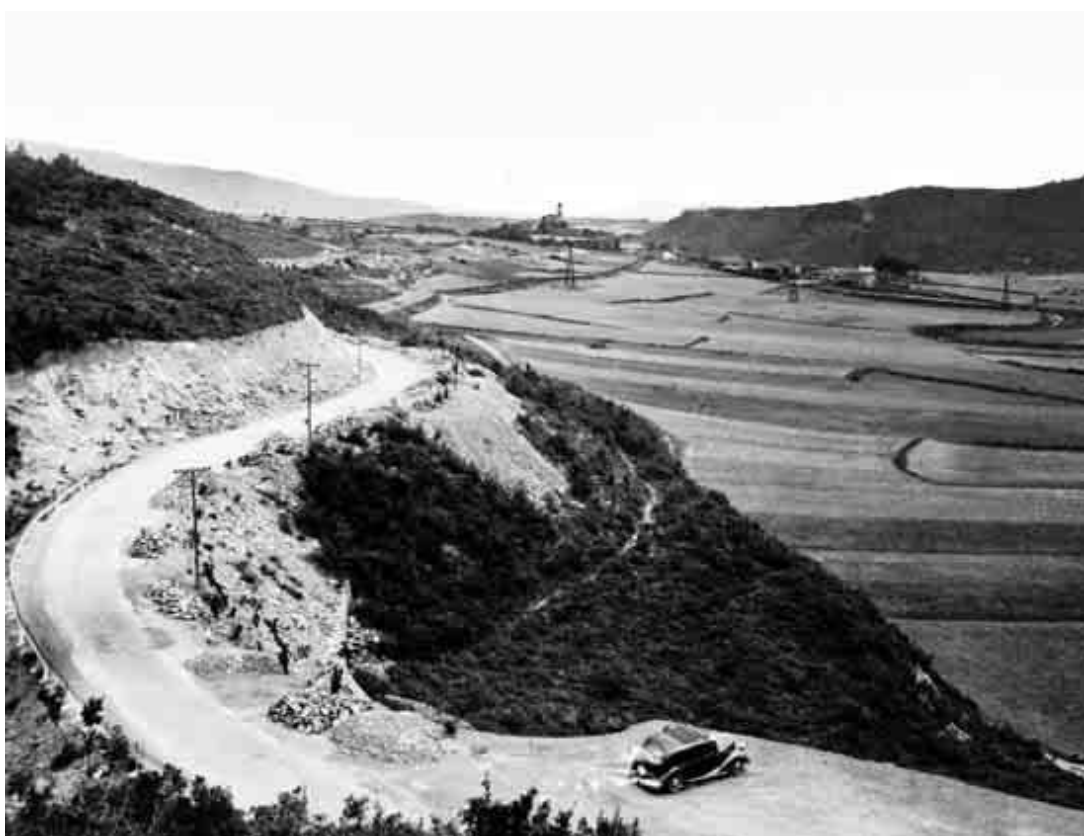
Obra de nueva carretera
