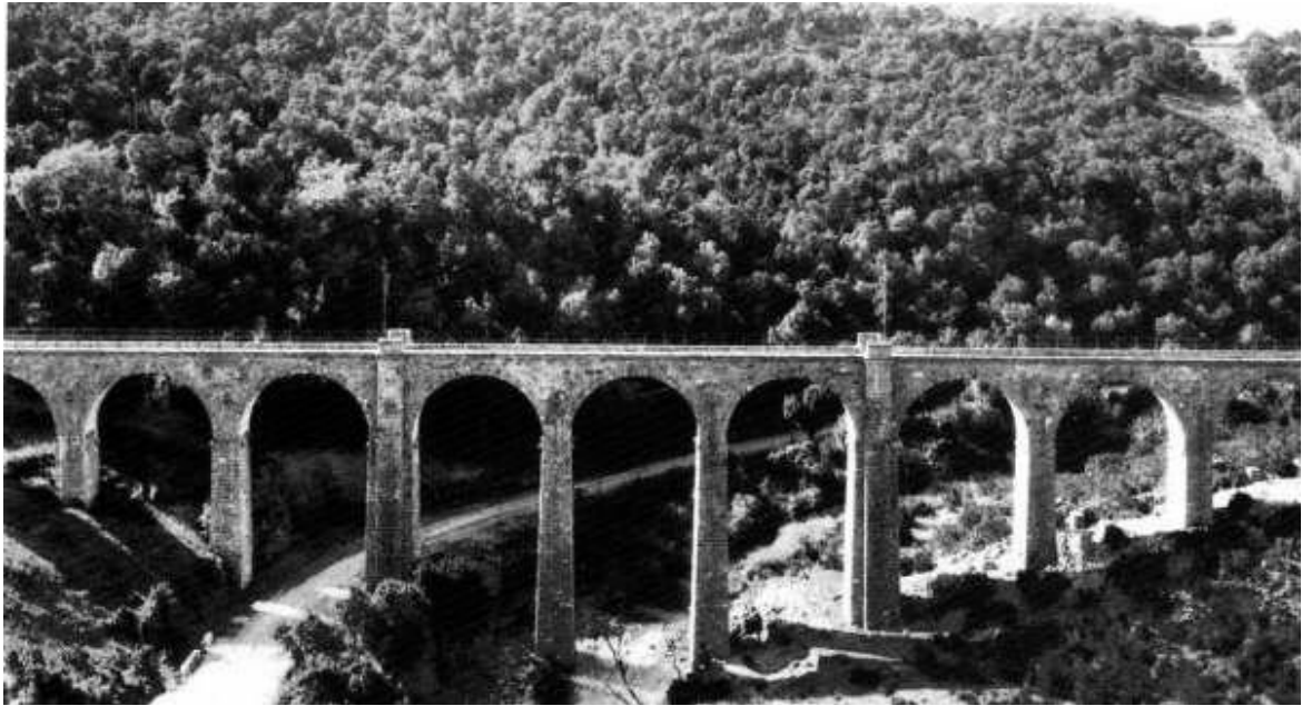
Viaducto de Arquijas
