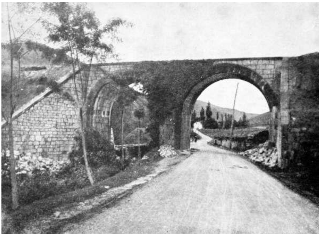
Eskorriaza.-Viaducto de Castañares. Eskorriaza
