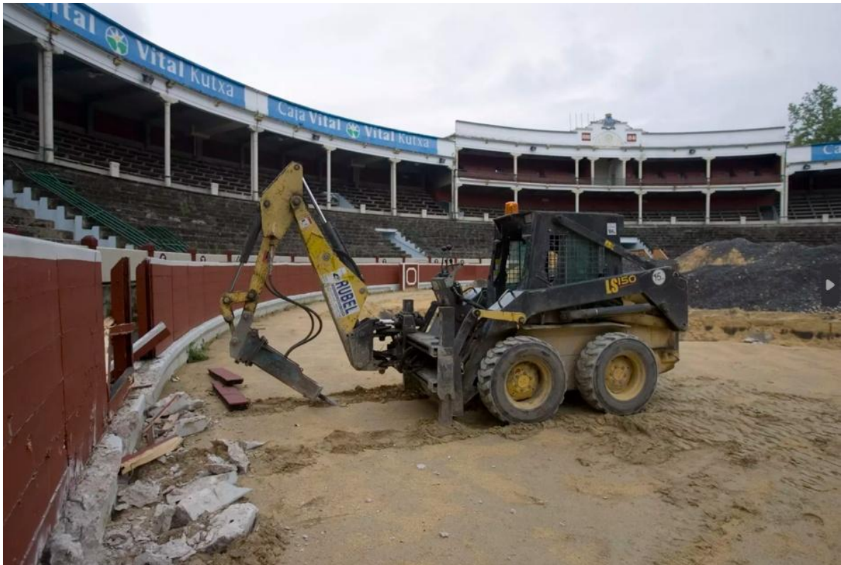
Inicio de la demolición de la vieja plaza de toros en mayo de 2007
