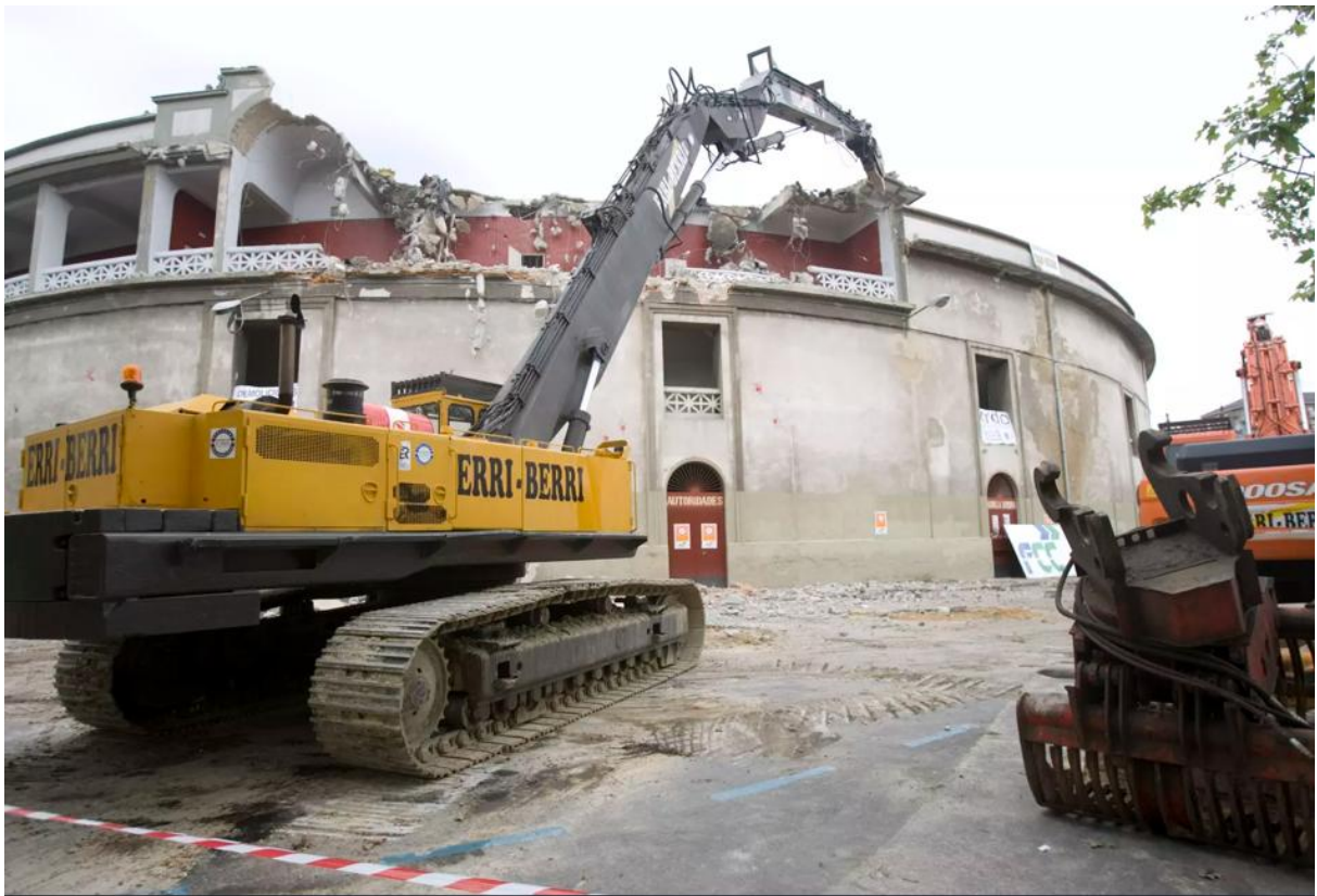
Derribo de la plaza de toros
