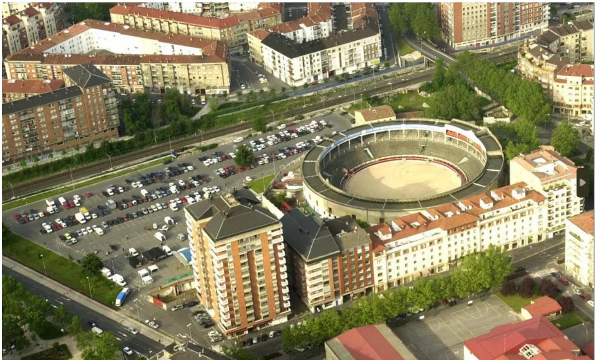
Vista aerea de la plaza de toros, del aparcamiento y de los alrededores del instituto Ekialde en 2002
