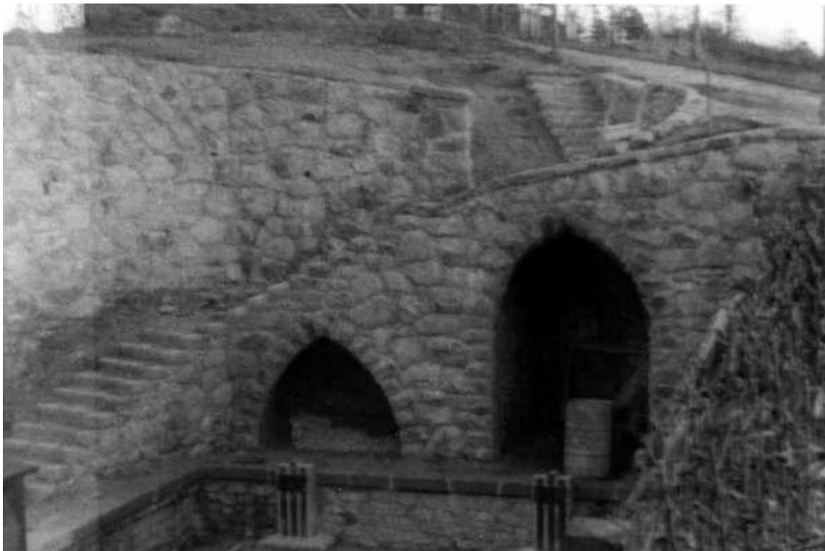
025. Construcción del ramal de Estibáliz-25. Foto Santuario de Estíbaliz
