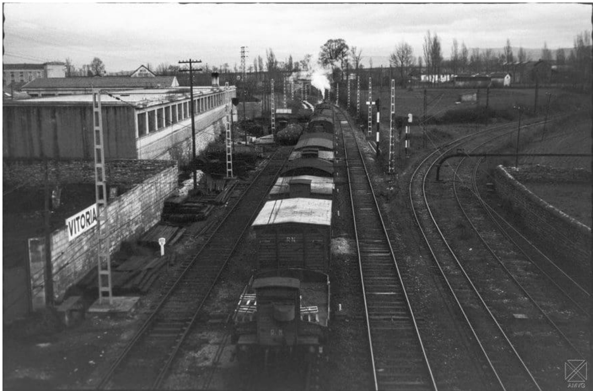
Aspecto de las vías de tren de la línea Madrid-Irún y a la izquierda el ramal de conexión del Vasco-Navarro en 1961. ARQUÉ. AMVG.
