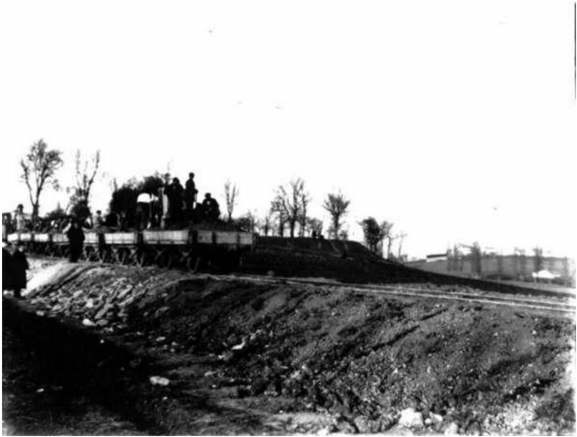
063. Construcción del ferrocarril. Foto E. Guinea. Archivo Municipal Vitoria-Gasteiz.
