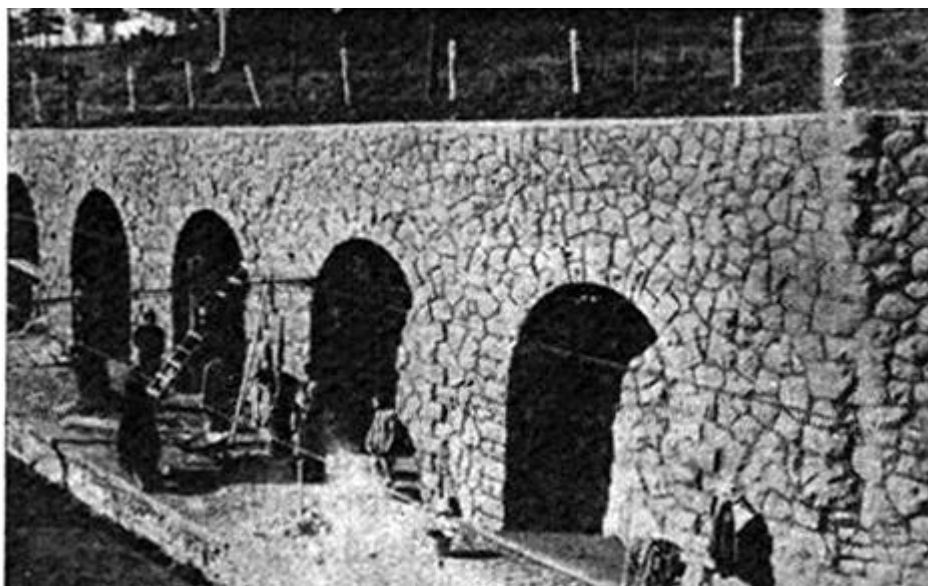
038- Ultimos toques a la estación de Estibaliz-1. Santuario de Estíbaliz.
