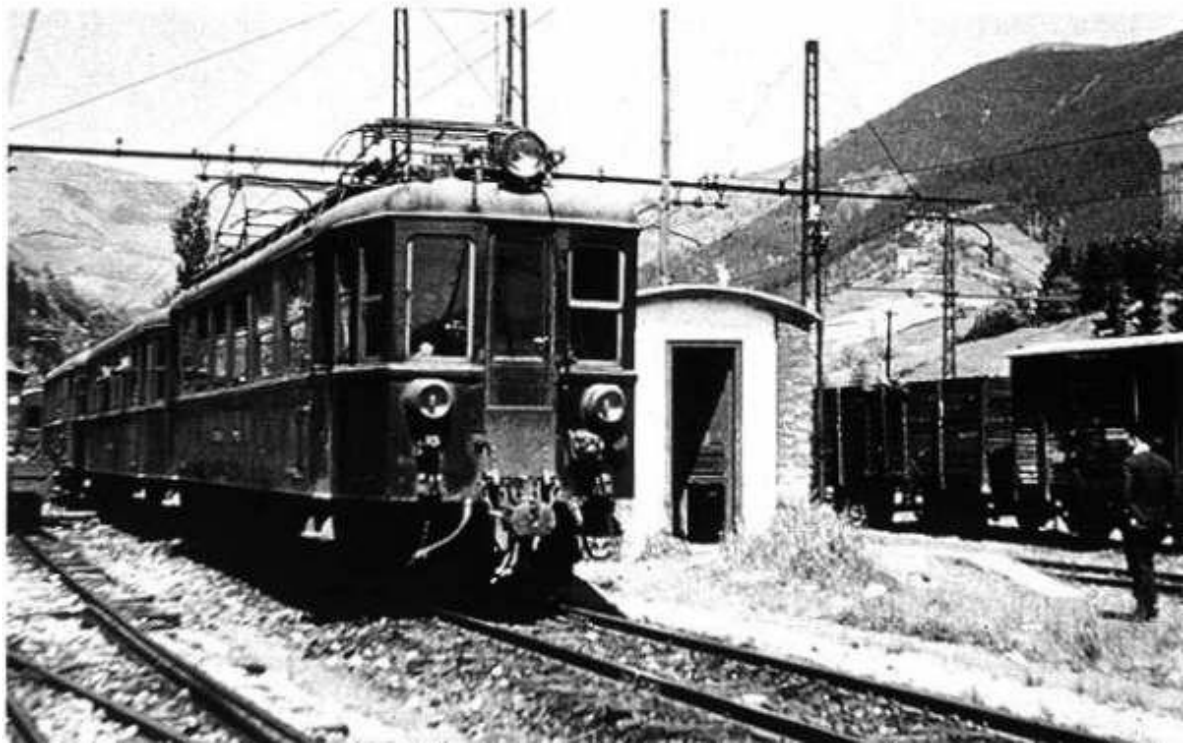
Estación de Mecolalde
