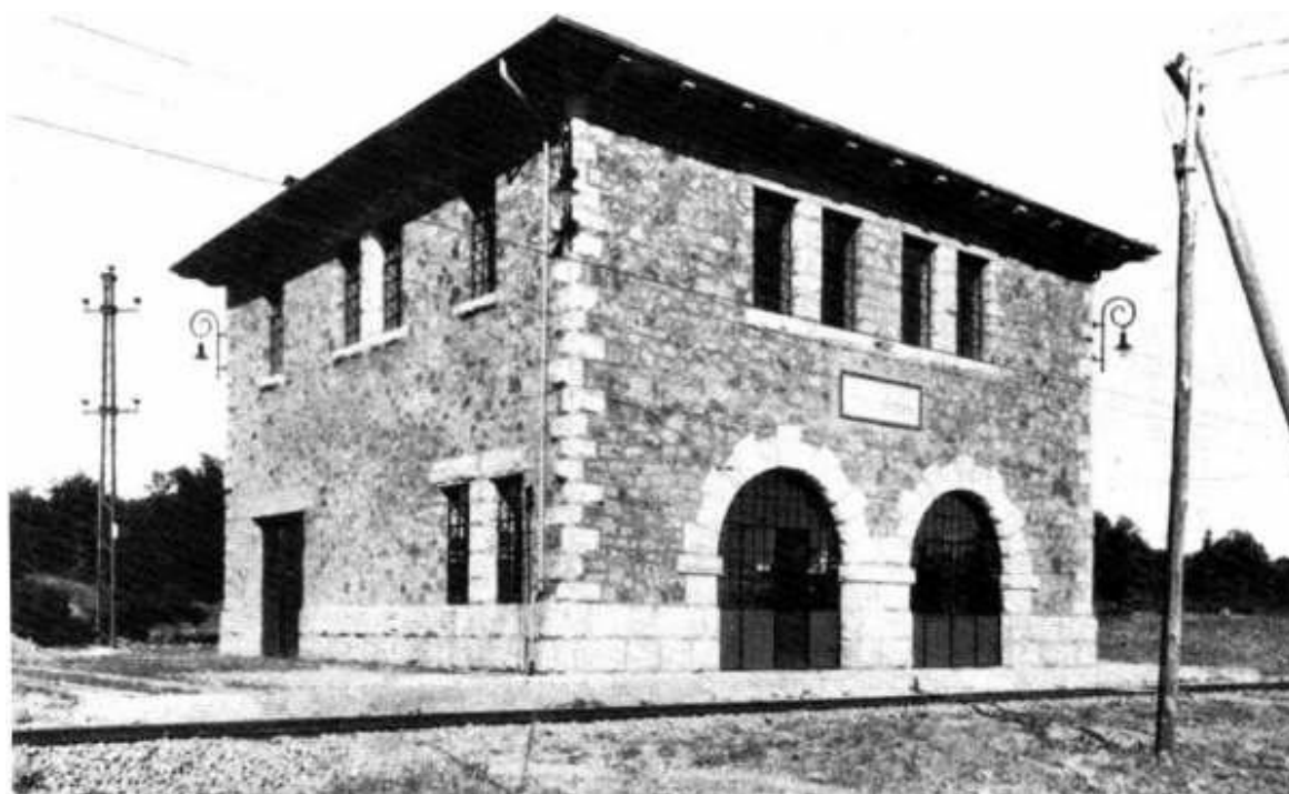
Subestación de Burba
