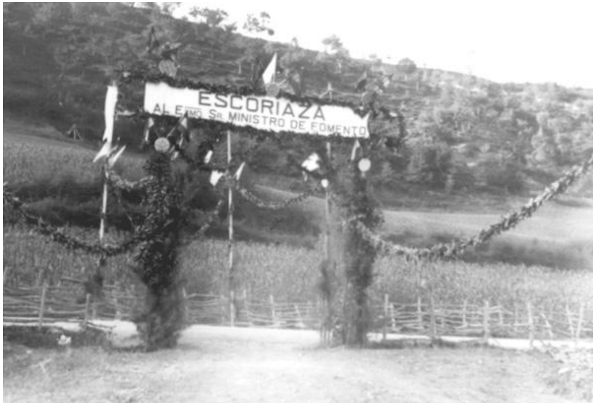
Recibimiento al Sr. Ministro de Fomento, llegando a la estación de Escoriaza.
