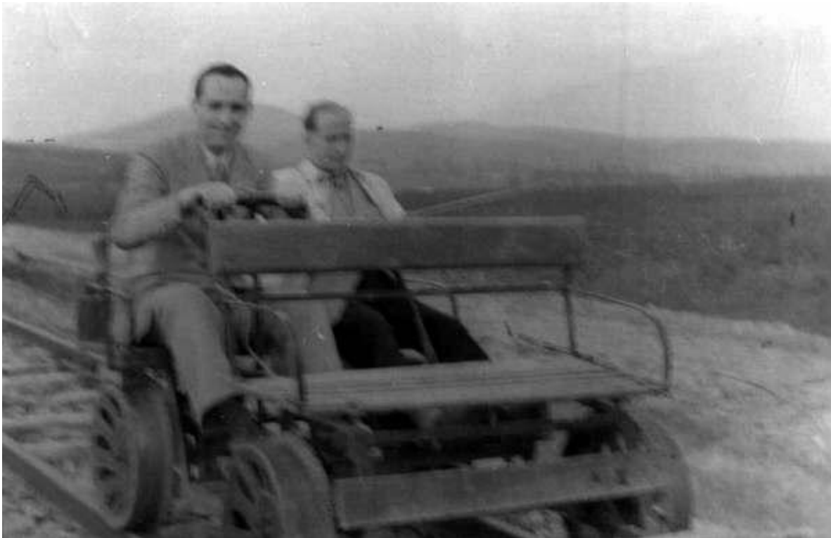
021. Construcción del ramal de Estibáliz-21. Foto Santuario de Estíbaliz
