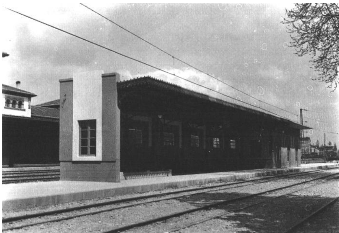
Estación del Vasco Navarro en la del Norte
