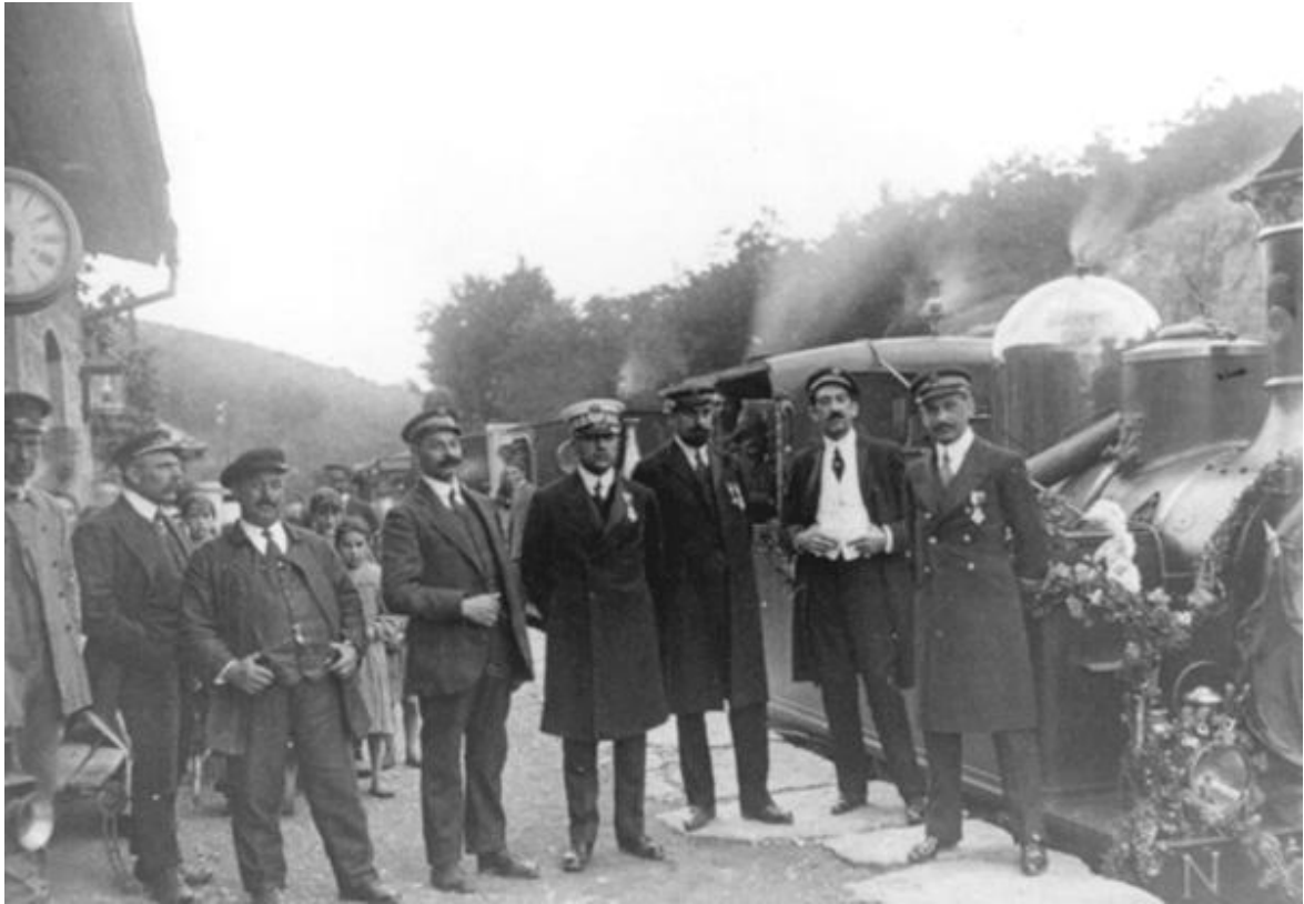
Grupo de facultativos de la línea, ingenieros, ayudantes y capataces, en la estación de Marín,
