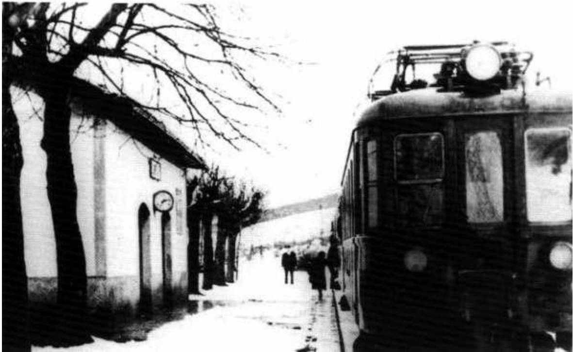
Estación de Urbina
