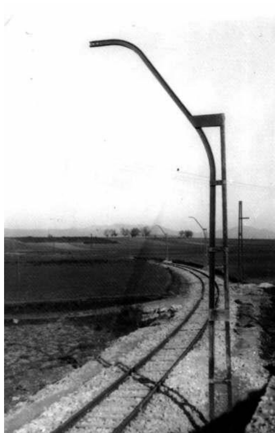
017. Construcción del ramal de Estibalíz-17. Foto Santuario de Estíbaliz
