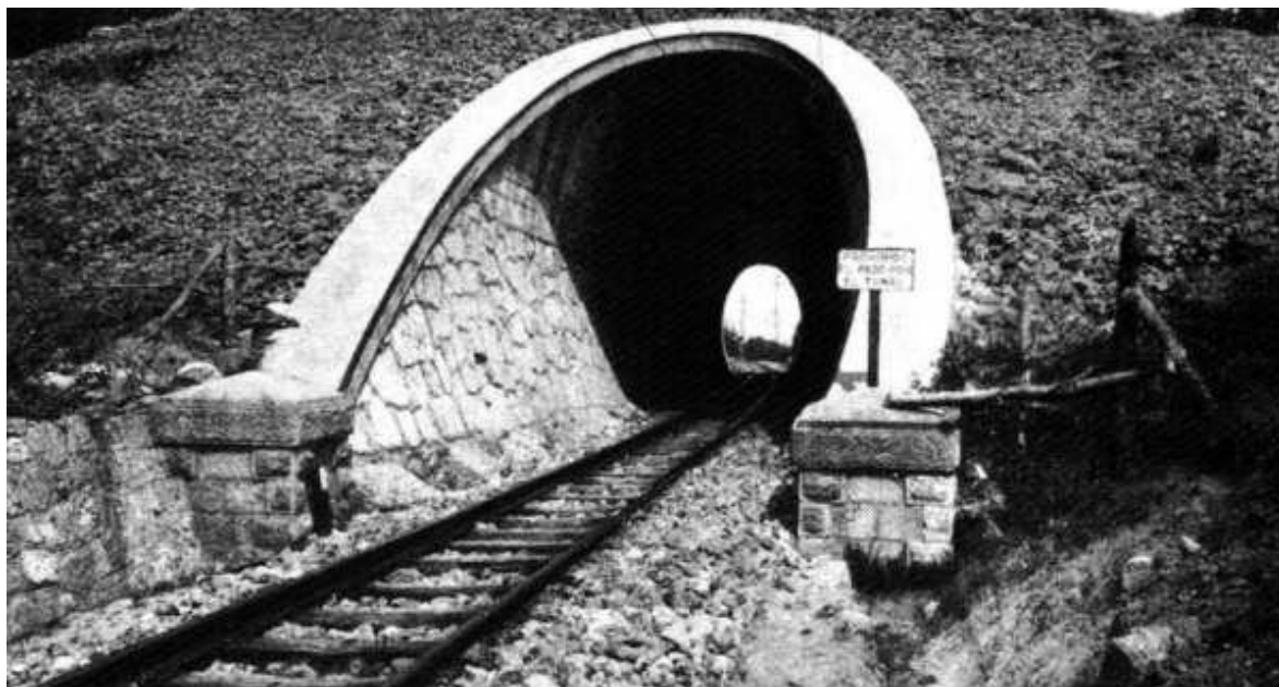
Túnel artificial de Huecomadura
