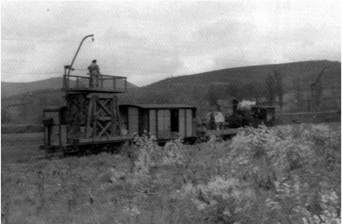
012. Construcción del ramal de Estibáliz-12. Foto Santuario de Estíbaliz
