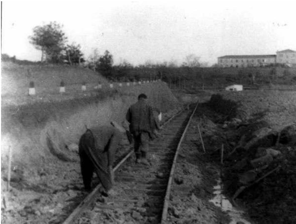
002. Construcción del ramal de Estibalíz-2. Foto Santuario de Estibalíz
