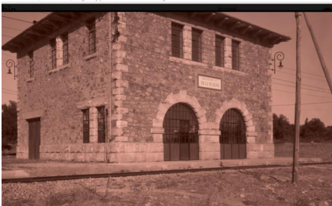
Edificio de la subestación de Burba en Ancin, Archivo Fundación Sancho el Sabio Fundazioa
