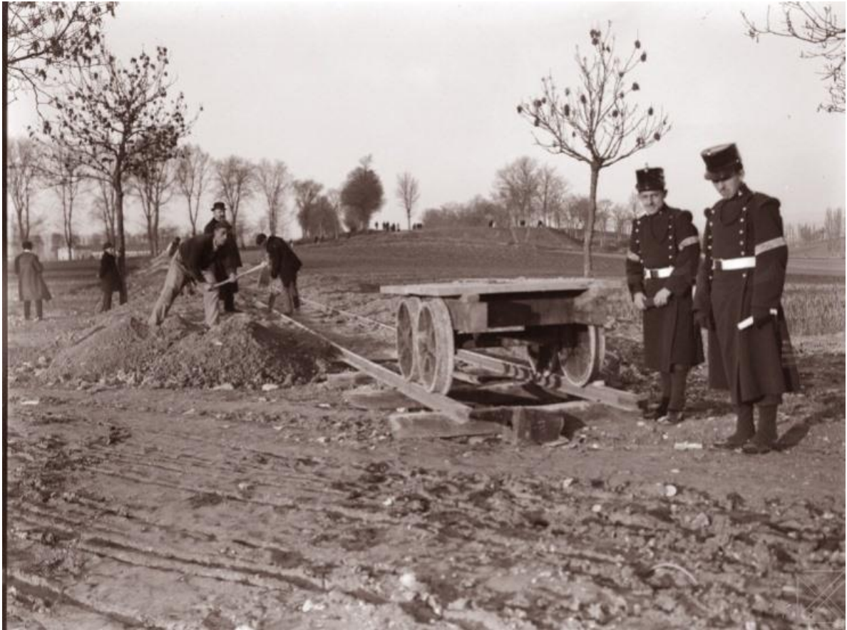
Proximidades de Judizmendi. ( se ve al fondo) Construcción del ferrocarril Vasco-Navarro.1914
