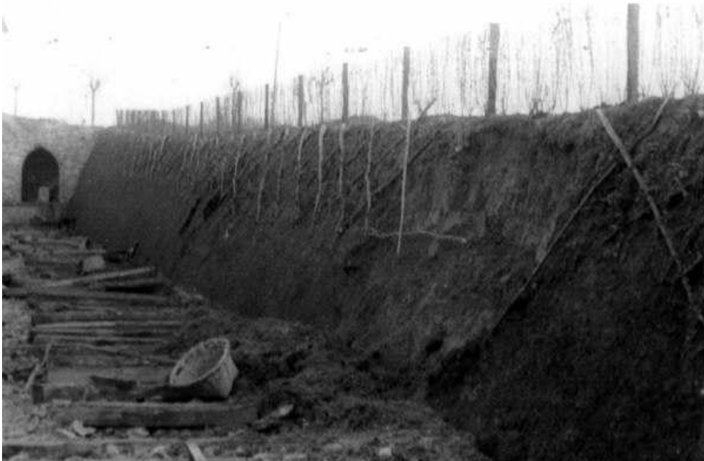
01- Construcción del ramal de Estibaliz.1. Foto Santuario de Estibaliz
