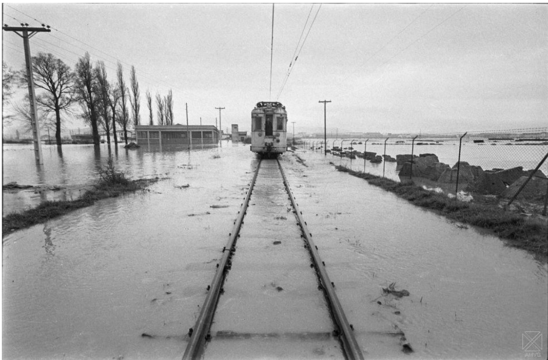
Vía del ferrocarril inundada.-1960
