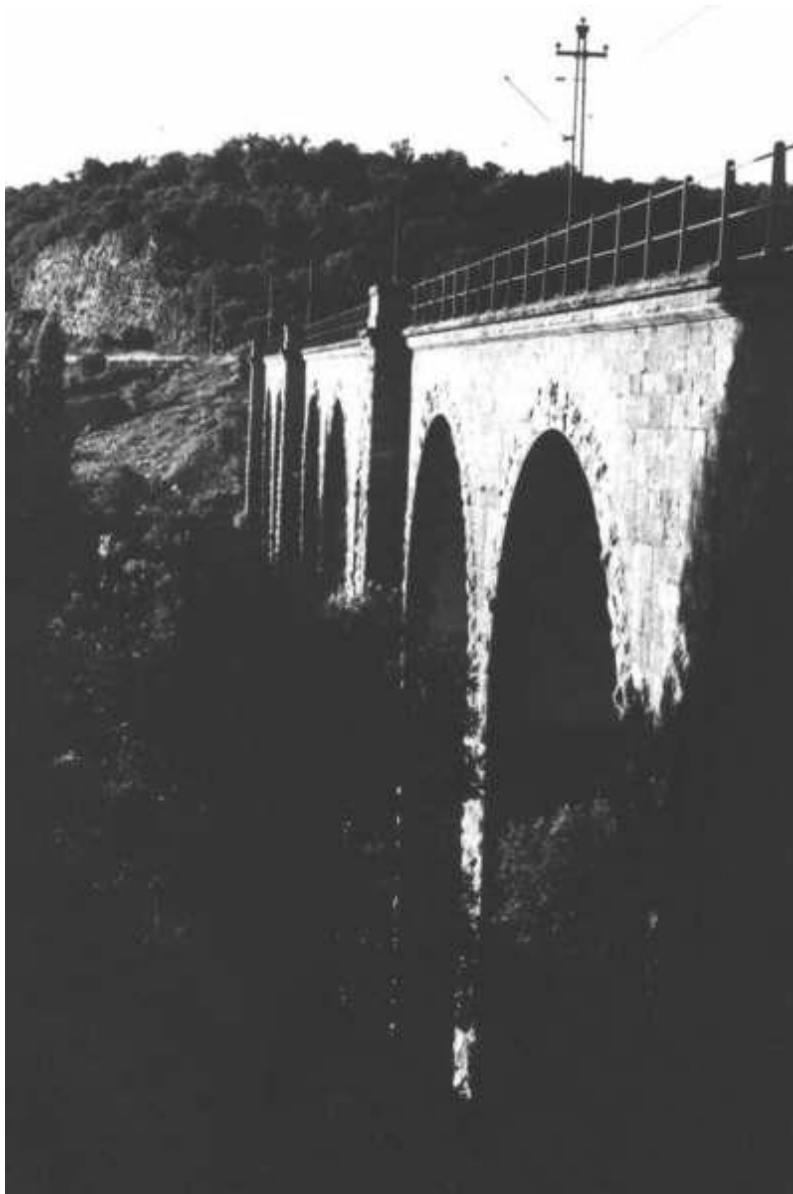
061. Viaducto de Arquijas. Foto. A. Lz. de Guereñu. Archivo Provincial de Álava
