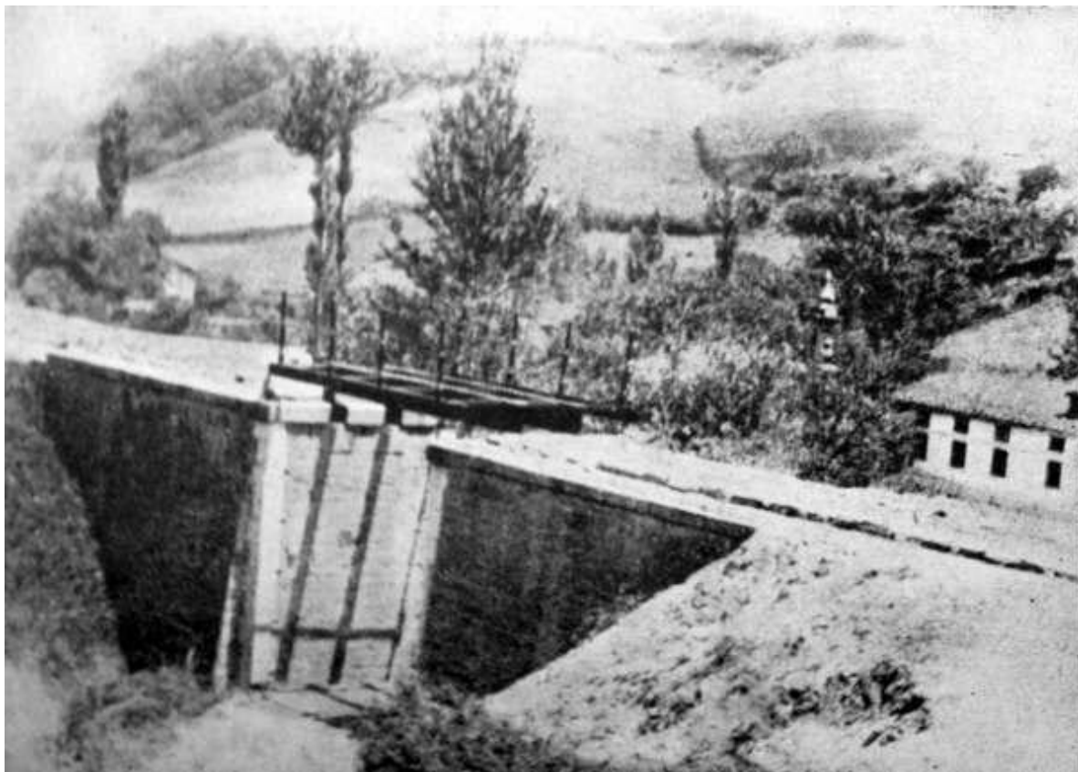
Construcción de la línea Vitoria-Los Martires. Sin documentar
