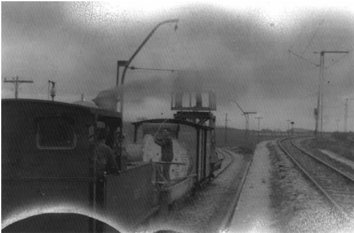
009. Construcción del ramal de Estibaliz-9. Foto Santuario de Estibaliz
