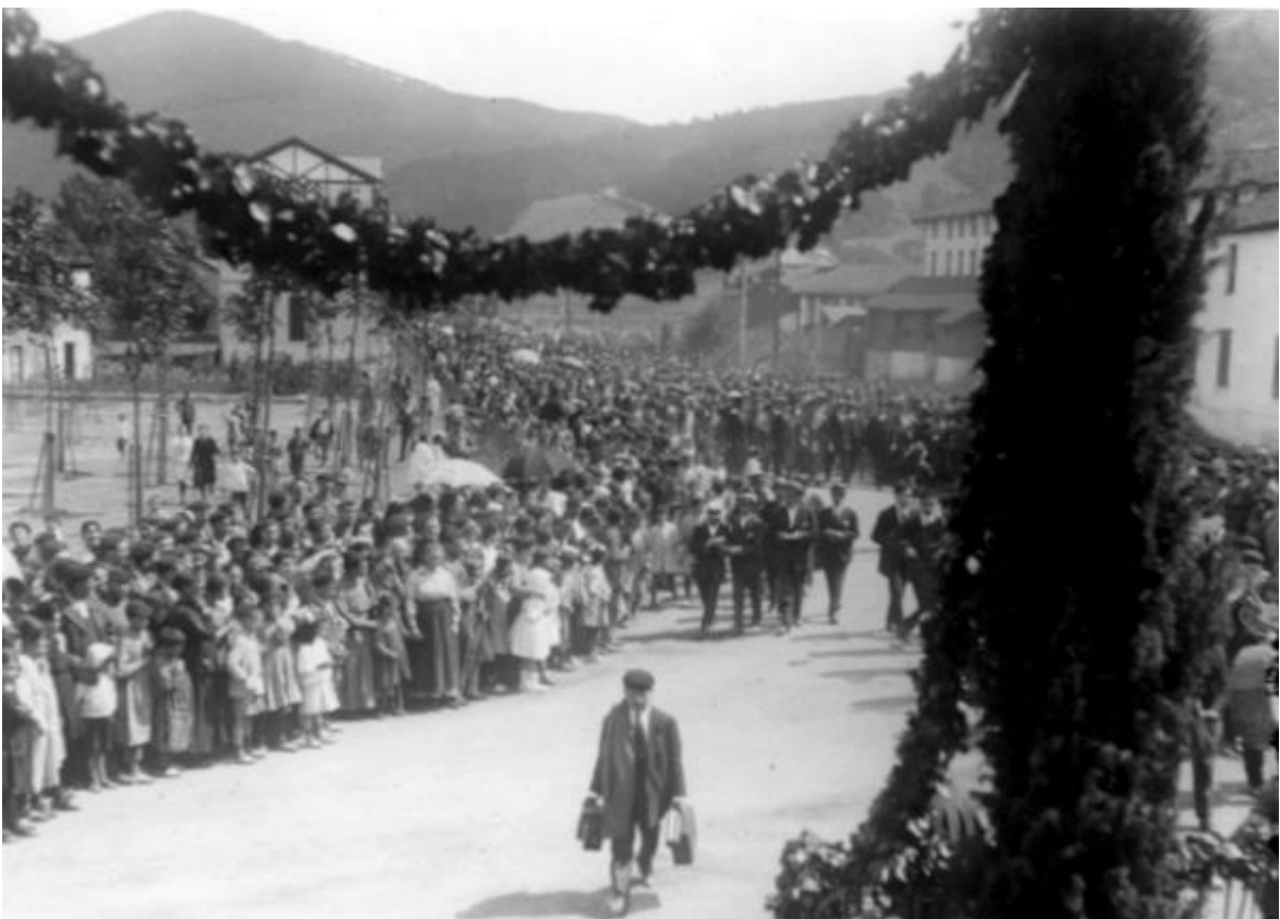
En este evento participó el general Miguel Primo de Rivera. la inauguración del tramo que unía finalmente Vitoria con Estella.
