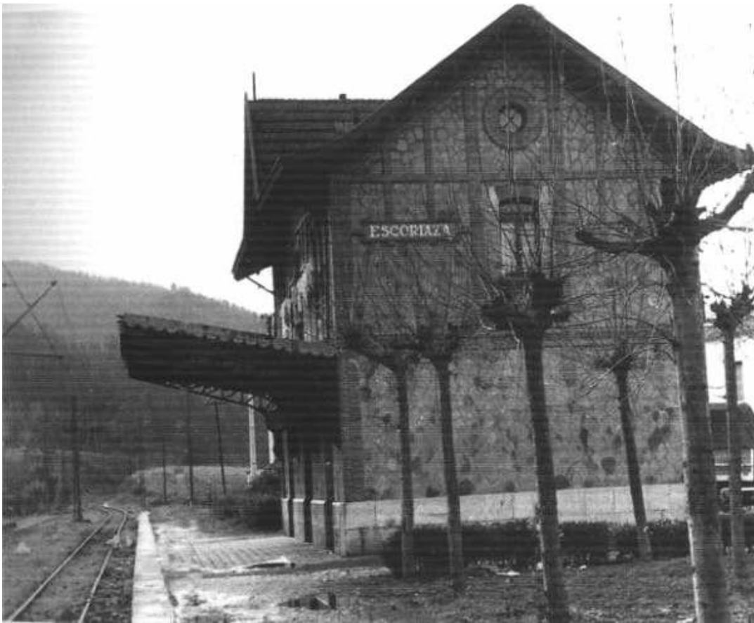
Estación de Escoriaza
