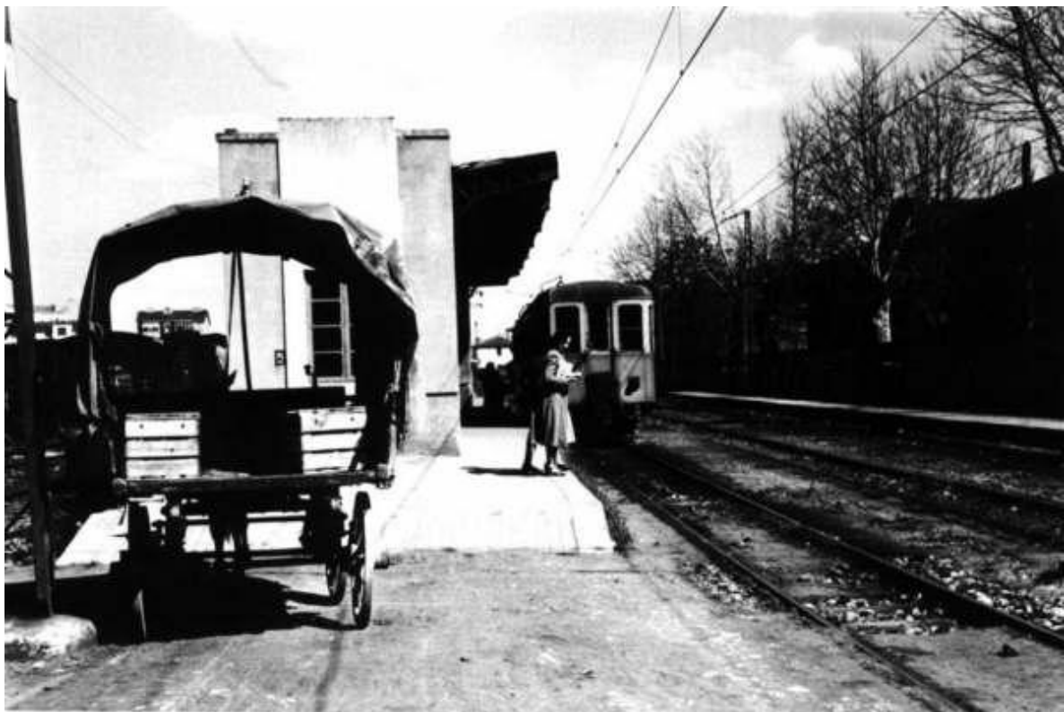
059. Estación de Vitoria-Norte. Foto. A. Lz. de Guereñu. Archivo Provincial de Álava
