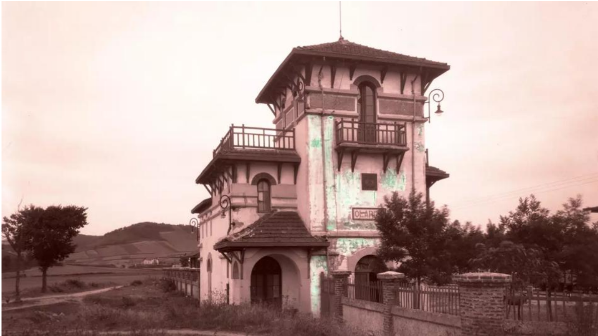
Edificio de la antigua estación de ferrocarril de Olarizu, en Vitoria FUNDACIÓN SANCHO EL SABIO
