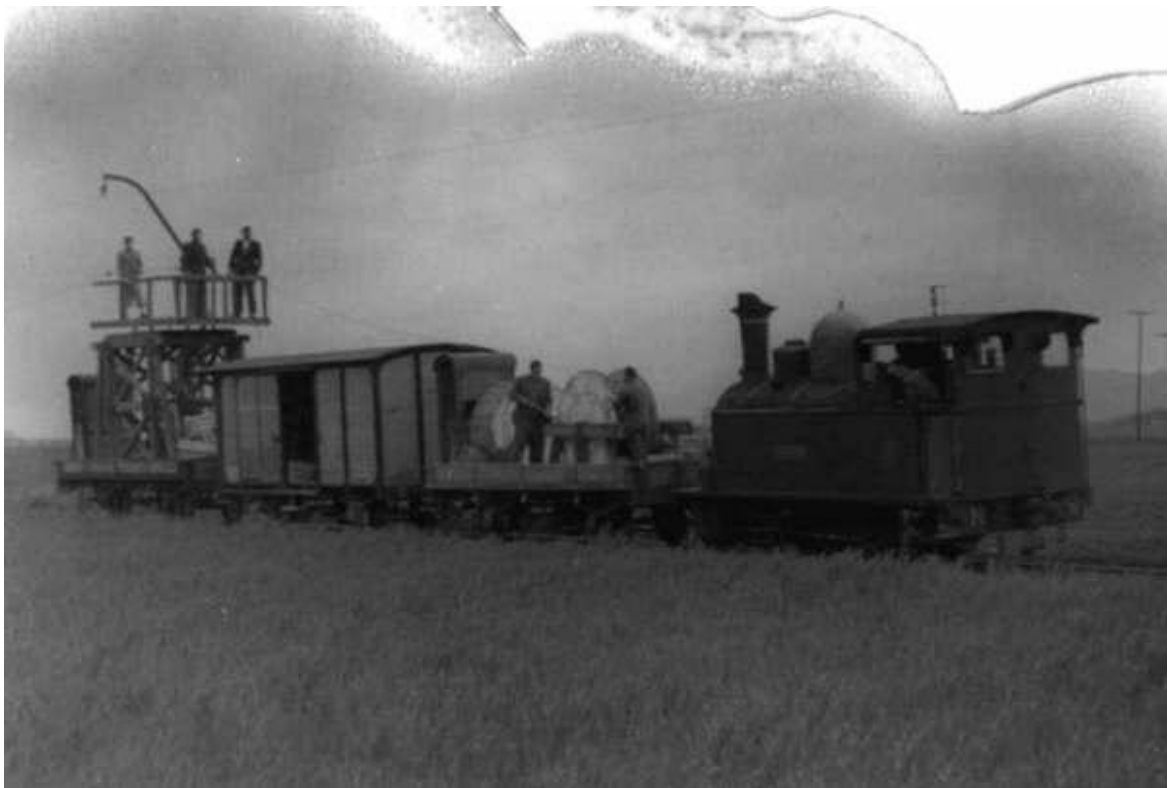
011. Construcción del ramal de Estibáliz-11. Foto Santuario de Estíbaliz
