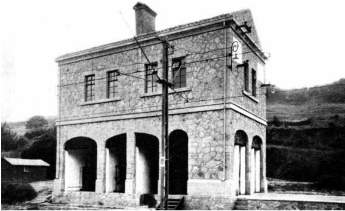
Subestación de Antoñana
