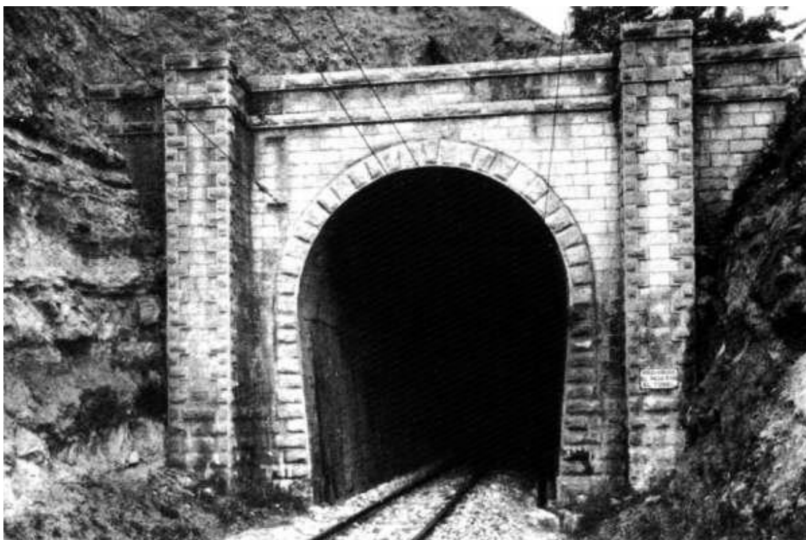
Túnel de Laminoria
