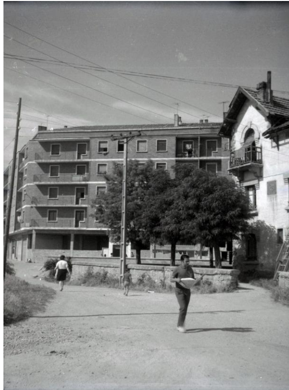
Antiguo edificio del ferrocarril Vasco-Navarro a la derecha de la fotografía en la confluencia entre las calles Las Trianas y Raimundo Olabide en Adurza. Fondo Fundación Sancho el Sabio.
