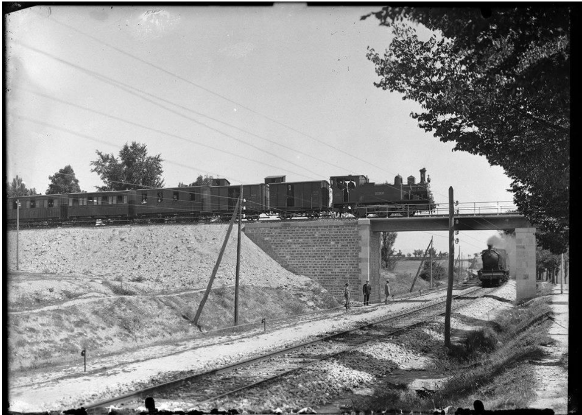
Paso elevado del vasco navarro y el tren del norte
