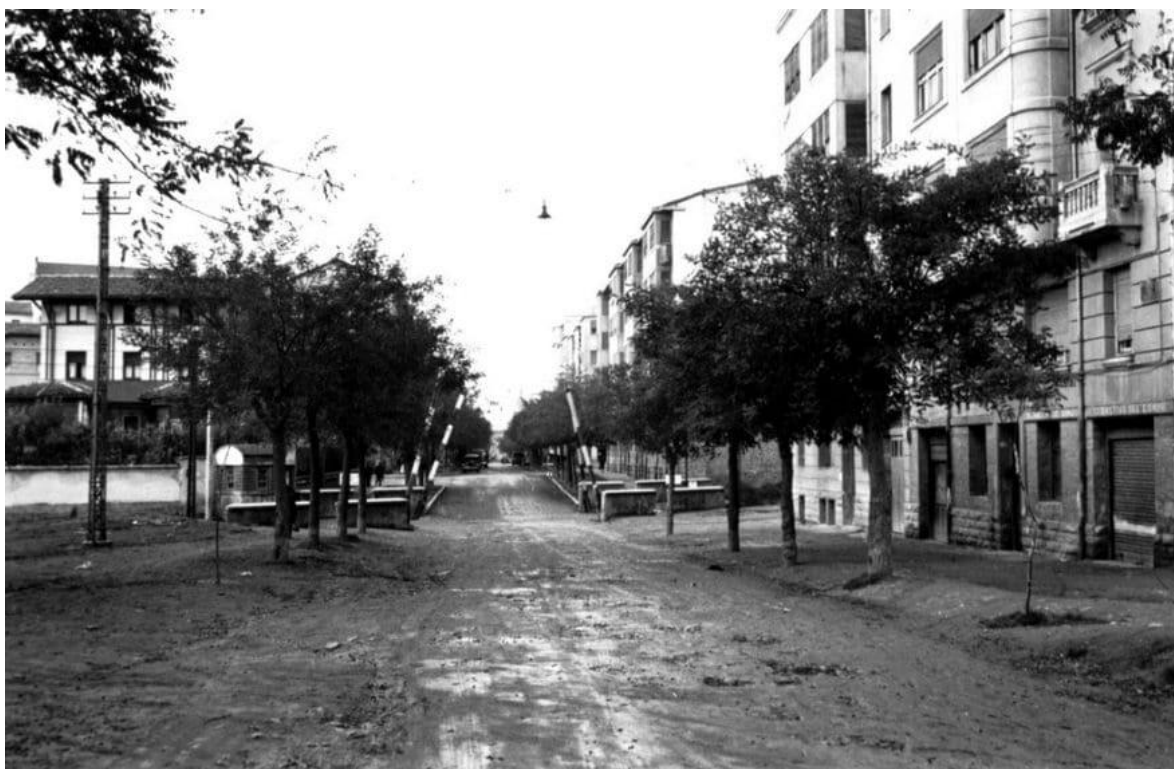
Calle Olaguibel en 1959 (con El Paso a nivel). Foto del Archivo de Álava
