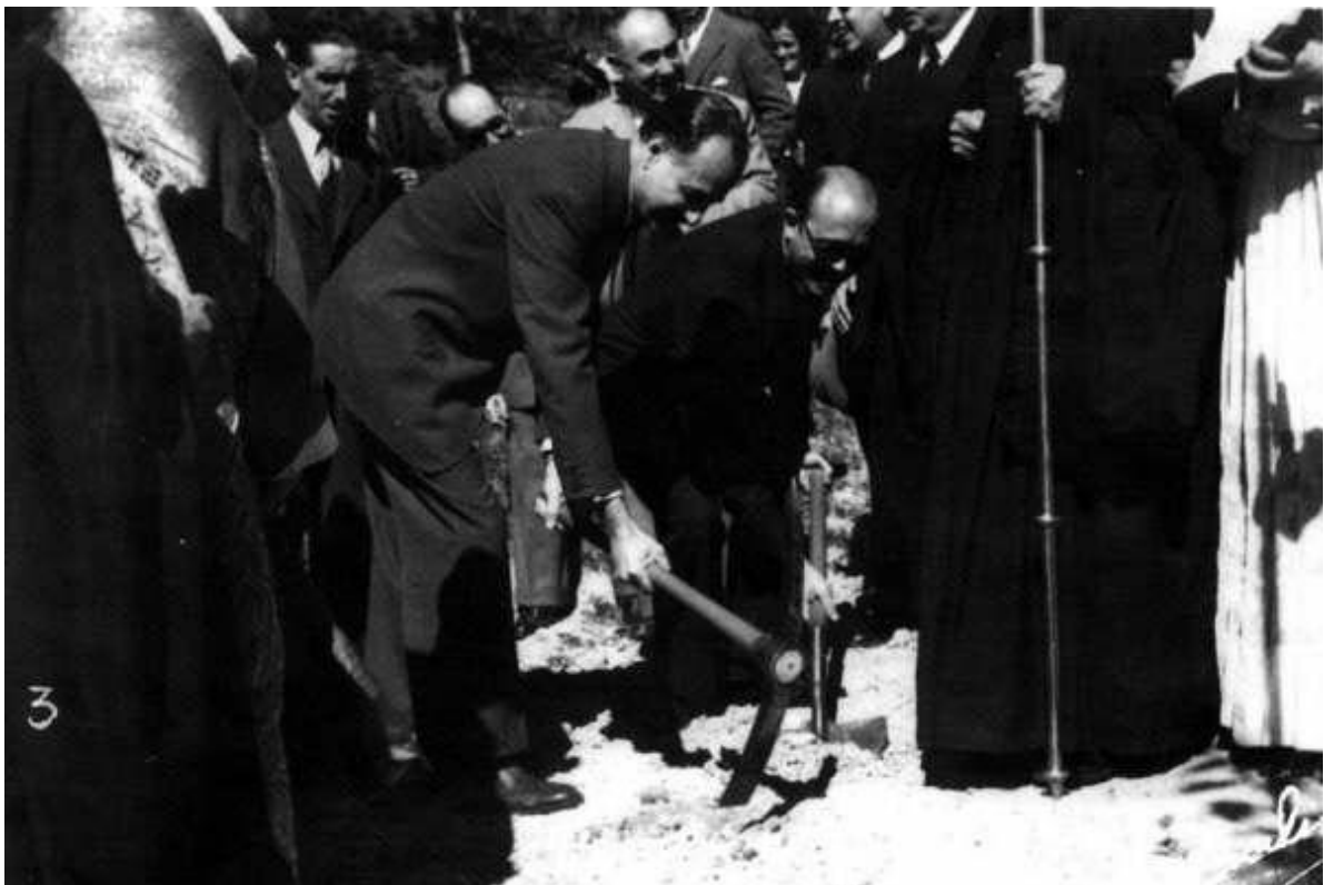
027. Construcción del ramal de Estibáliz-27. Foto Santuario de Estíbaliz
