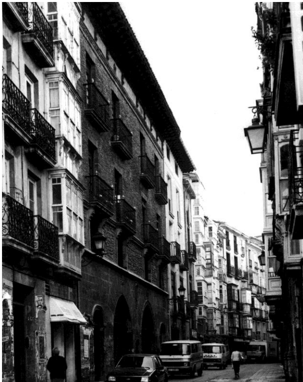
Fachada de la casa del Cordón restaurada
