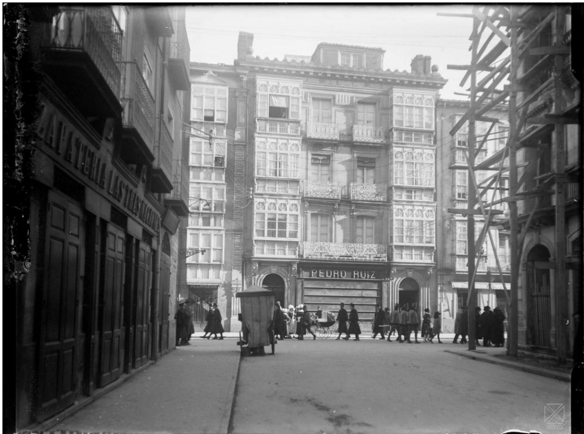
Hacia 1923. Vista de la calle Eduardo Dato desde la calle General Álava.
