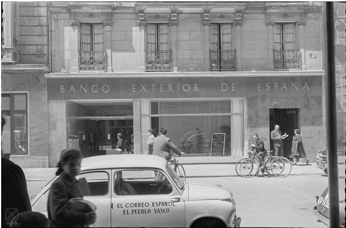
Calle Dato.-13-5-1959-banco exterior de España
