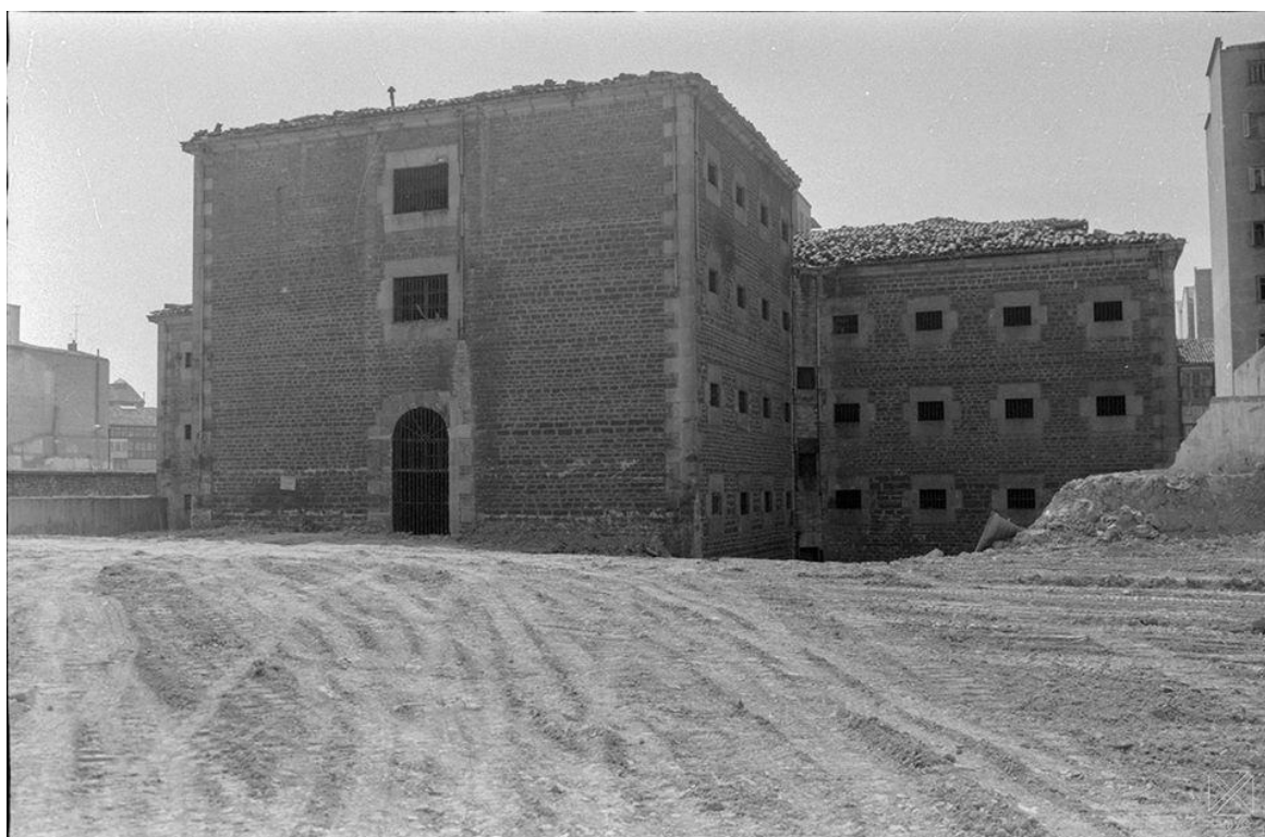
Calle La Paz. Demolición de la cárcel .1974
