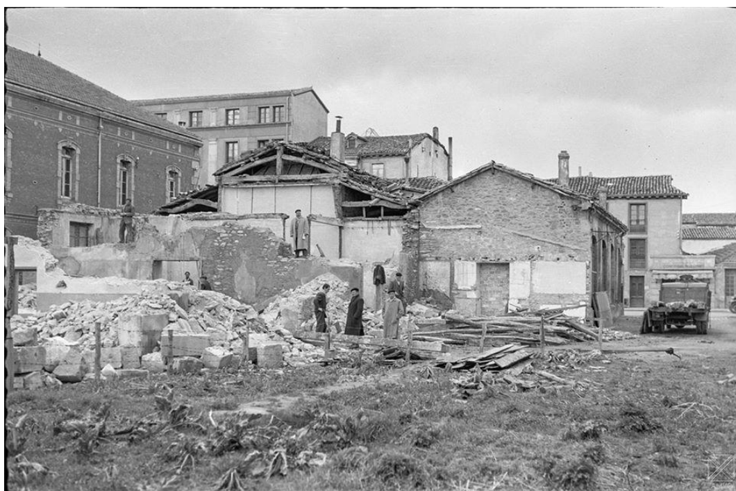
Calle de La Paz.-Demolición .23-3-1956
