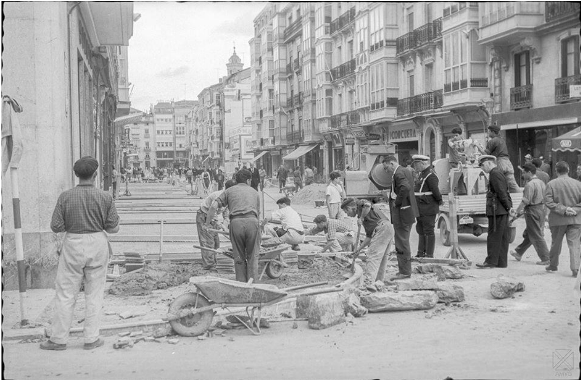
Calle Dato.-10-7-1963-pavimentando las aceras
