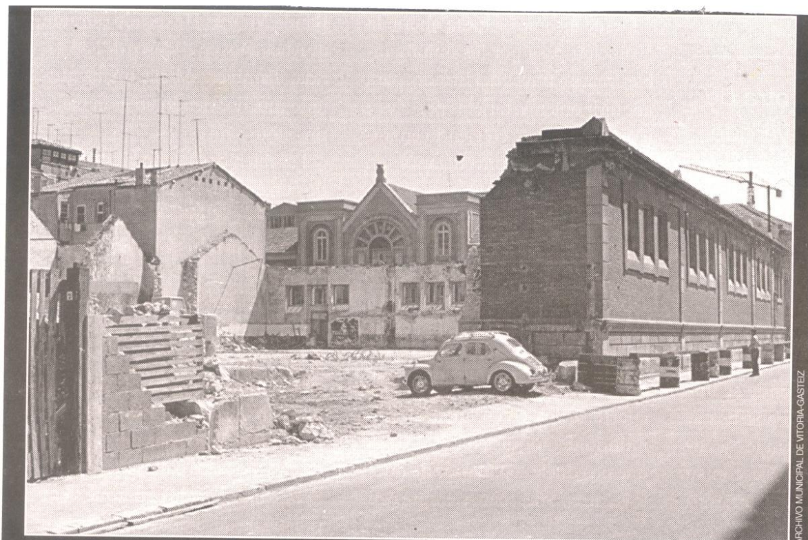
Calle la paz.-Demolición de la cárcel
