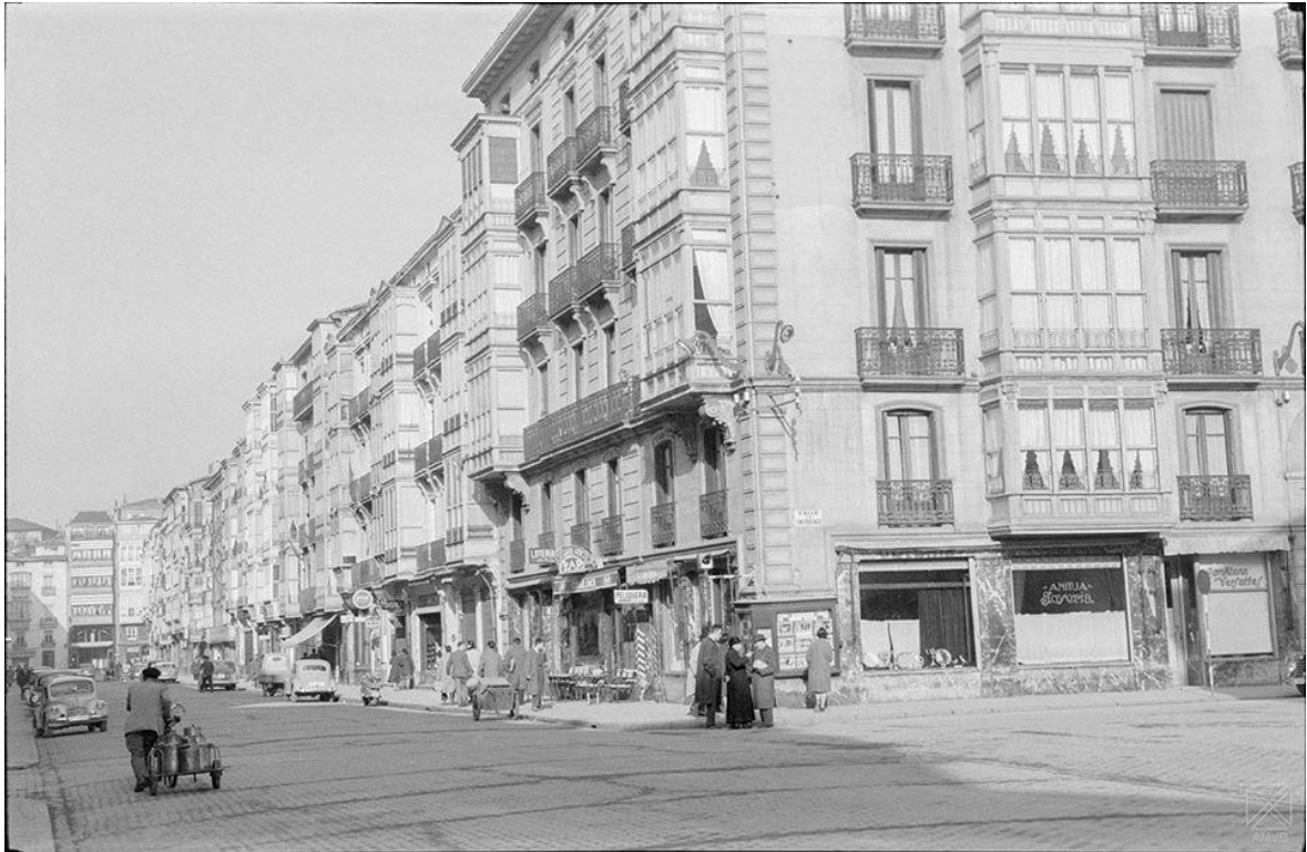
Calle Dato.1958-confluencia con calle san Prudencio
