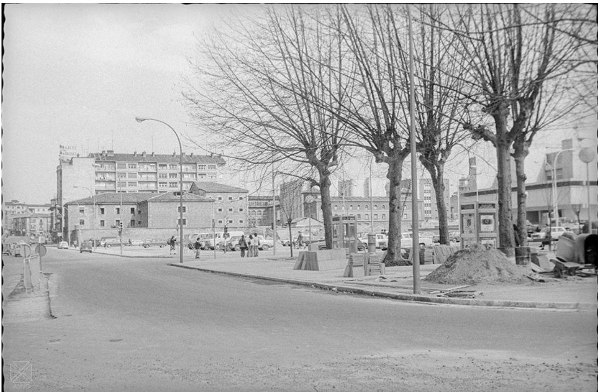
Calle La Paz.-1974-solar de Galerías Preciados.
