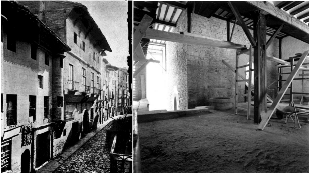
Calle cuchillería. Casa del Cordón en obras-1956-62.
