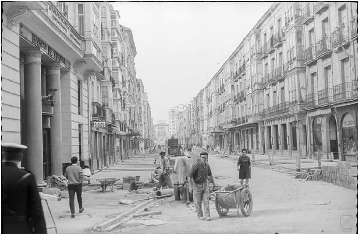
Calle Dato.-9-7-1963-pavimentando las aceras
