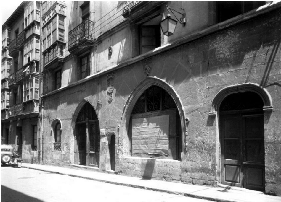
Calle cuchillería. Casa del Cordón en obras-1956-62
