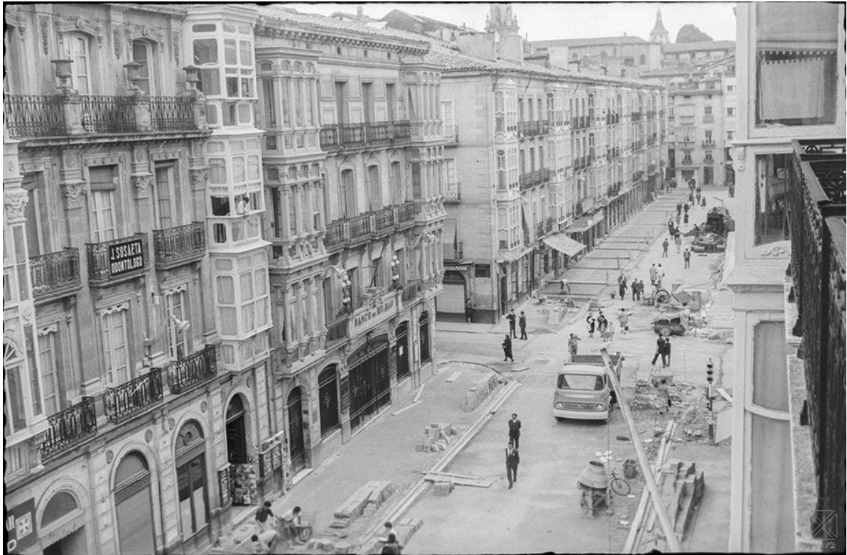
Calle Dato, con otra perspectiva del antiguo edificio del Banco de Bilbao, que compartí ayer. Santiago Arina. (9 de julio de 1963)
