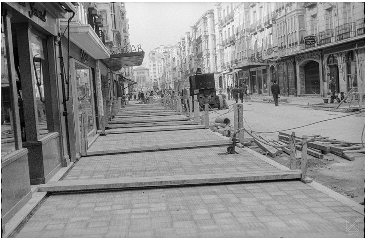
Calle Dato.-9-7-1963-nuevas aceras
