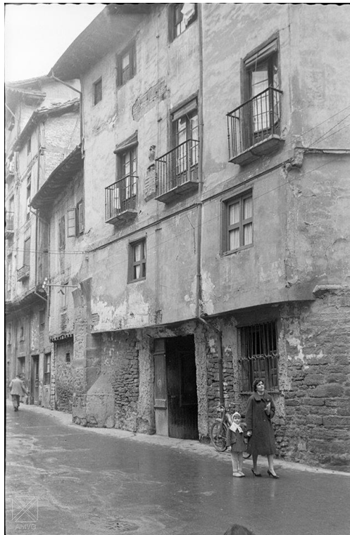
Calle Herrería.-27-3-1959-hacia fuente los patos
