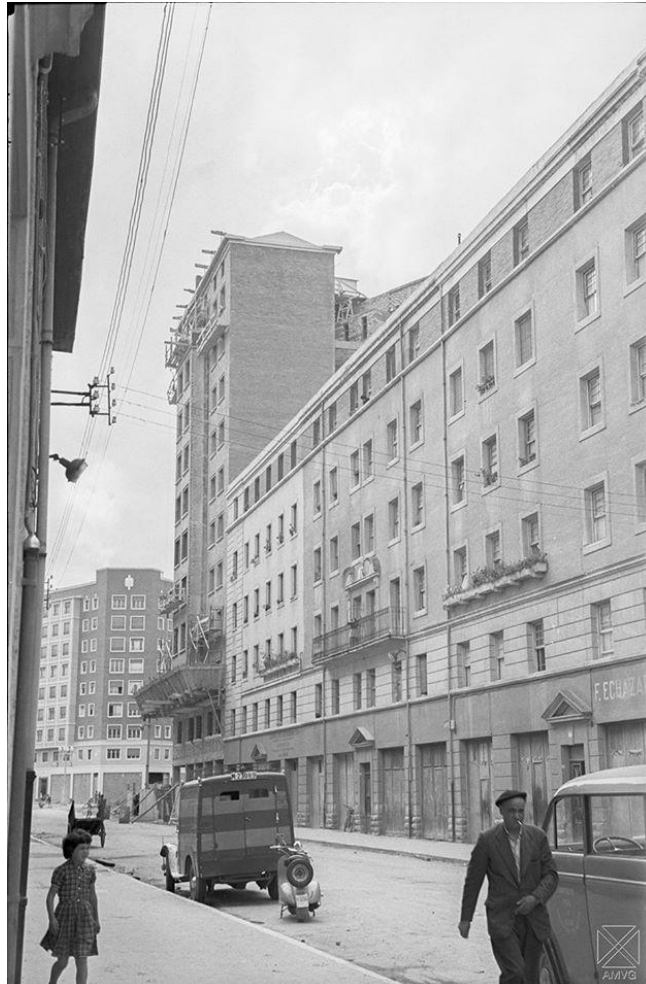
Calle Gorbea.-septiembre 1959-talleres Echazarreta
