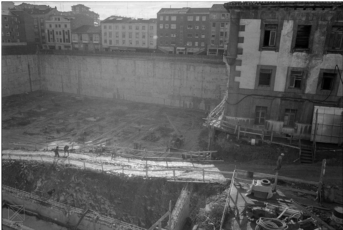
Calle Francia-obras de excavación del parking subterráneo del futuro museo Artium.9-2-1995
