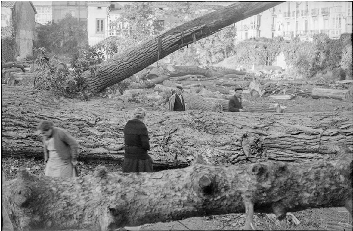
Calle Florida Manuel Iradier.-derribo de árboles en el jardín de la casa de América.-octubre 1958
