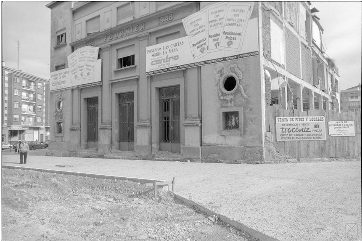
Calle Heraclio Fournier. Derribo de la fábrica de Fournier.-27-1-1995
