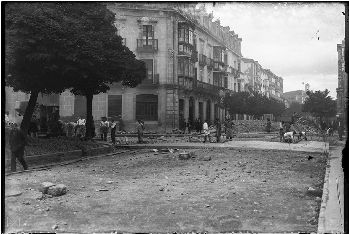
Calle Independencia.1927- gran asfaltado
