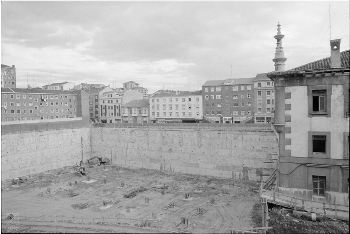
Calle Francia.-construcción del aparcamiento del museo Artium.-9-2-1995
