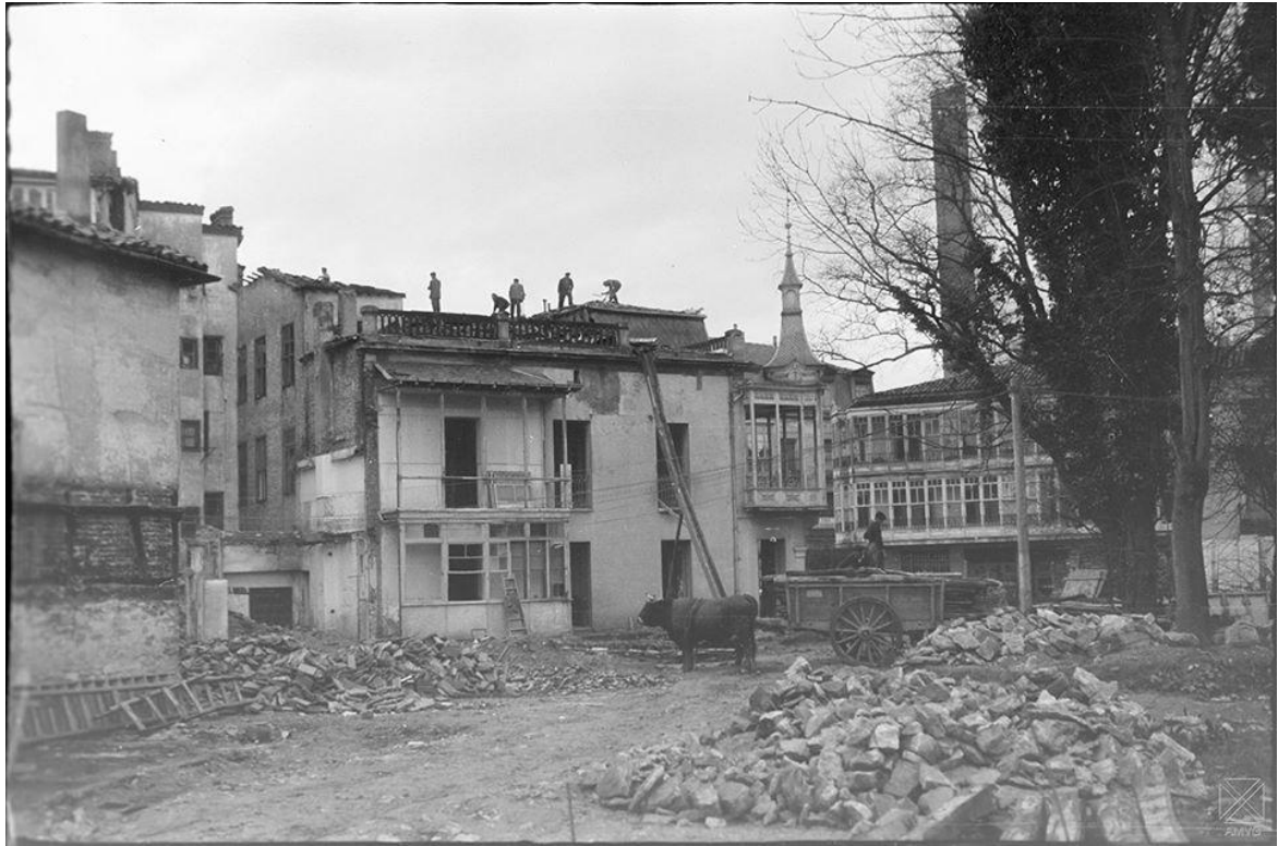
Calle General Alava -derribo de la casa de Pedro Ortiz.-8-1-1959
