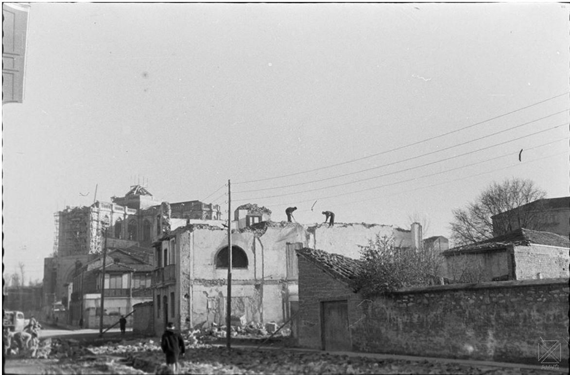
Calle Madre Vedruna.-1960-obras
