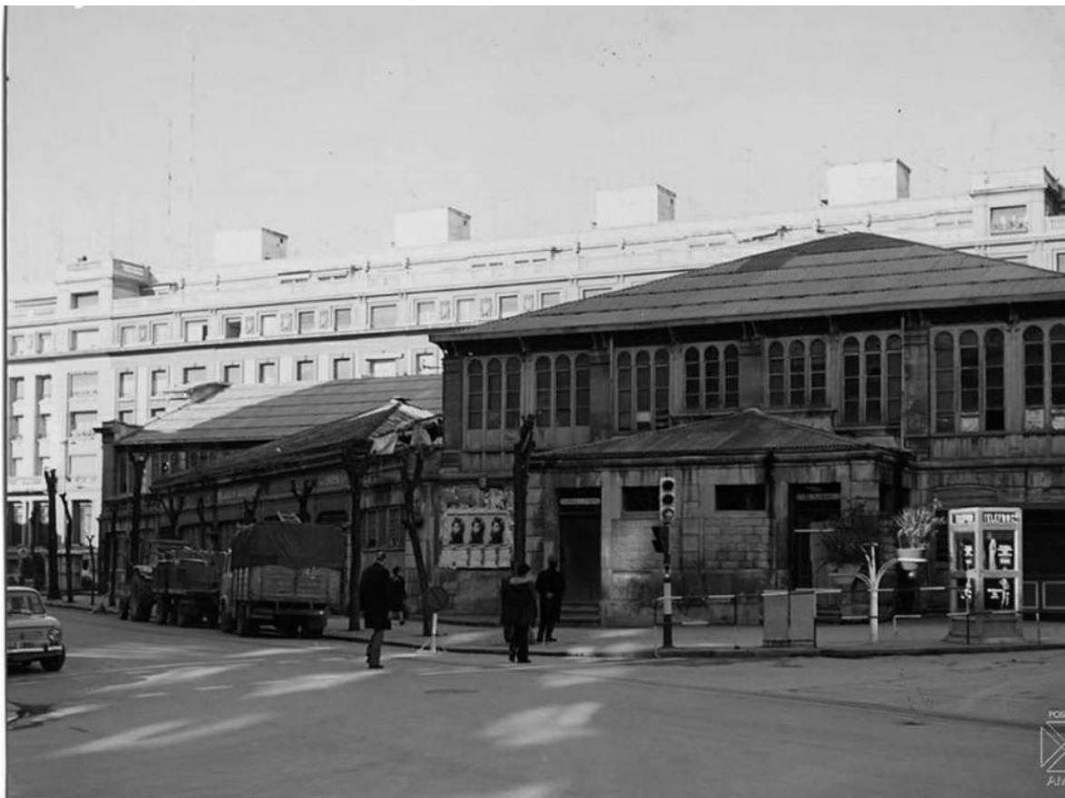
Calle fueros-postas-Plaza de Abastos-2 ARQUÉ.(1975)
