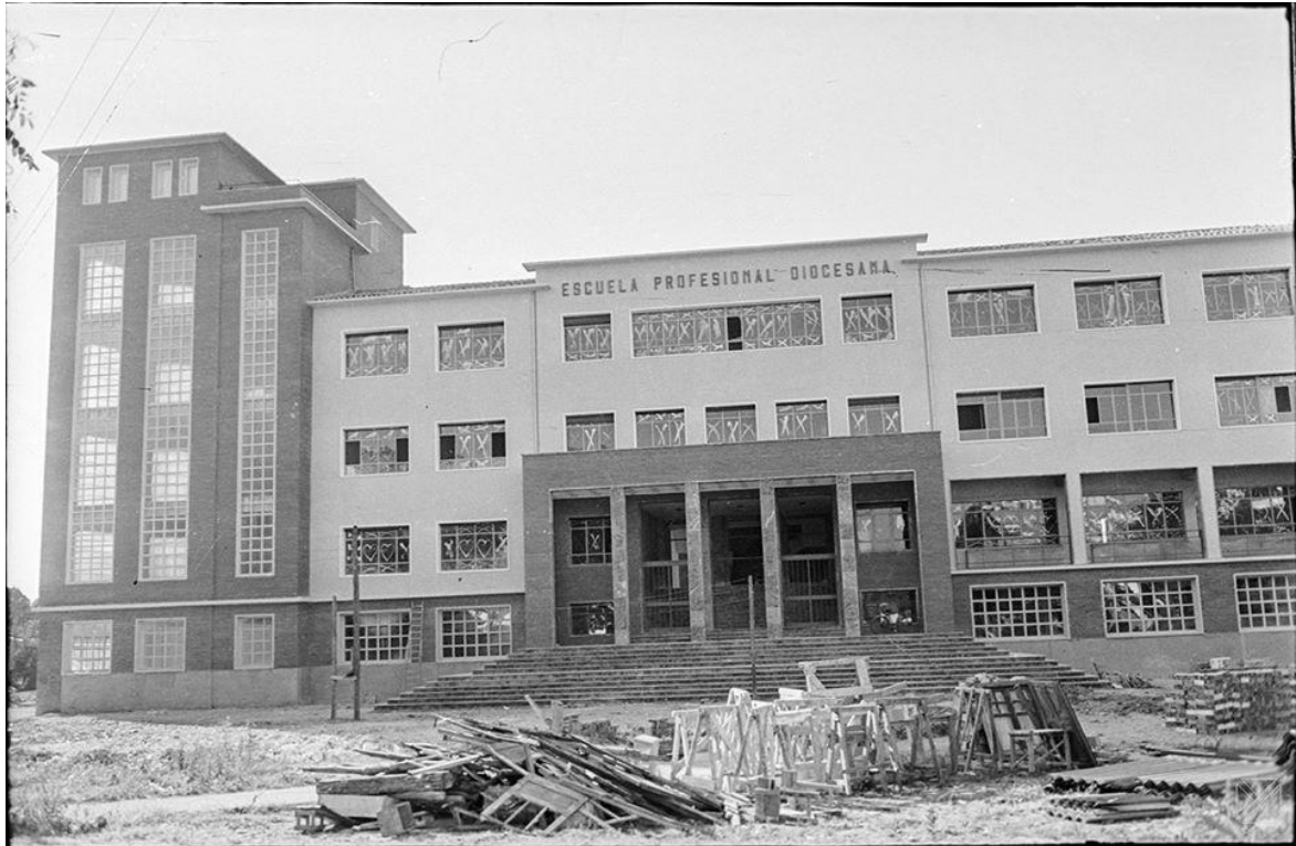
Calle Nieves Cano, edificio de las Escuelas Diocesanas En construcción.-16-2-1962
