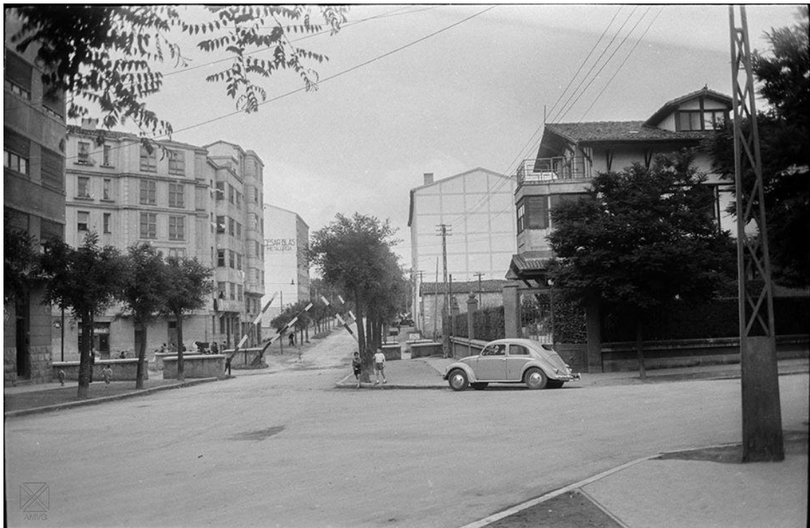
Calle Olaguibel con Avenida de Estibaliz paso a nivel registrada año 1958 (foto arque)
