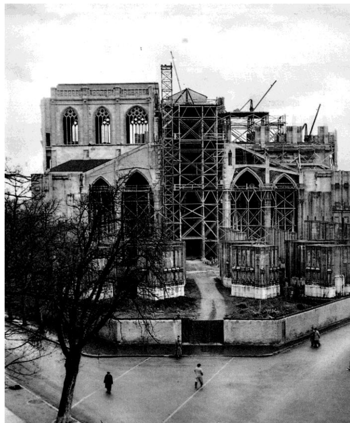
Calle la magdalena.-Estado de las obras de La catedral nueva en 1963
