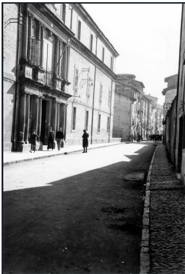
Calle Nueva Dentro. Calle de la Judería
