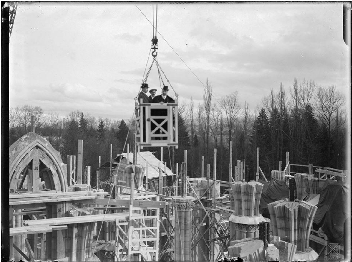
Calle magdalena.-obras de la catedral de María Inmaculada.-1912
