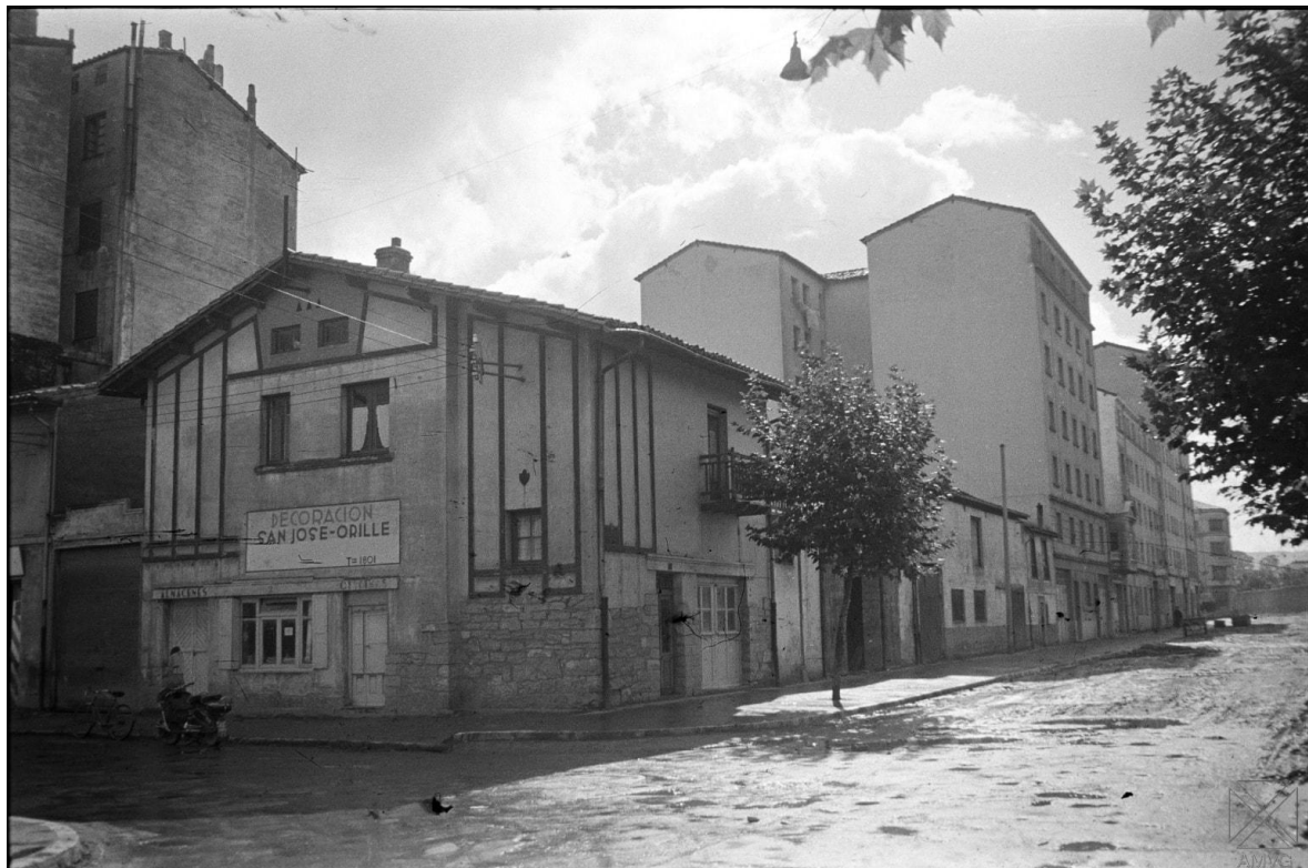
Del barrio de Santiago a parte de la calle Los Herrán.-1960
