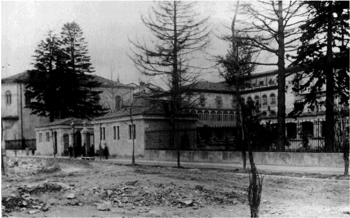
Calle Olaguibel.-Hospital General de Santiago
