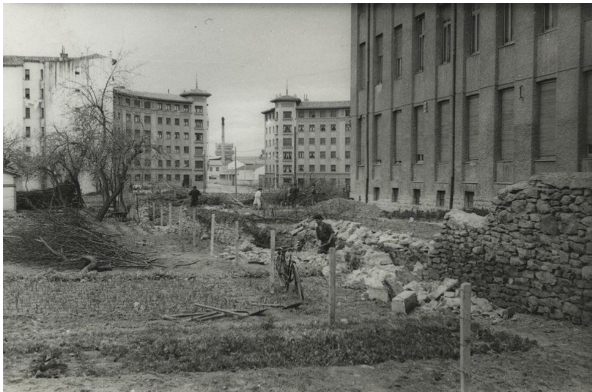
Calle Landázuri sin pisos.
