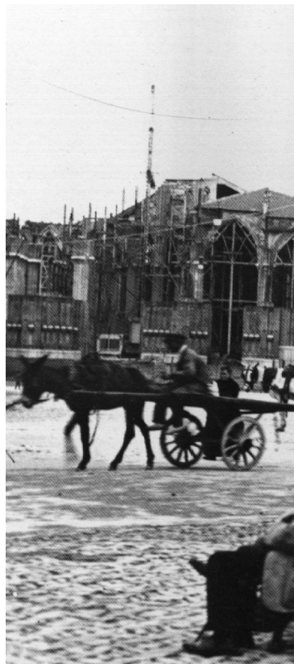
Calle Magdalena-calle magdalena-Catedral nueva en construcción
