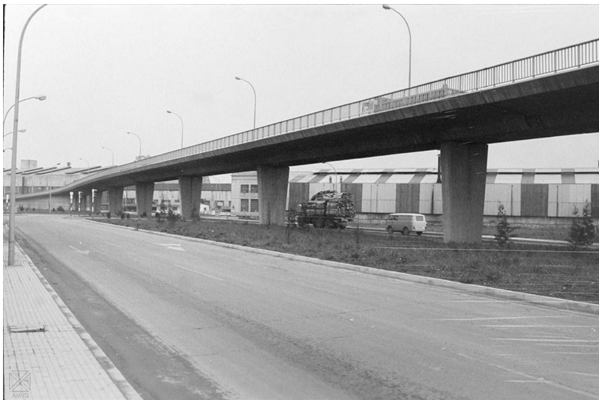
Calle Madrid. Puente Scalextric.
