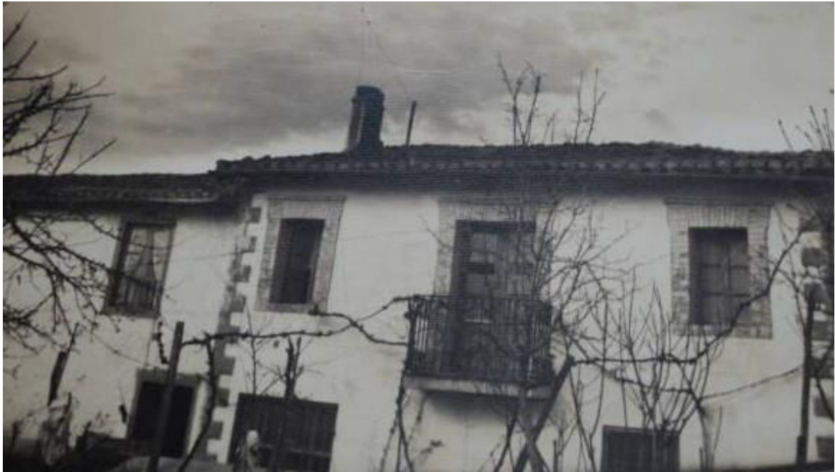
Vitoria Gasteiz, esta casa estaba en el Portal de Arriaga, antes del derribo, pertenecía a la familia Peciña.
