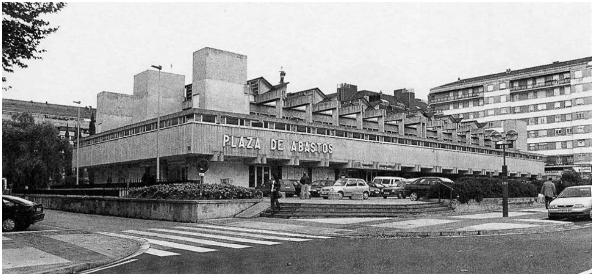
Calle plaza de Santa Bárbara, obra del arquitecto Angel Esteve en 1971. Plaza de abastos vieja
