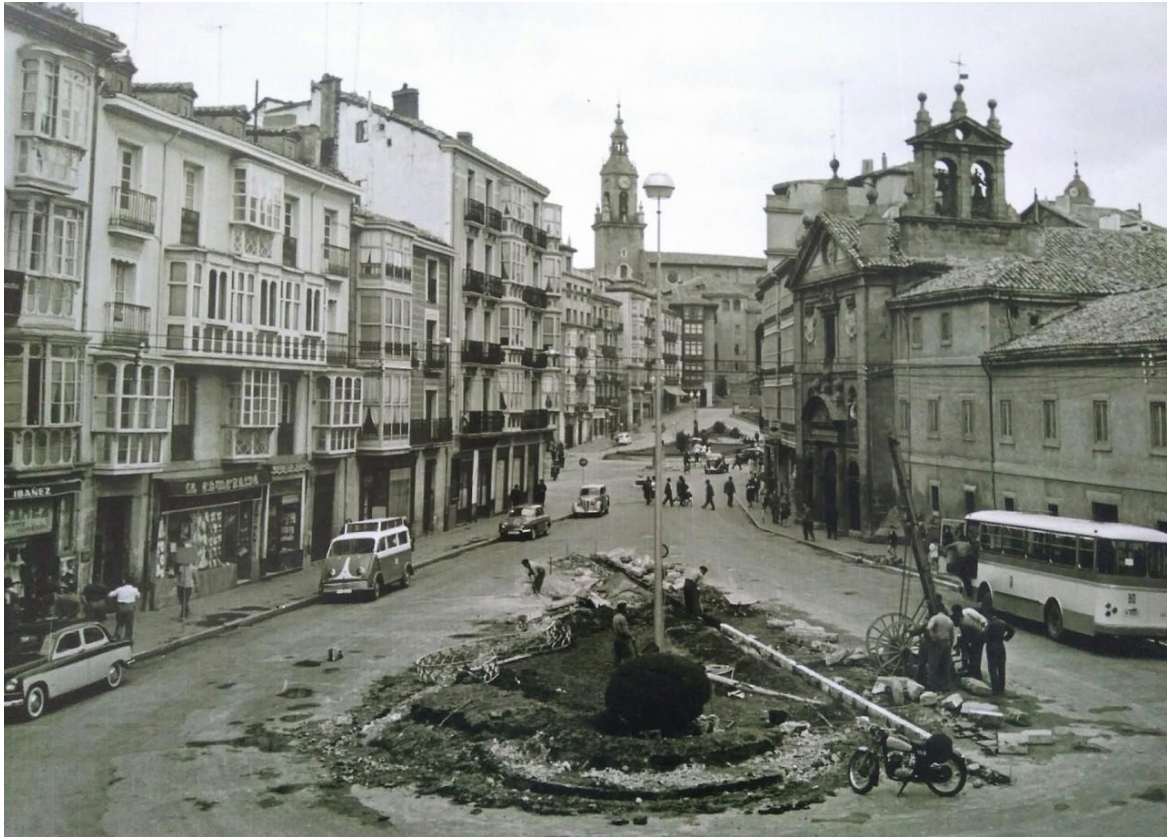
Calle Plaza General Loma.
