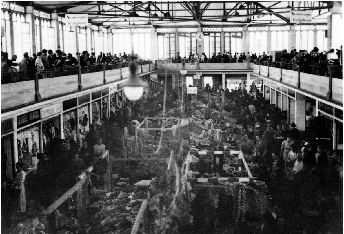
Calle Postas-Fueros-Manuel Iradier.-Interior de la Plaza de Abastos
