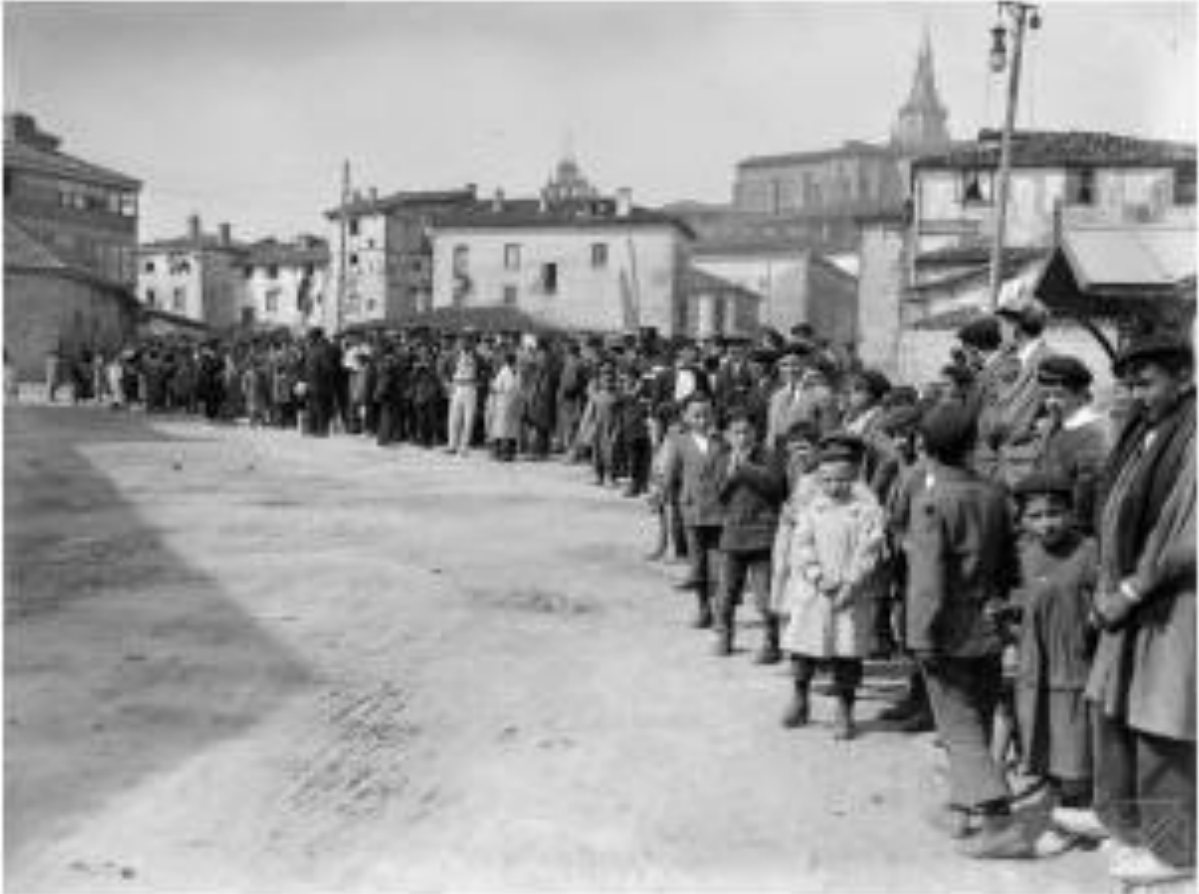
Portal de Urbina – Hoy portal de Legutiano
