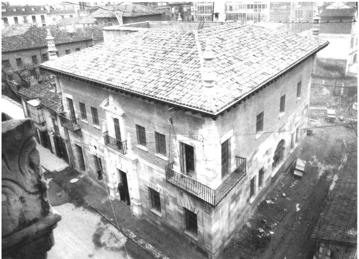
Calle postas.-Teléfono en construcción
