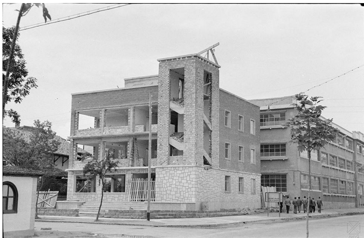
Calle Portal de Castilla.-junio 1957-caseta del fielato
