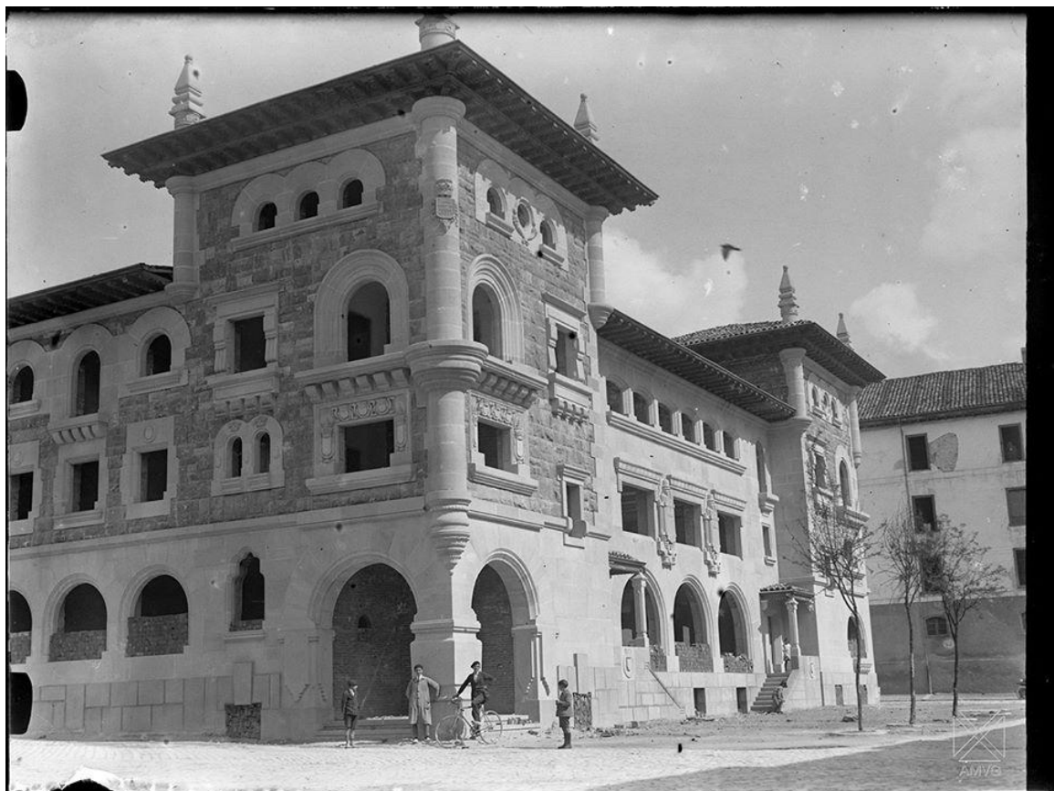
Calle postas.-edificio de Correos en construcción.1925
