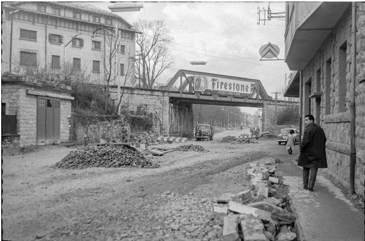
Calle Portal de Castilla en obras.-15-2-1962
