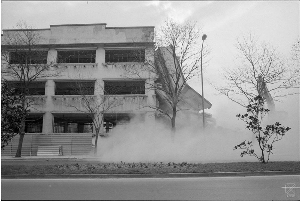
Calle portal de castilla.-derribo de la fábrica de Areitio.-10-2-1993
