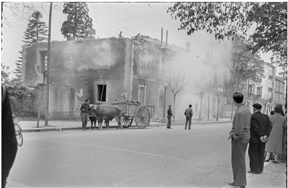
Calle Ramón y Cajal. Derribando edificios en el lugar en donde se construirá El hotel Canciller Ayala.1956
