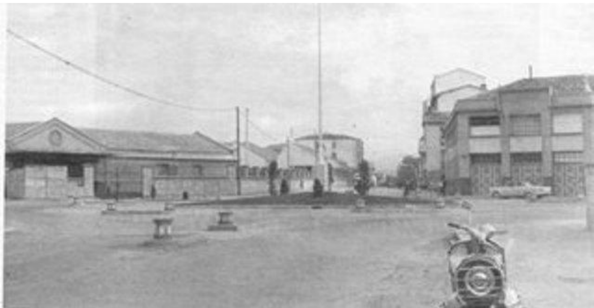
Calle portal de villarreal-esquina del matadero
