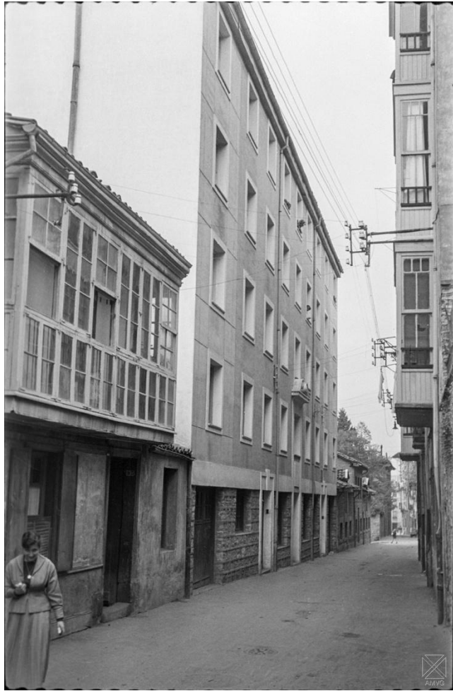
Vitoria-Gasteiz, calle Zapatería.1956
