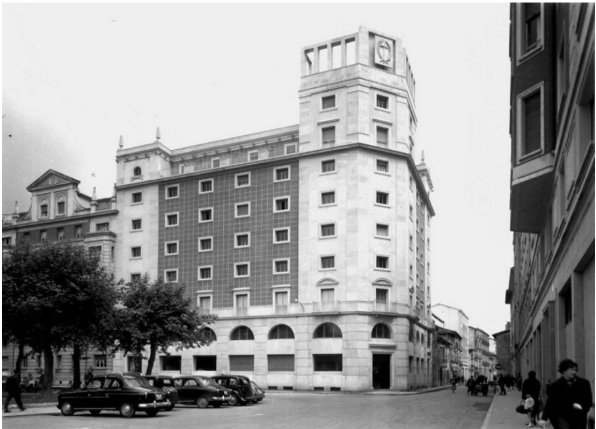
Calle Samaniego. Edificio sindicatos-años 50
