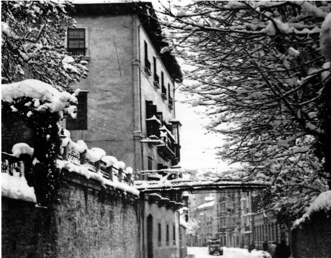
Calle Siervas de Jesús. Puente de la Marquesa nevado en febrero de 1962.
