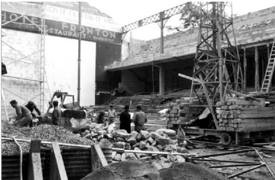
Calle san Prudencio.- Demolición del hotel frontón
