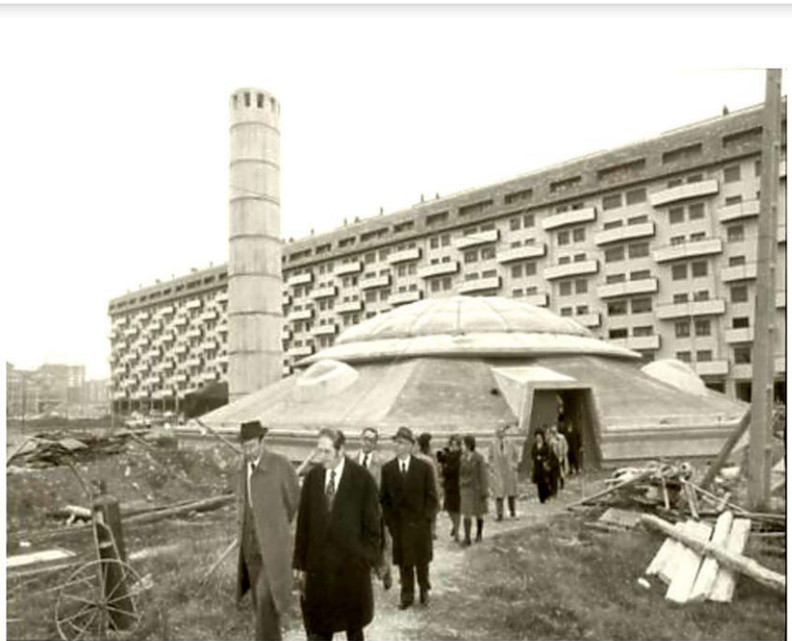
Calderas de calefacción.
