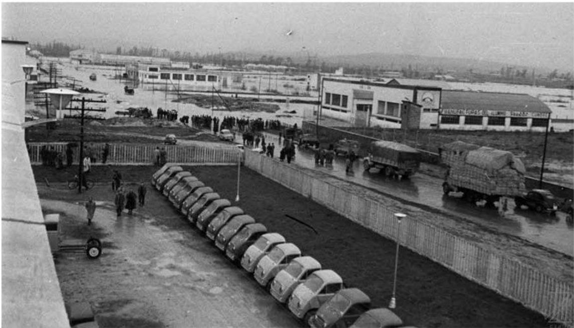
Inundaciones en el Polígono Industrial Gamarra-Betoño. Vemos cortada la calle Portal de Betoño, con la factoría de INAUTO en primer plano. 30 de diciembre de 1960. Foto Santiago Arina y Albizu. AMVG.
