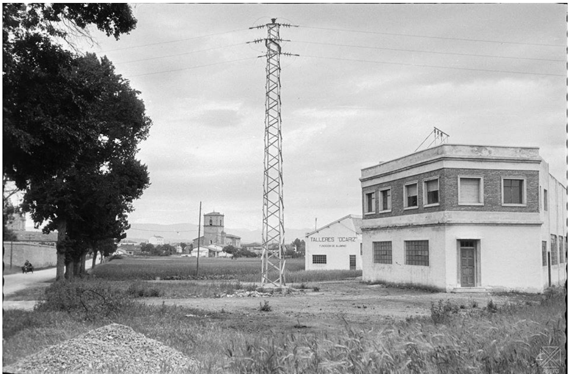
Barrio de Betoño. 19-4-1958
