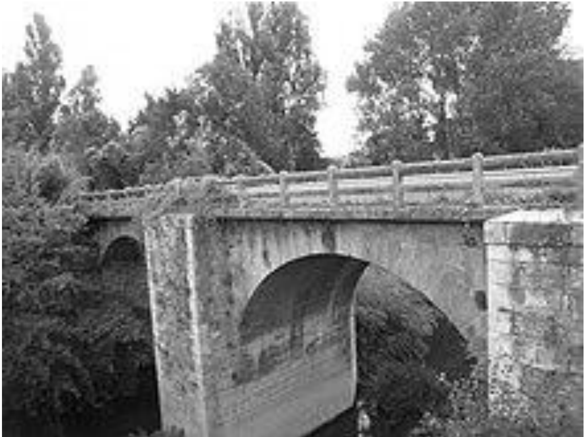
Barrio de Abechuco.- puente agosto_de_2015
