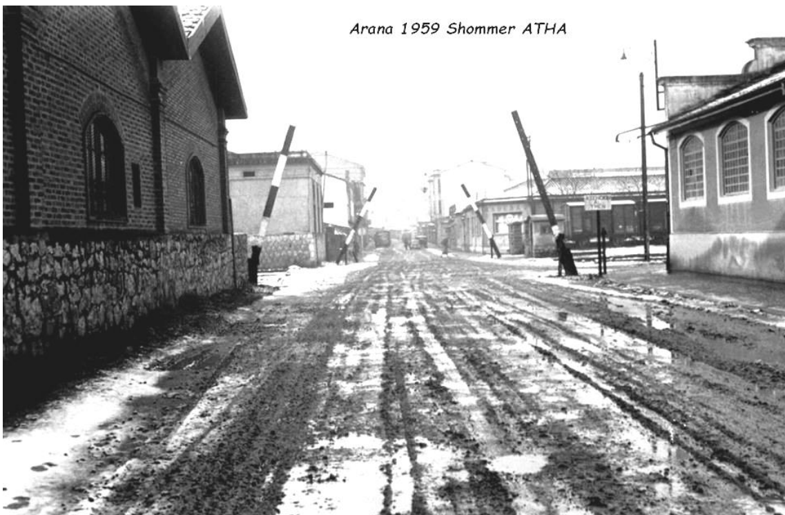
Barrio de Arana-1959-El ferrocarril Vasco Navarro, o Anglo Vasco, de vía estrecha y electrificada
