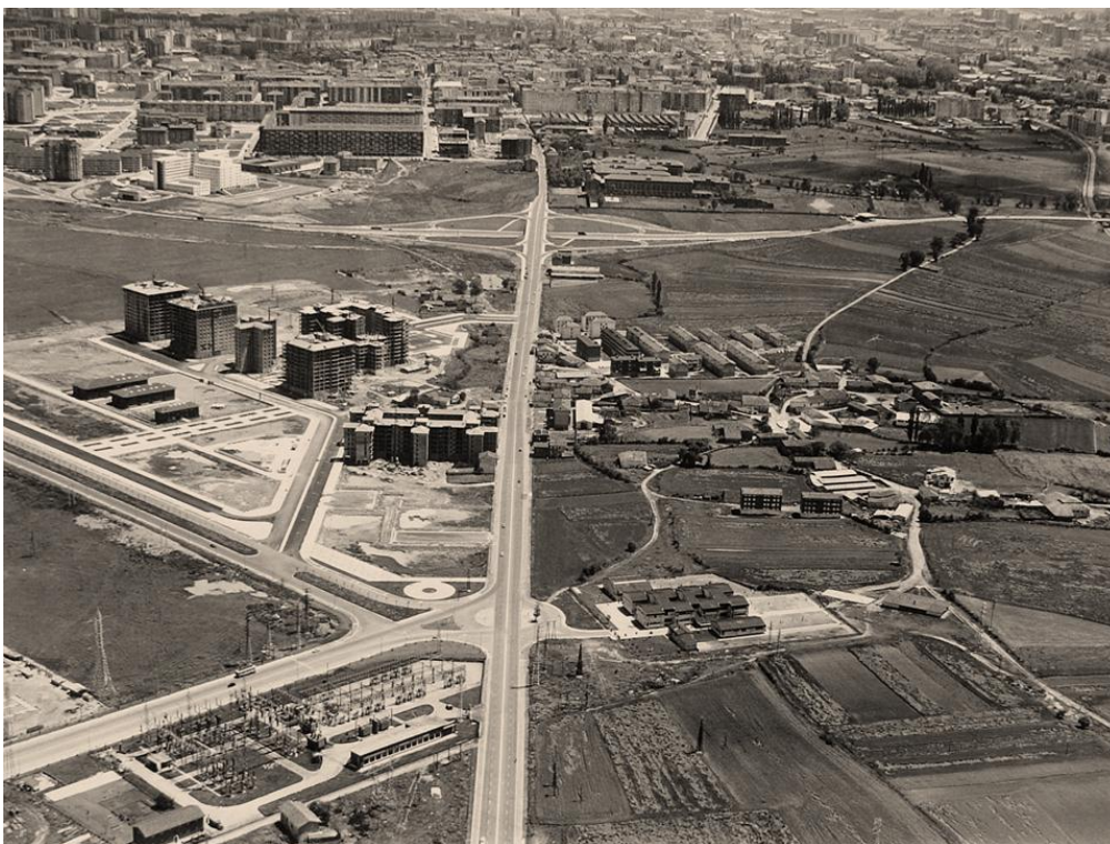
Barrio de Sansomendi en construcción.
