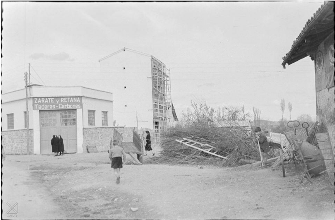
Barrio de Betoño. 24-3-1957
