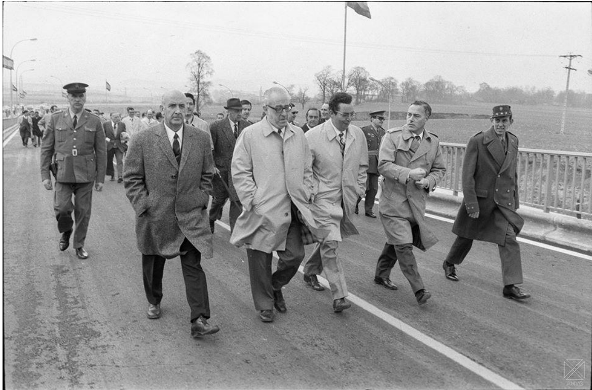
Barrio de Zaramaga. Inauguración del paso elevado para vehículos Conocido como Scalectrix.-15-4-1972
