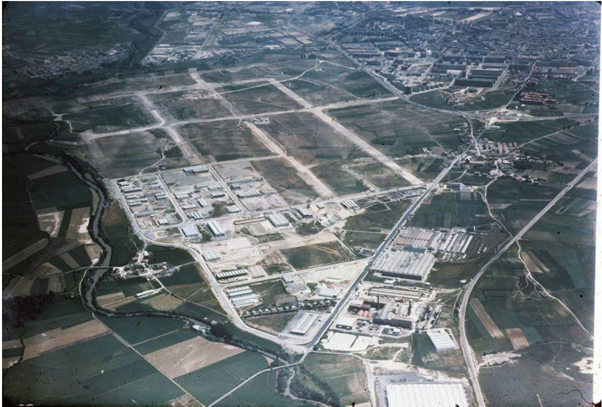
Barrio de Ali-Gobeo Noviembre de 1975.panorámica de la Zona industrial
