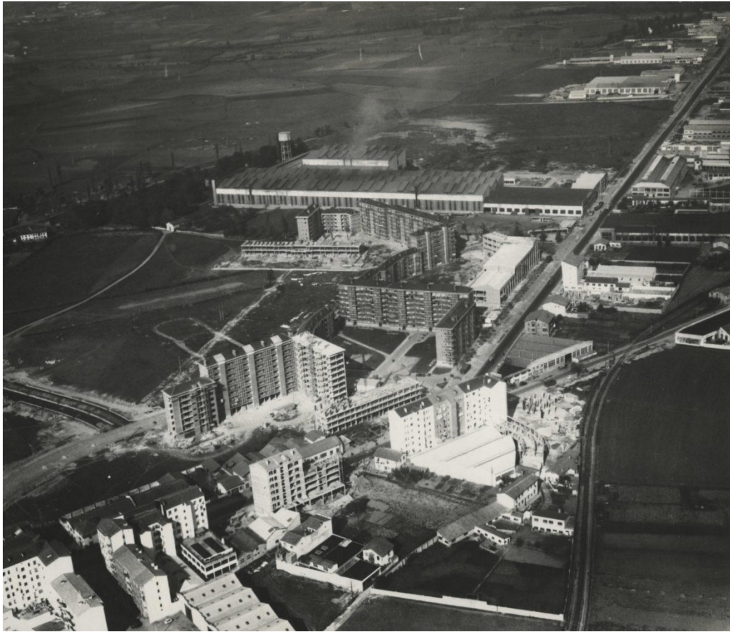
Barrio de Zaramaga. Vista aérea.
