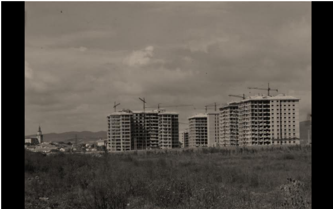
Barrio de Sansomendi en construcción
