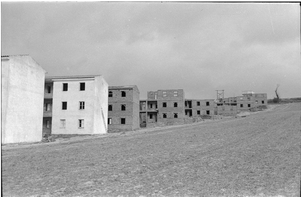
Barrio de Errekalear en construcción.-1959
