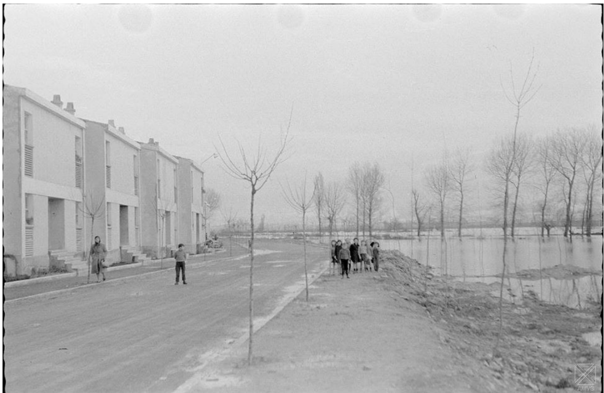
Inundaciones en el barrio de Abechuco.-23-4-1960
