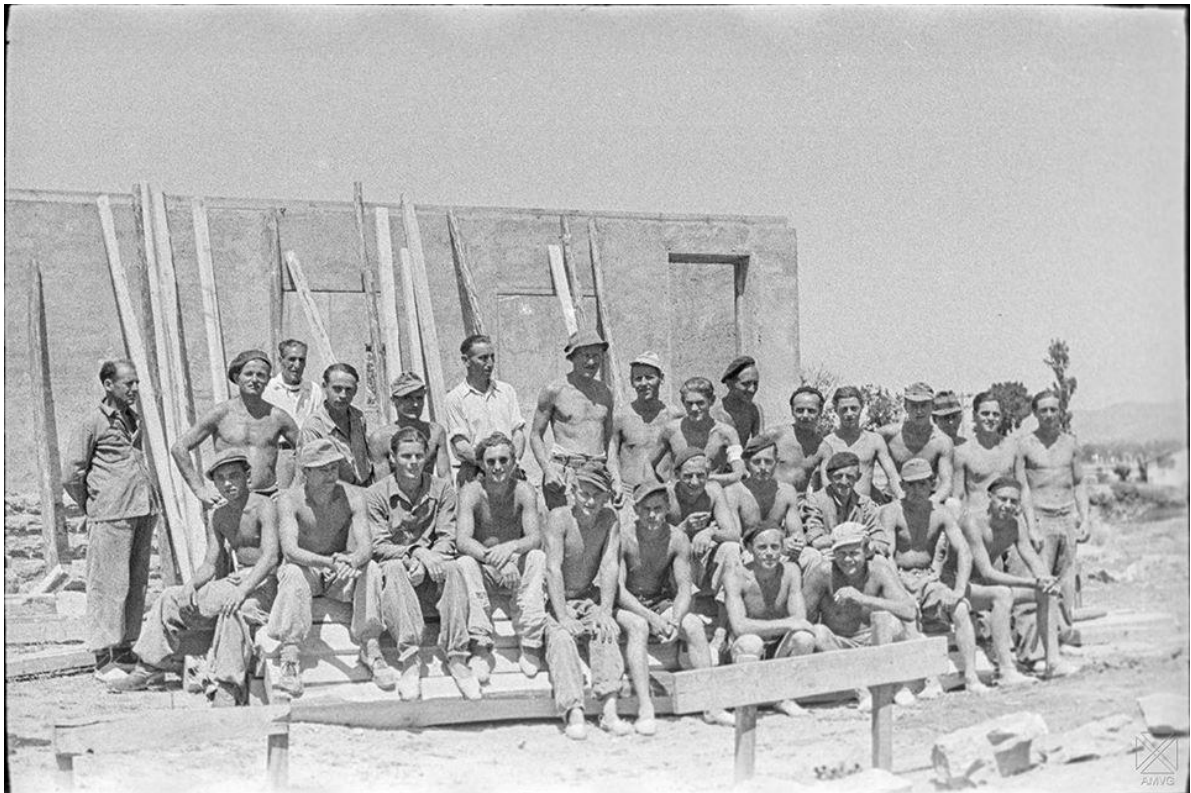
Barrio de Armentia.-obreros de la construcción.-julio 1947
