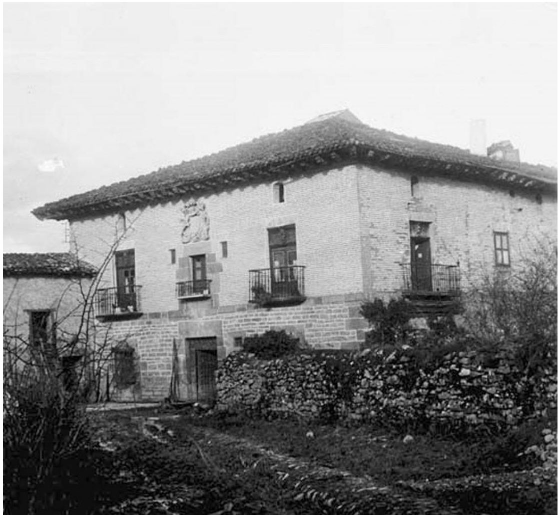
Barrio de Betoño. 1940-60
