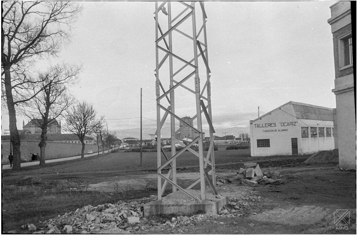
Barrio de Betoño. 6-1-1958
