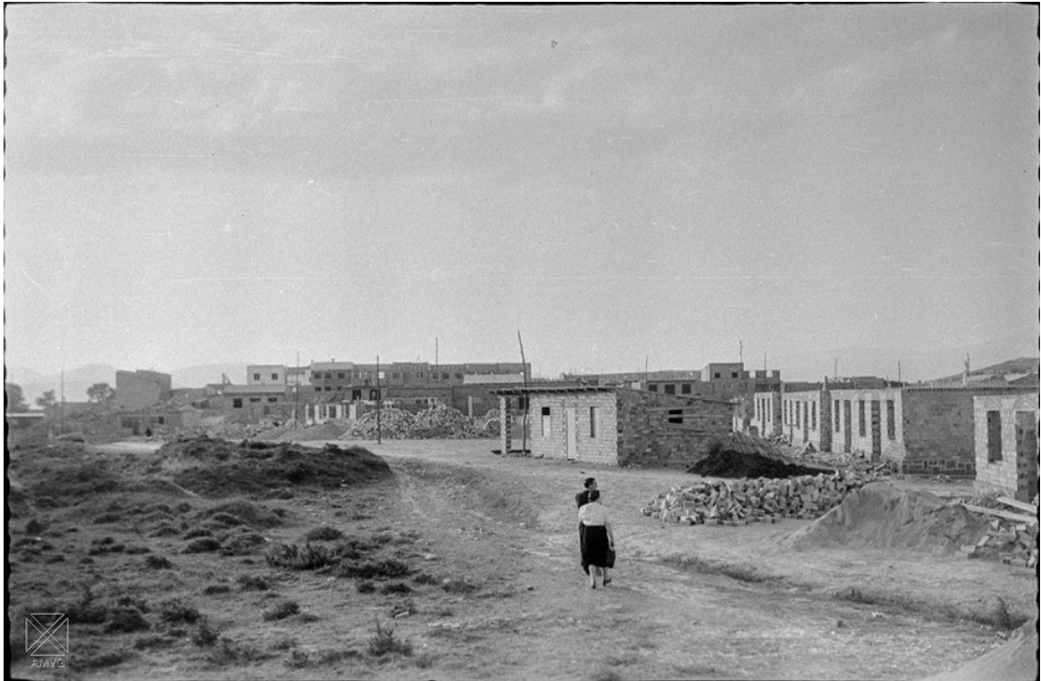
Barrio de Abechuco en construcción.7-9-1962
