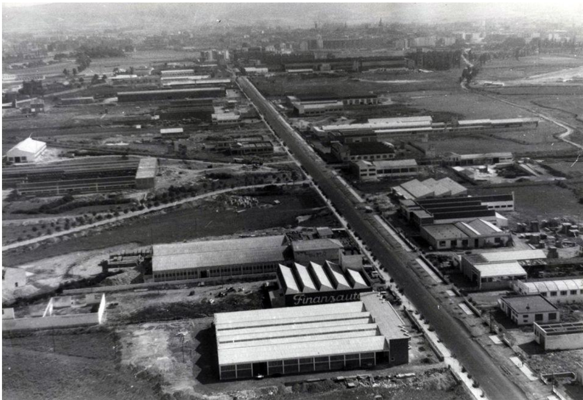
Hacia 1965. Vista panorámica de la zona Industrial de Betoño.
